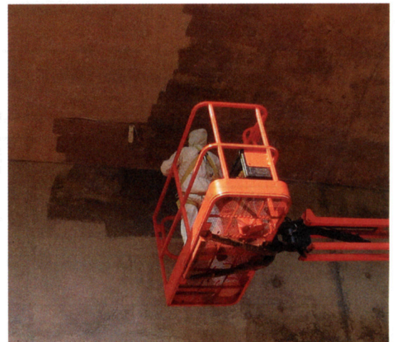
Foi aplicado o produto com duas demãos, sendo a primeira um primer do próprio verniz
