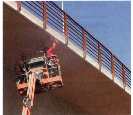
Primeiro, é feito o preparo para a aplicação do produto, com a lixagem e o estucamento
