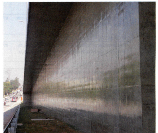
No caso desta obra, foi usada a opção brilhante, que também impede a penetração de tintas
