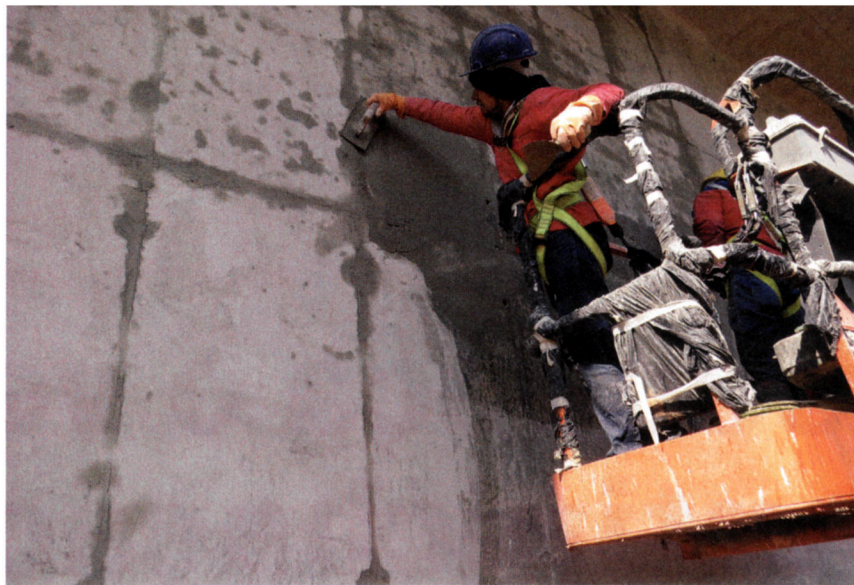
Etapa de lixamento abrasivo, com lixa grana 36, a fim de retirar a massinha do cimento superficial, poeira ou sujeira, para que a superfície esteja limpa e seca para receber o verniz
