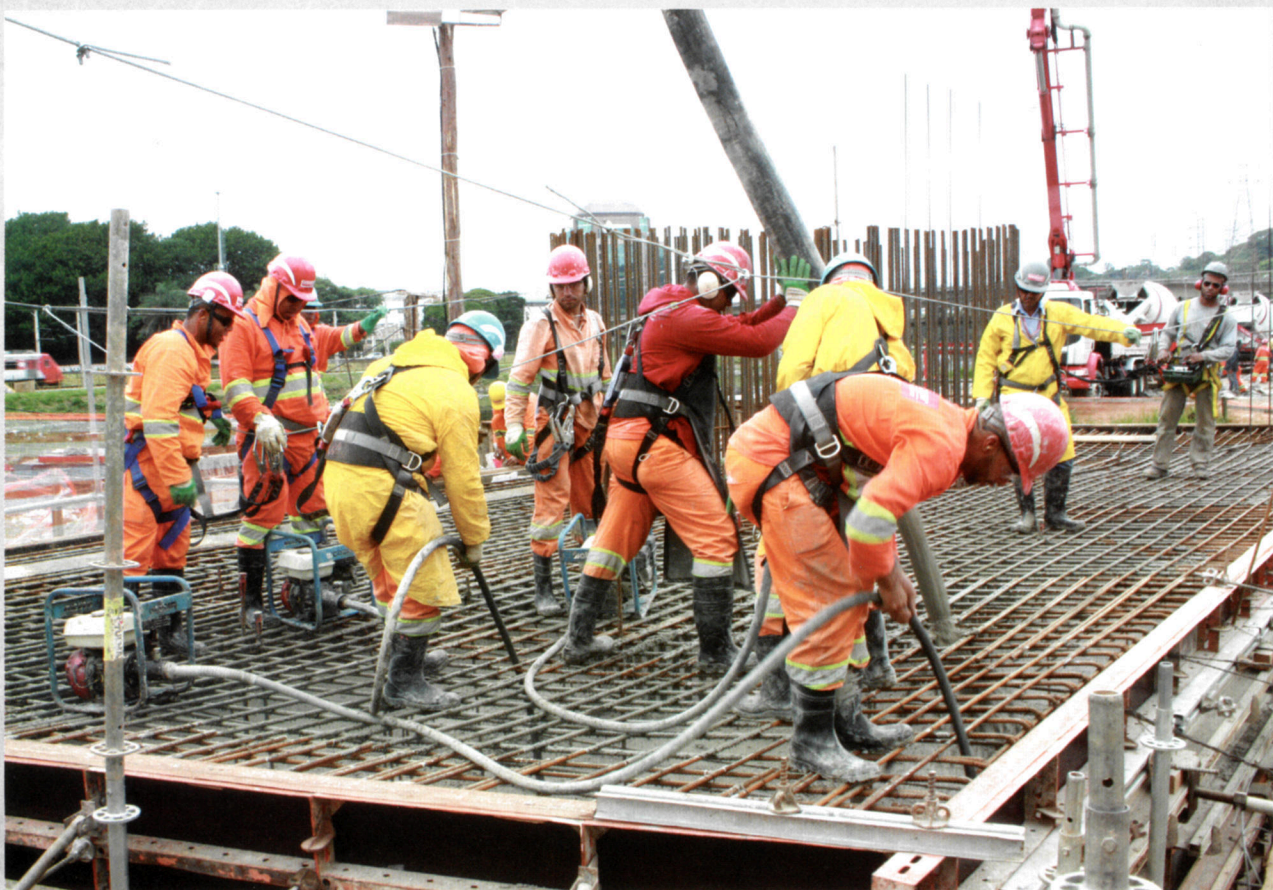
Pedreiros trabalham na concretagem do Apoio 4.
