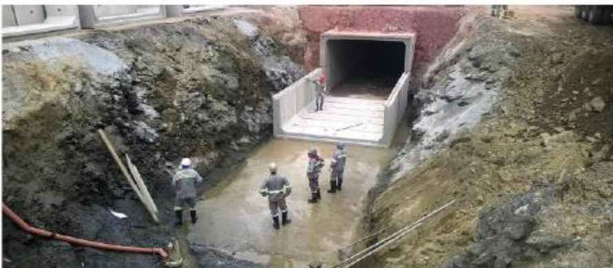
Seja o trecho do canal aberto ou fechado, o processo de canalização é composto pela etapa de escavação, fundação em concreto ciclópico, lançamento e consolidação das peças pré-moldadas
