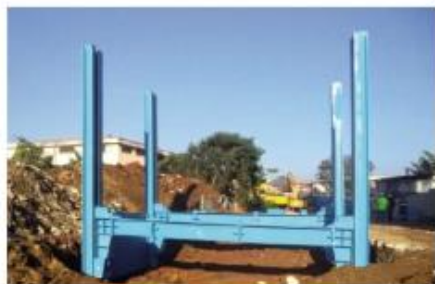
Vista do primeiro módulo do DSR em seu offset de escavação
