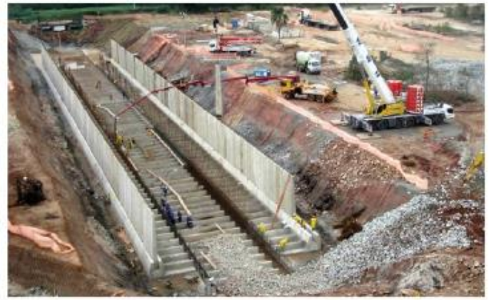
O lançamento dos pré-moldados foi feito com uso de guindastes. Depois de colocadas as paredes, a brita e o concreto foram lançados para consolidação do fundo. Em alguns casos, a depender da largura e da configuração do trecho, as sapatas foram unidas por vigas PI pré-moldadas intermediárias
