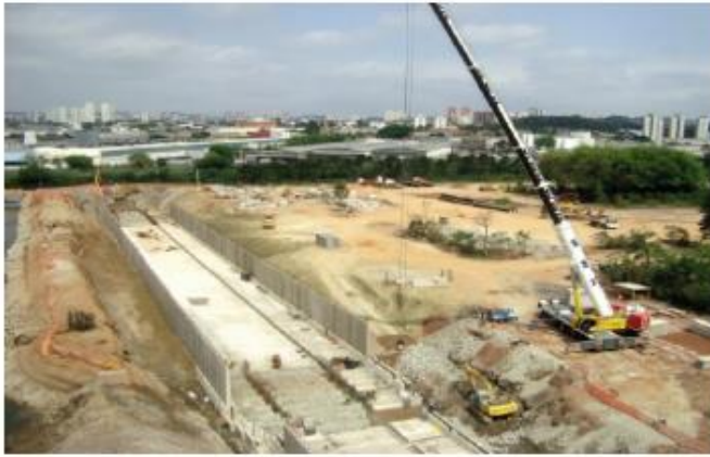
O lançamento dos pré-moldados foi feito com uso de guindastes. Depois de colocadas as paredes, a brita e o concreto foram lançados para consolidação do fundo. Em alguns casos, a depender da largura e da configuração do trecho, as sapatas foram unidas por vigas PI pré-moldadas intermediárias
