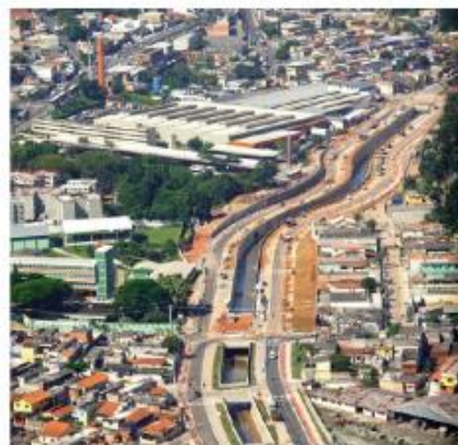
Antes da obra, o córrego Ponte Baixa estava em processo de assoreamento, o que intensificava as enchentes. A retificação e canalização exigiram o afastamento das edificações, com consequentes desapropriações ao longo de todo o trecho, dando origem à Avenida Luiz Gushiken
