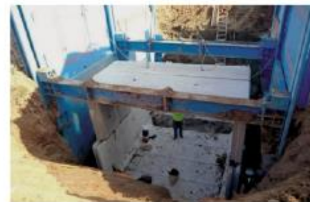
Lançamento da aduelas no primeiro módulo DSR
