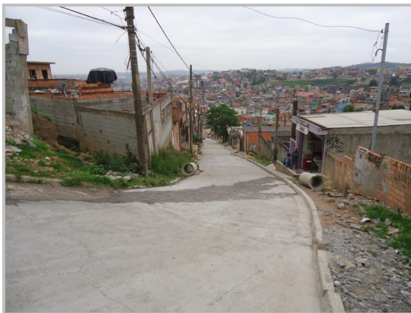
Execução da pavimentação – Rua Flamboyant
