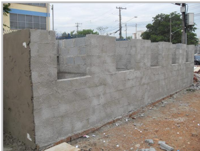
Alvenaria de elevação das lixeiras – Condomínio 4
