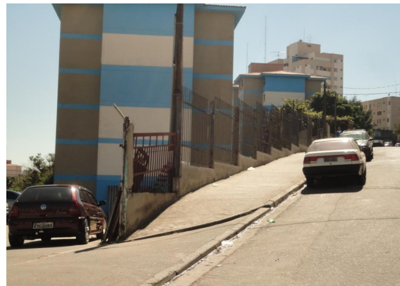
Gerenciamento de Obras 3Rs: São Domingos
