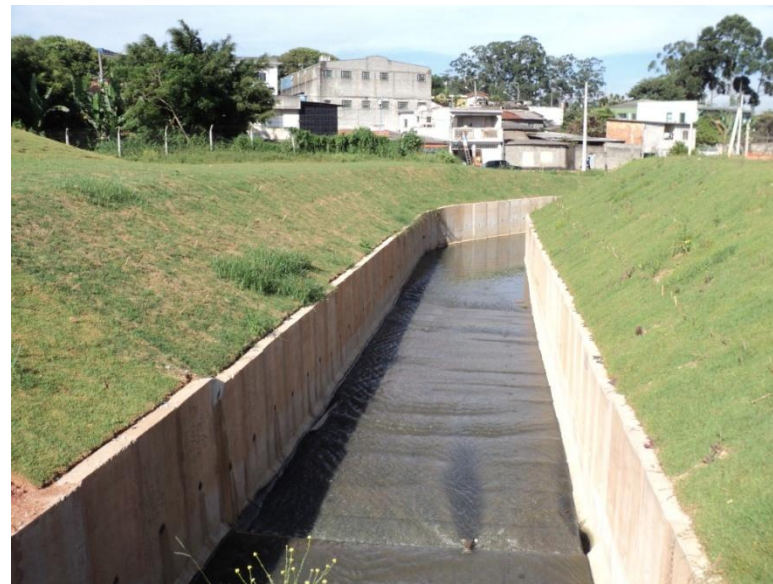
Cidade Júlia – Canalização Córrego Apucás
