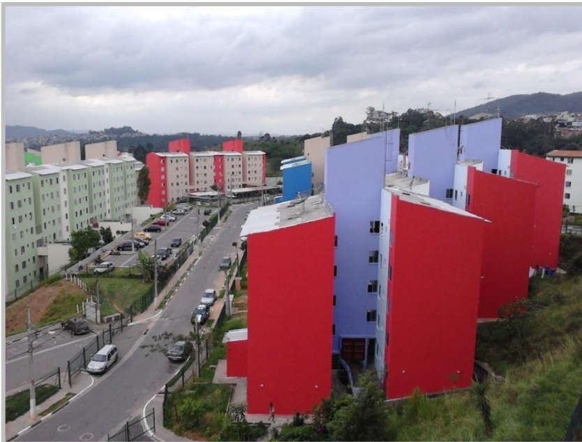
Vista – Condomínio G
