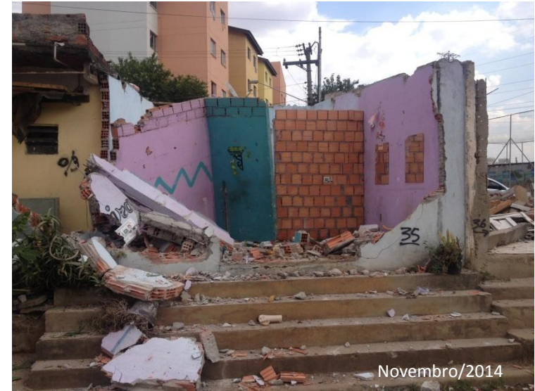
Chácara Bela Vista – Acompanhamento de remoções em área comum do empreendimento
