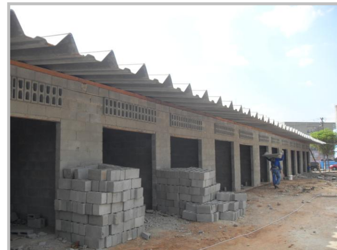
Execução da Cobertura – Centro Comercial – Fase 2
