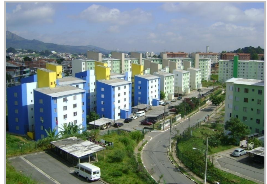
Gerenciamento de Obras : 3R's – Lote C – City Jaraguá
