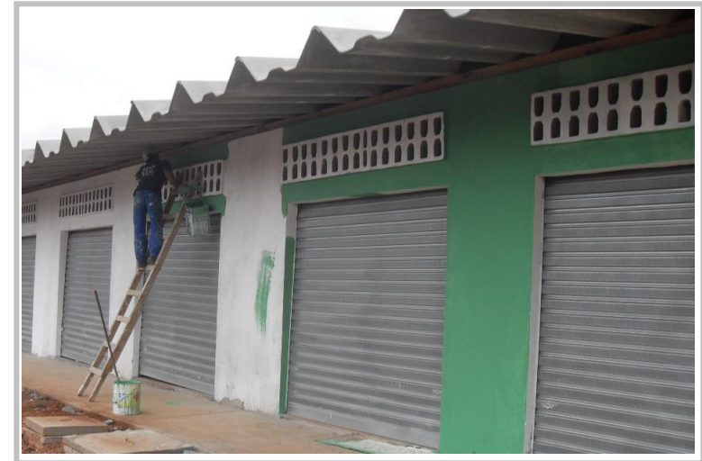
Acabamentos externos - Centro comercial – Fase 1
