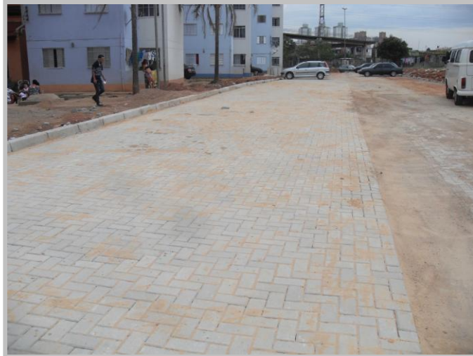
Pavimentação com piso intertravado – Condomínio 3
