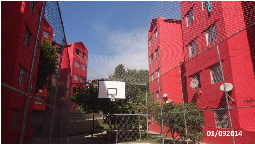
Campo Grande – Concluídos os serviços incluída a vistoria do corpo de bombeiros
