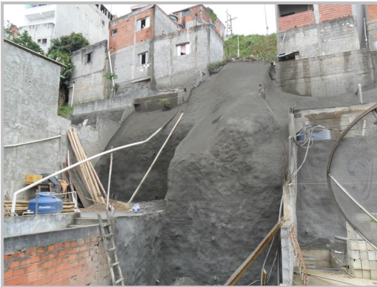
Execução do solo grampeado da Rua Faisão
