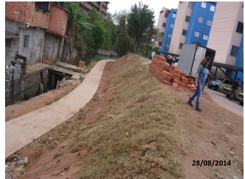
Parque Otero – Concretagem de passeio.
