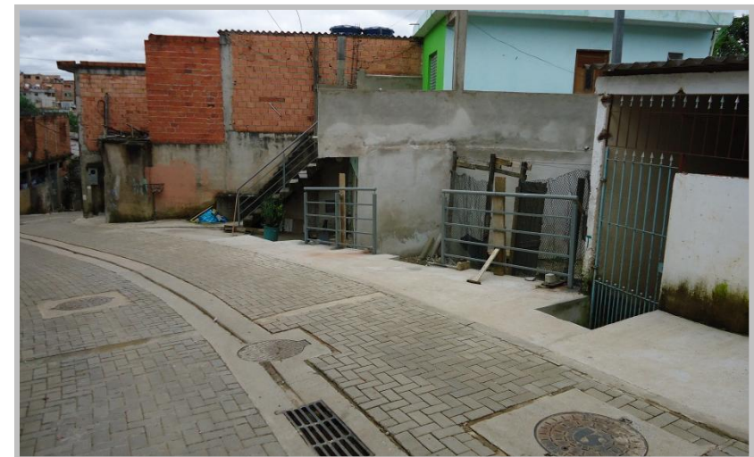
Pabreu / Prainha – Rua Vitória - Pavimento Intertravado
