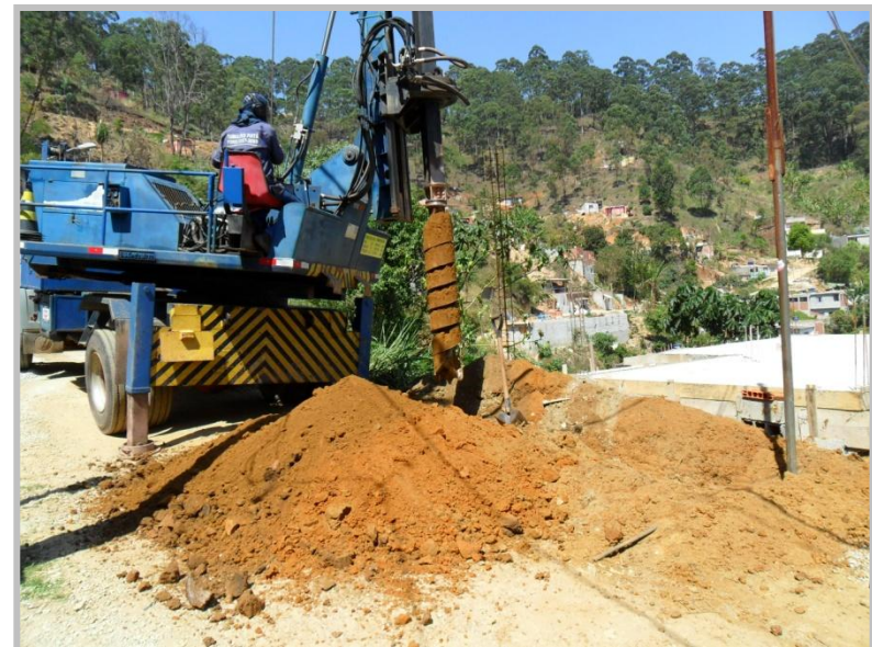
Execução da contenção da Rua Zabelê
