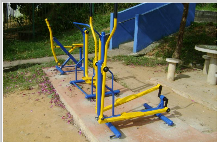
Instalação de equipamentos de ginástica
