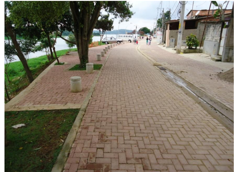
Pabreu / Prainha – Rua Beira Rio – Drenagem, pavimentação e urbanismo
