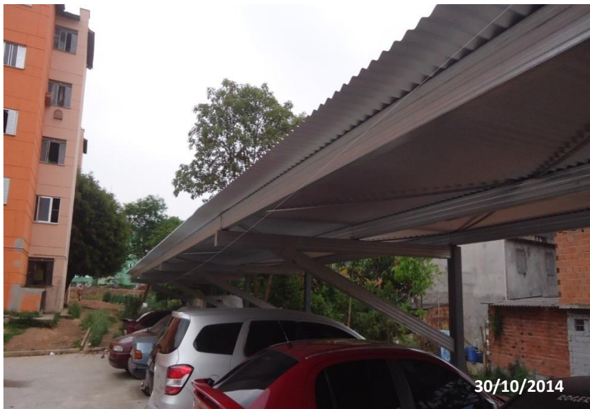
Parque Otero – Quadra A – Concluídos os serviços de lavagem de fachada, piso e montagem da estrutura das garagens.
