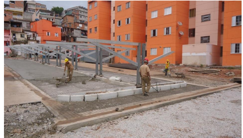
Parque Otero - Quadra B conclusão do telhado, piso de concreto e montagem da estrutura e cobertura das garagens.
