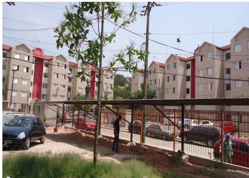
Jd Arpoador – Abrigo para carros e instalação de gradil .
