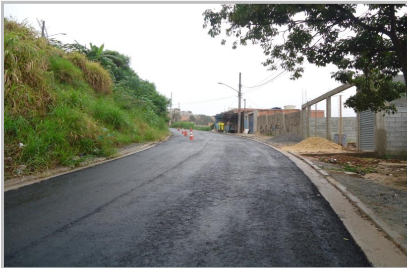
Parque das Flores- Pavimentação – Av. Adutora do Rio das Pedras
