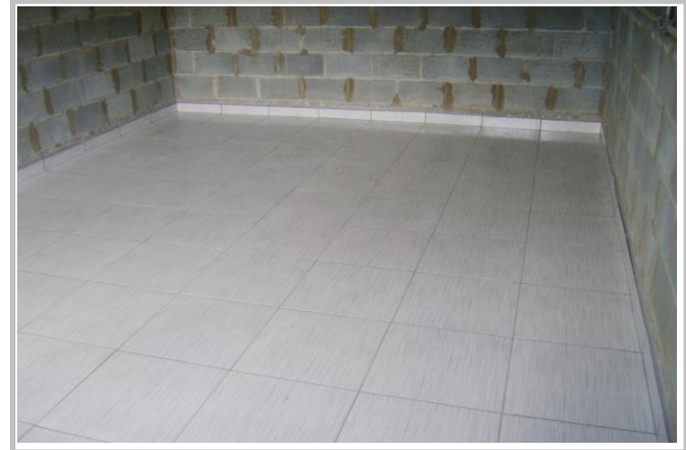
Colocação de pisos no Centro de Convivência
