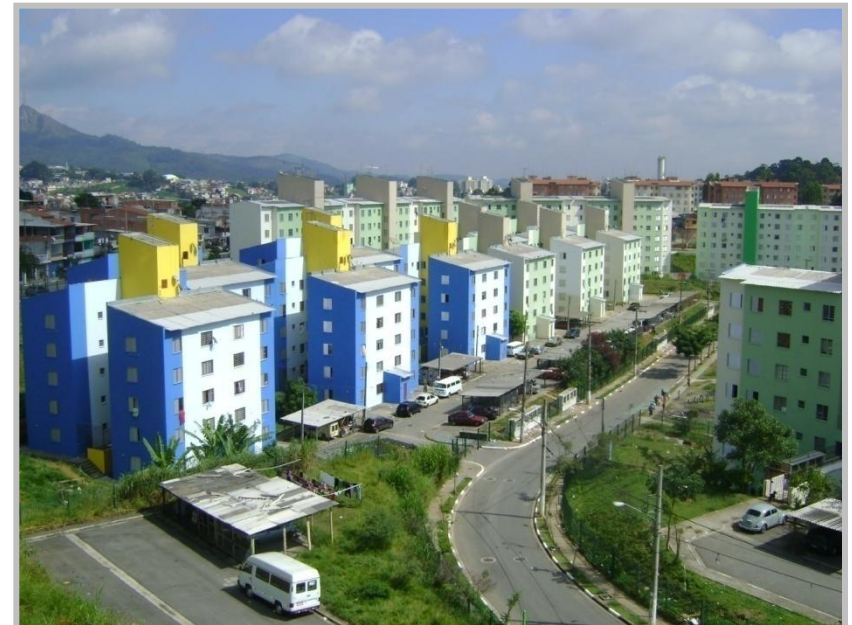
Vista – Condomínios C e D
