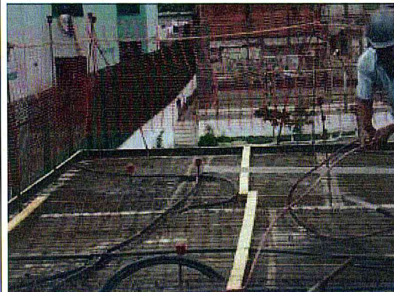
BLOCO 06: Concretagem da laje
