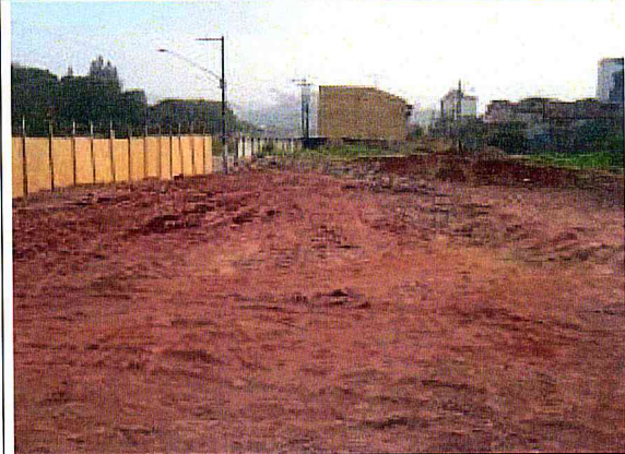
ÀREA DA OBRA. Aterro da área
