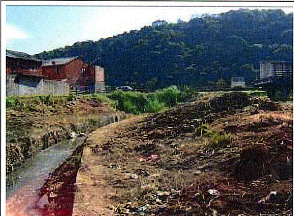
. CORREGO CANGUEIRAS.Limpeza da área
