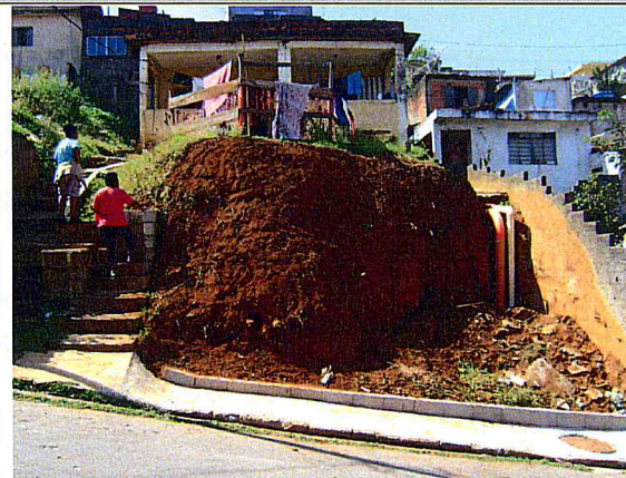
Drenagem e esgoto: Execução em andamento.
