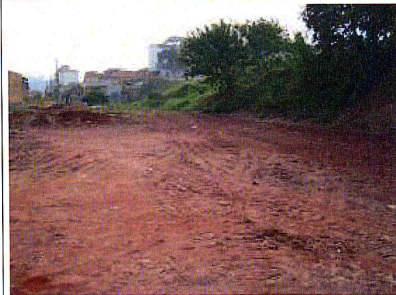
. ÀREA DA OBRA. . Aterro da área
