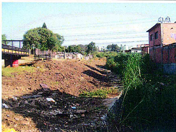
CORREGO CANGUEIRAS.Limpeza da área
