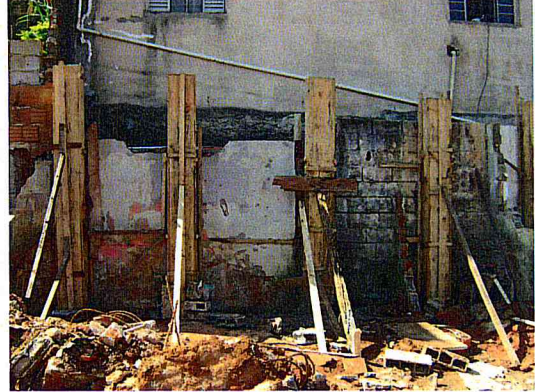
Contenções: Execução de pilares.
