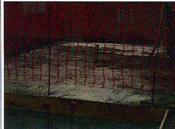
. BLOCO 06: Execução da concretagem e tela de proteção
