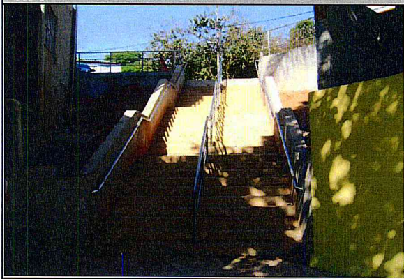
Escadaria: colocação dos corrimãos
