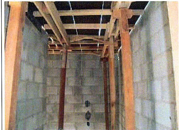
. BLOCO 06: escoramento da laje
