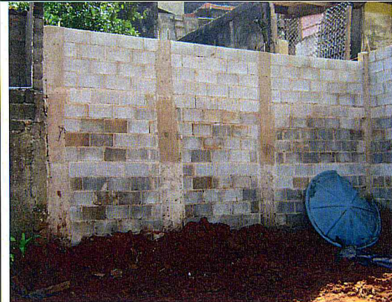
Contenções: Execução de alvenaria.
