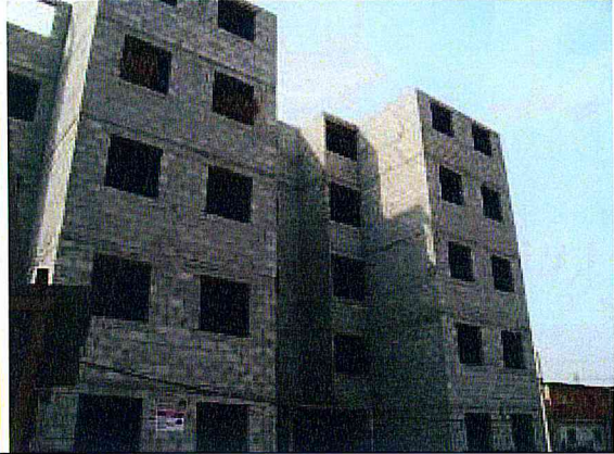
RUA EMILE ZOLA : execução da alvenaria
