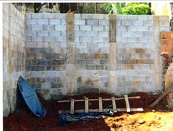
Contenções: Execução de alvenaria.
