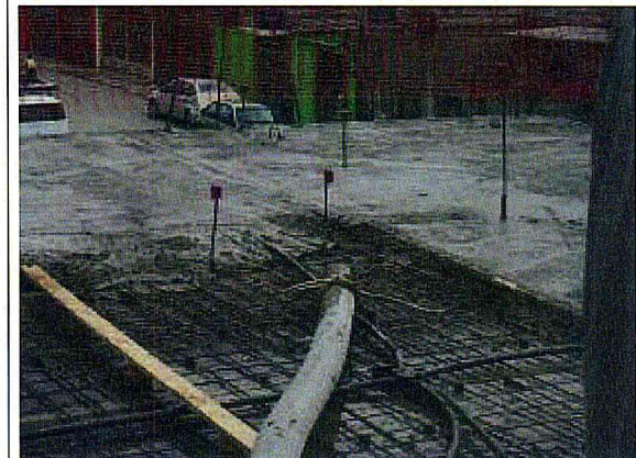
CÓRREGO CANGUEIRAS. Concretagem da laje
