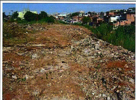
CORREGO CANGUEIRAS.Limpeza da área
