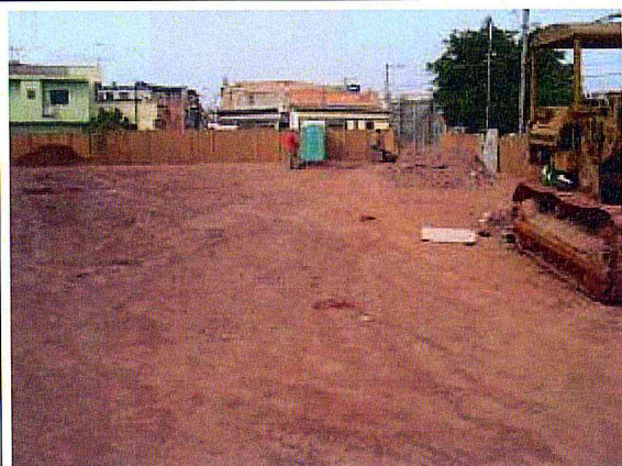
ÀREA DA OBRA. . . Aterro da área
