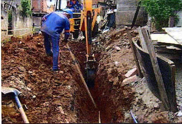
Esgoto: Escavação e colocação de tubos.
