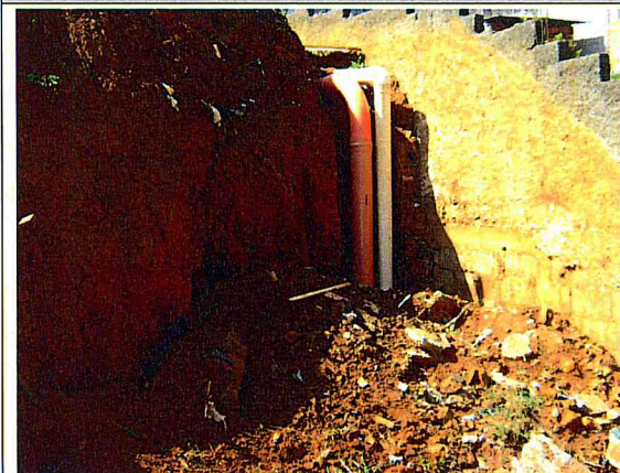
Drenagem e esgoto: Execução em andamento.
