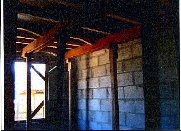
RUA EMILE ZOLA : escoramento da laje
