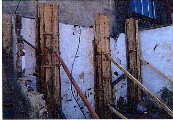
Contenções: Execução de pilares.
