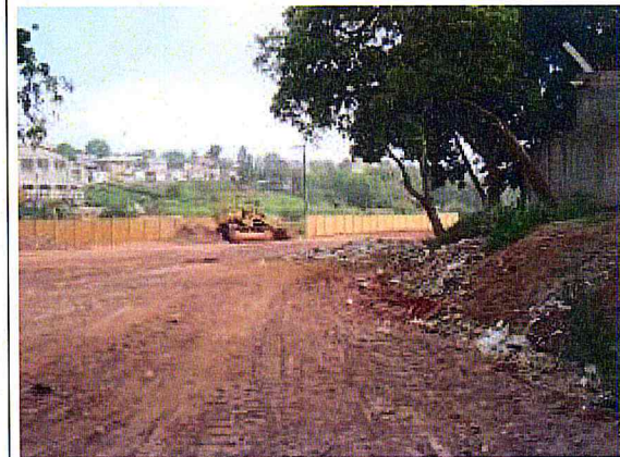
ÀREA DA OBRA. Aterro da área
