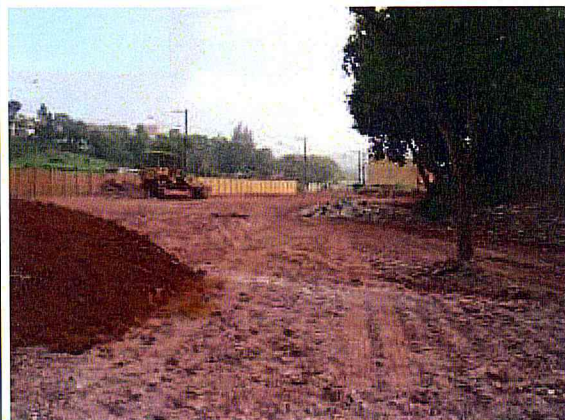
ÀREA DA OBRA. Aterro da área
