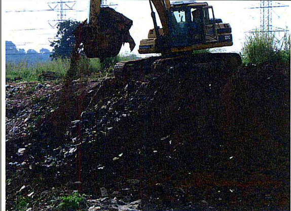
CORREGO CANGUEIRAS.Limpeza da área
