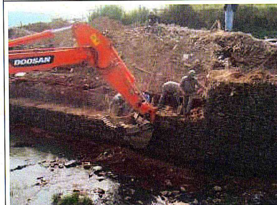
Córrego Bento Henriques : início dos serviços de remoção do gabião
