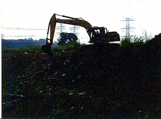
CORREGO CANGUEIRAS.Limpeza da área.
