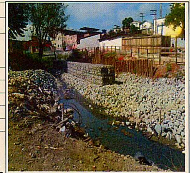
Sapé B: Serviços de Muro de Gabião
