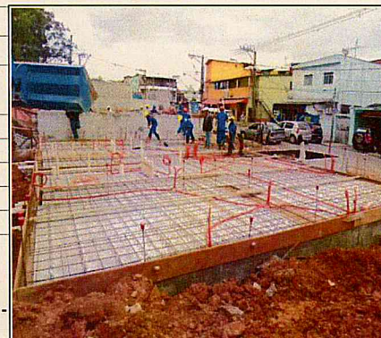
Gleba H: Concretagem da laje do piso Bloco 8
