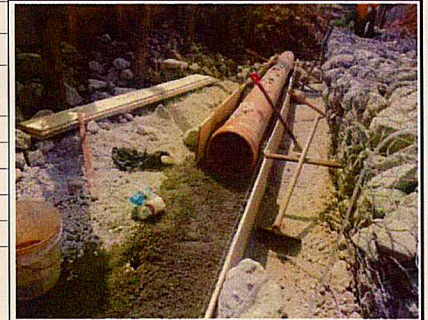
Sapé A: Assentamento de tubo coletor
