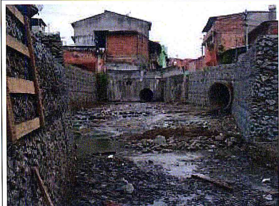
Córrego Bento Henriques : Construção do Gabião
