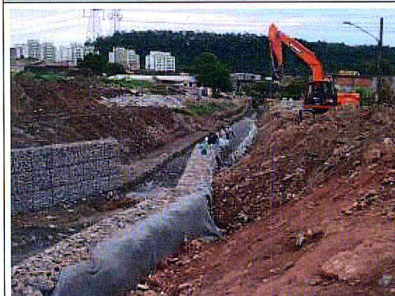
Córrego Bento Henriques : Construção do Gabião
