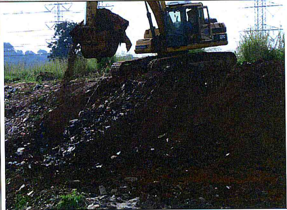
CORREGO CANGUEIRAS.Limpeza da área
