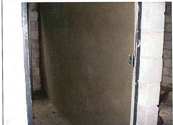
BLOCO 06 EXECUÇÃO DO REVESTIMENTO INTERNO
