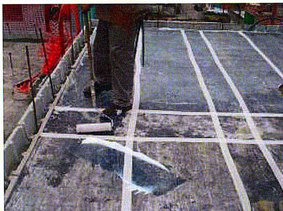
BLOCO 06: EXECUÇÃO DO RESERVATÓRIO
