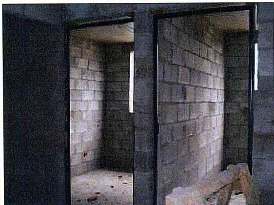
BLOCO 06: INSTALAÇÃO DAS ESQUADRIAS METÁLICAS
