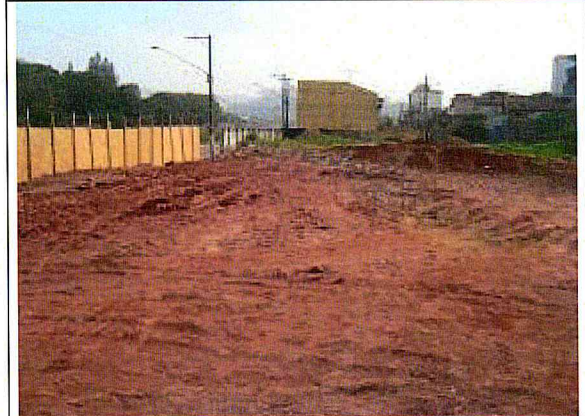
ÀREA DA OBRA. Aterro da área
