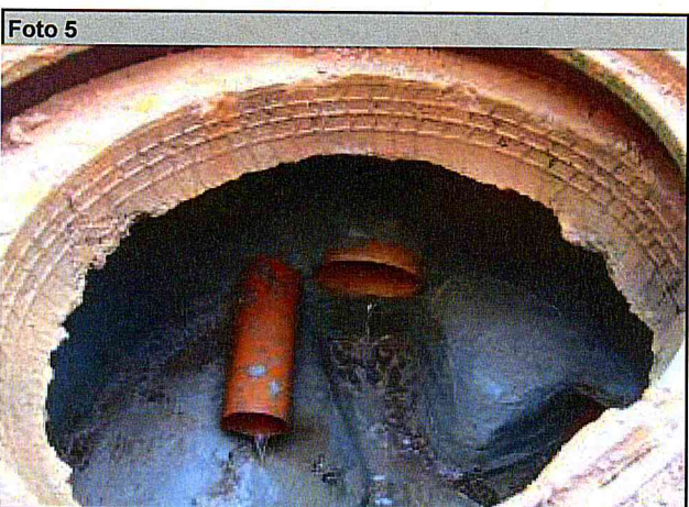
Esgoto: Execução de Pl's.
