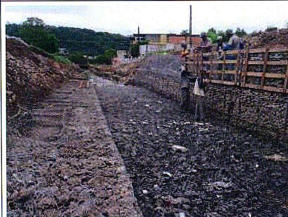
Córrego Bento Henriques : Construção do Gabião
