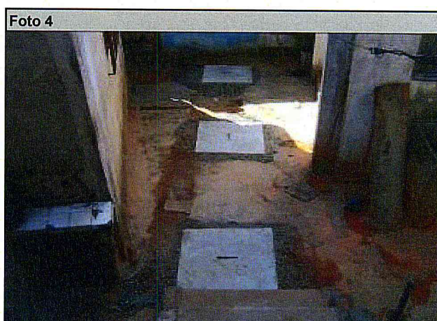
Esgoto: Execução de caixa de inspeção.
