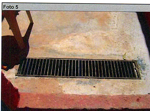
Drenagem: Execução de captação de AP.
