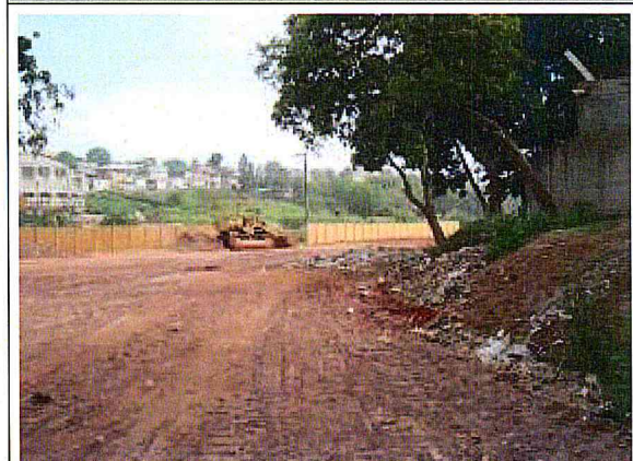
ÀREA DA OBRA. Aterro da área
