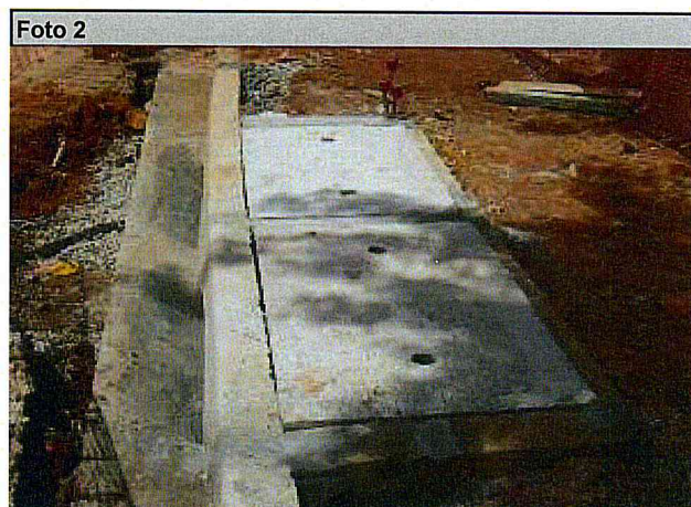
Drenagem: Execução de BL's.
