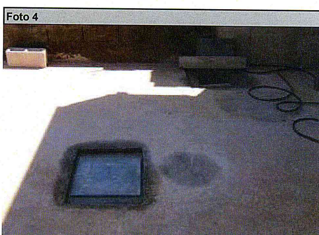
Drenagem: Execução de captação de AP.
