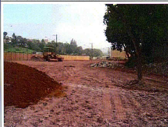
ÀREA DA OBRA. Aterro da área
