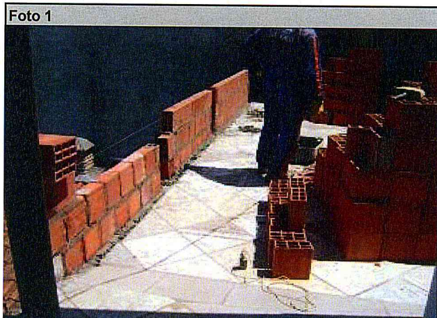
Drenagem: Execução de mureta para contenção de AP.
