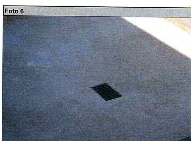
Drenagem: Execução de captação de AP.
