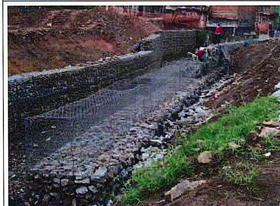
Córrego Bento Henriques : Construção do Gabião
