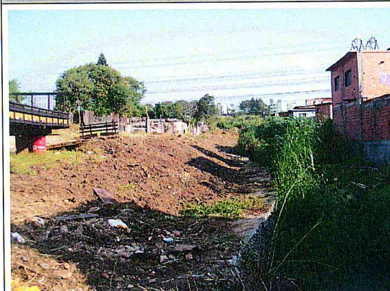
CORREGO CANGUEIRAS.Limpeza da área
