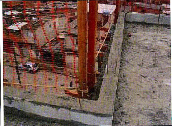
EXECUÇÃO DA ALVENARIA DO APOIO DO TELHADO
