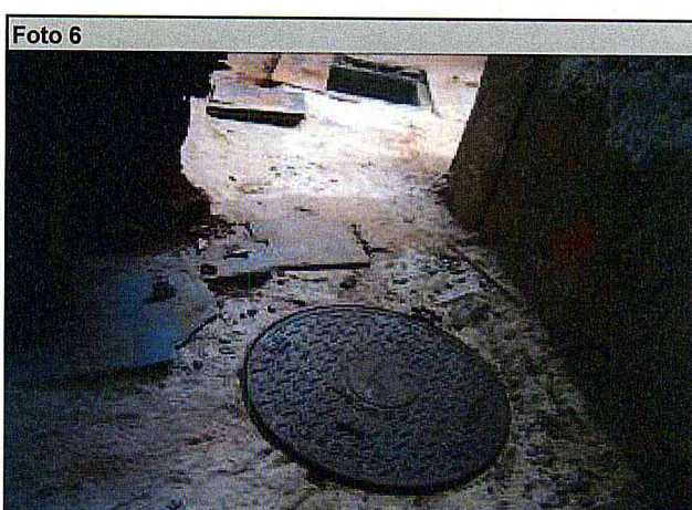
Esgoto: Execução de Pl's.
