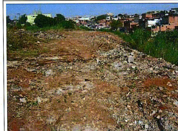
CORREGO CANGUEIRAS.Limpeza da área
