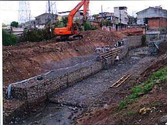
Córrego Bento Henriques : Construção do Gabião
