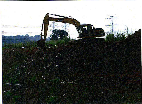
CORREGO CANGUEIRAS.Limpeza da área.
