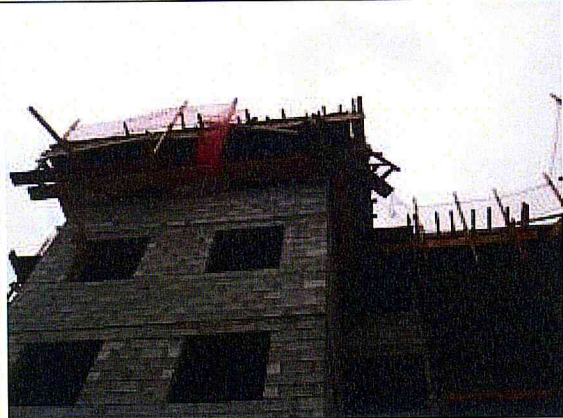
BLOCO 06 - CONCRETAGEM DA LAJE COBERTURA
