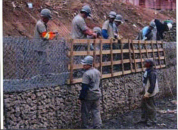
Córrego Bento Henriques : Construção do Gabião
