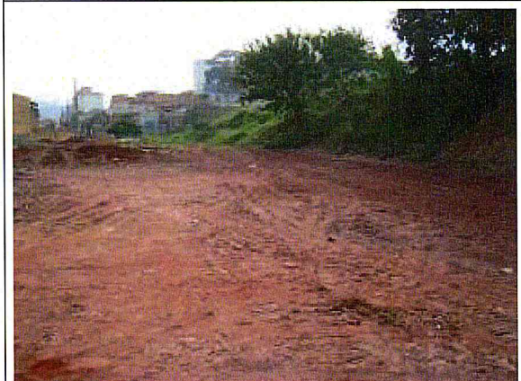
. ÀREA DA OBRA. . Aterro da área
