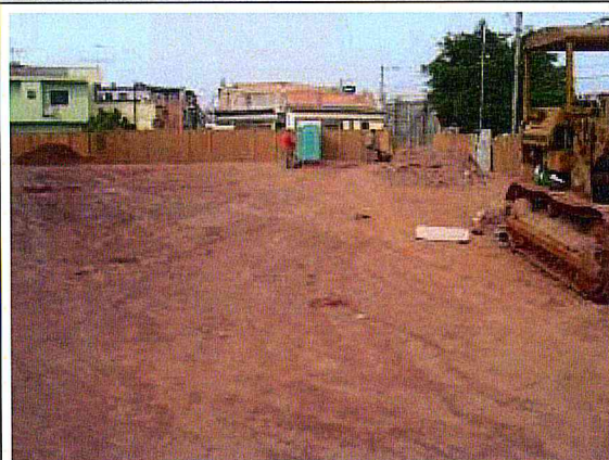
ÀREA DA OBRA. . . Aterro da área
