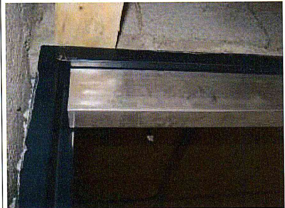
BLOCO 06: INSTALAÇÃO DAS ESQUADRIAS METÁLICAS.
