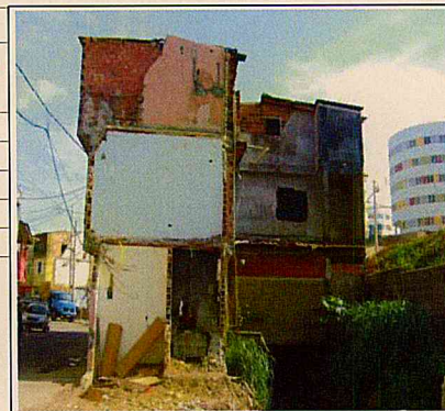
Gaivotas: Demolição de moradias
