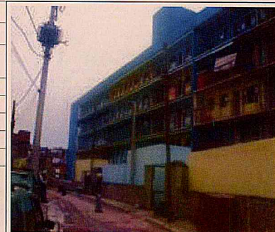
Cidade Azul: Blocos A e B em andamento.
