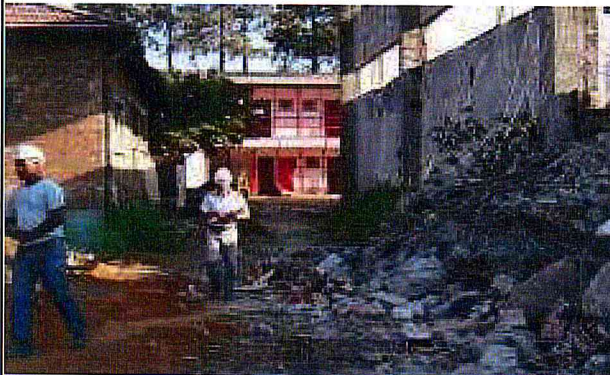
GALPÃO E7 - Demolição
