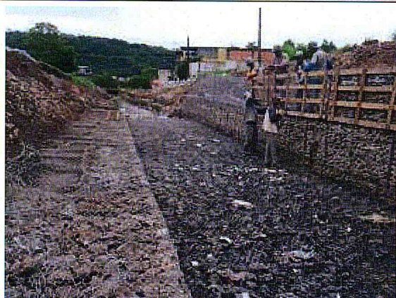
Córrego Bento Henriques : Construção do Gabião
