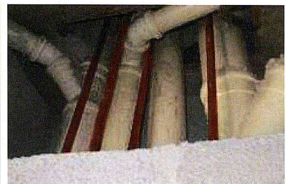
Execução prumada esgoto e gás no shaft do apto
