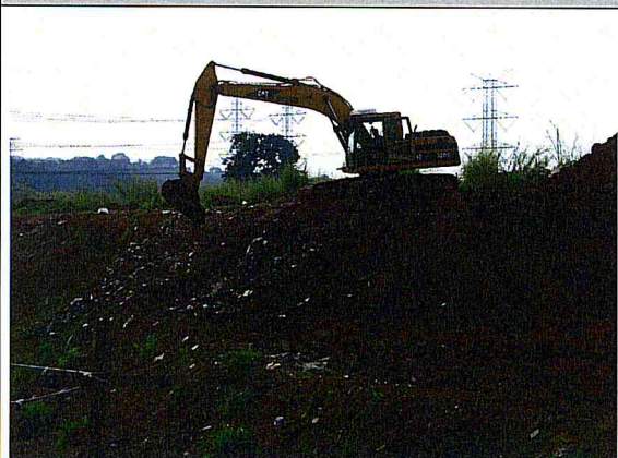
CORREGO CANGUEIRAS.Limpeza da área.
