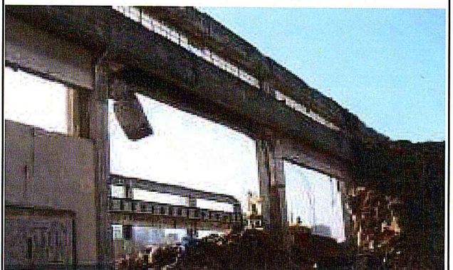
GALPÃO E7 - Demolição
