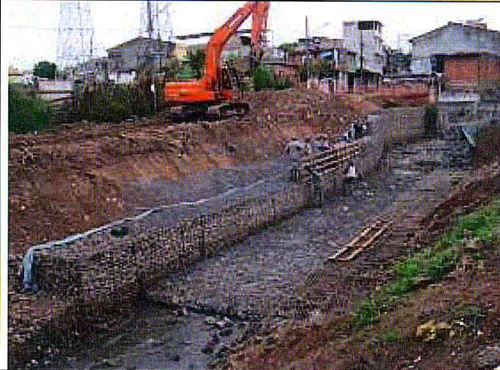
Córrego Bento Henriques : Construção do Gabião
