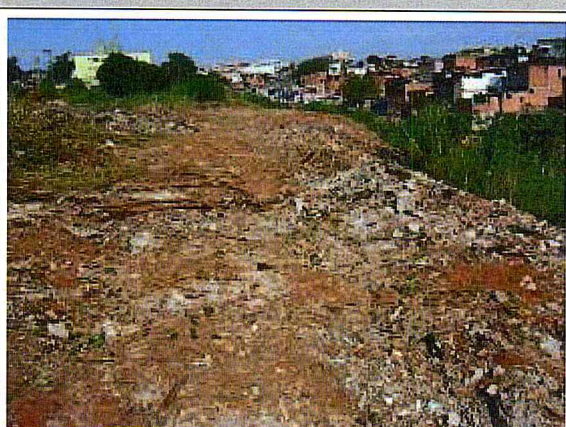
CORREGO CANGUEIRAS.Limpeza da área
