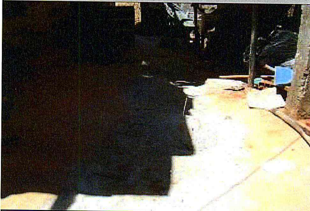
Rede de distribuição de água: Aterro.
