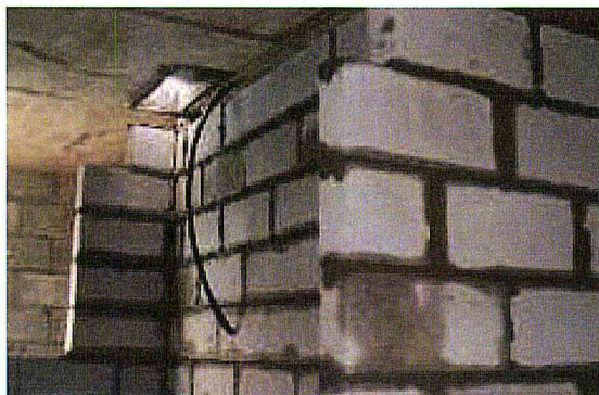
Alvenaria de vedação
