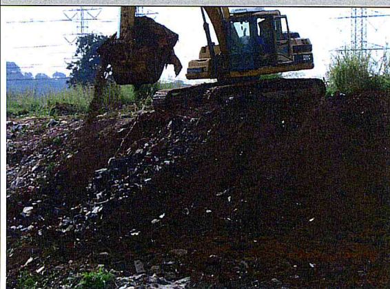
CORREGO CANGUEIRAS.Limpeza da área
