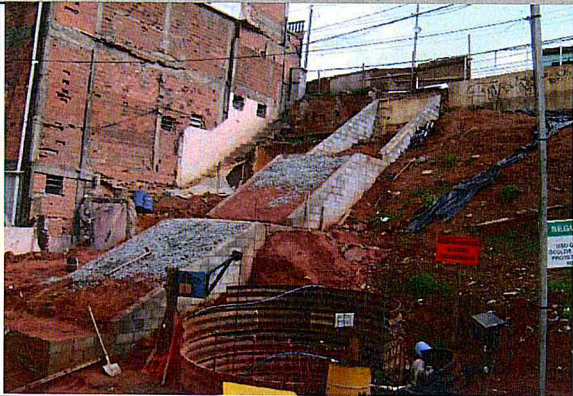
Escadaria: junto ao talude av. Cantídio Sampaio
