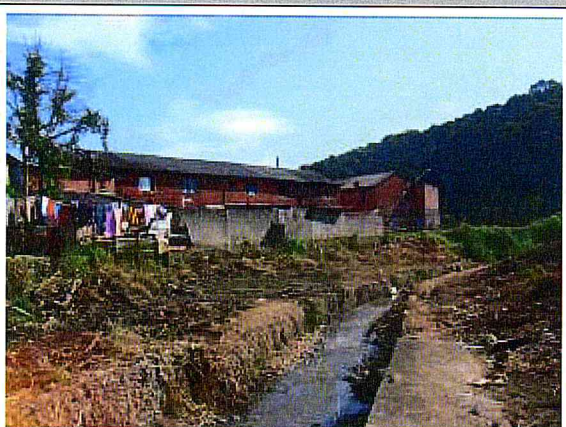
CORREGO CANGUEIRAS.Limpeza da área
