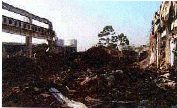
GALPÃO E8 -Remoção do entulho
