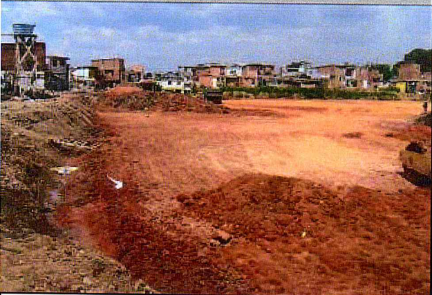
Terraplenagem: Troco de solo.
