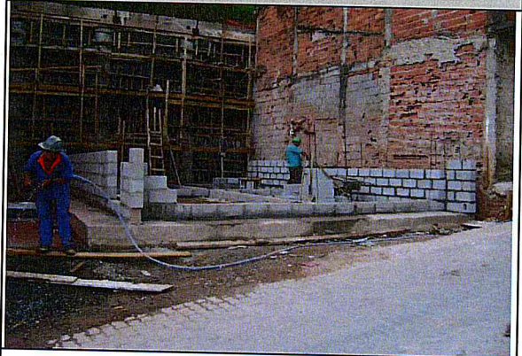
Triposta Buraco: Alvenaria estrutural
