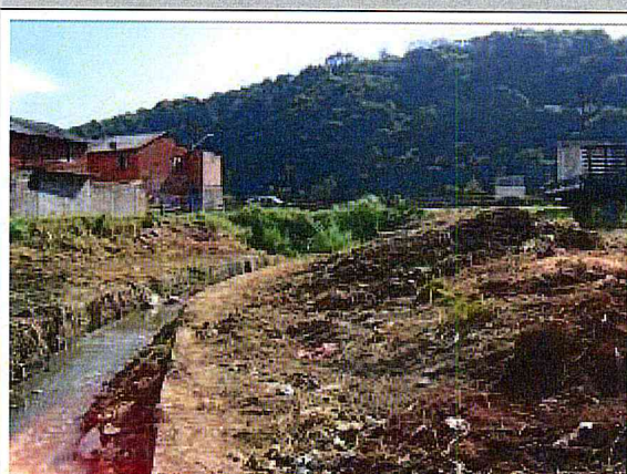
CORREGO CANGUEIRAS.Limpeza da área
