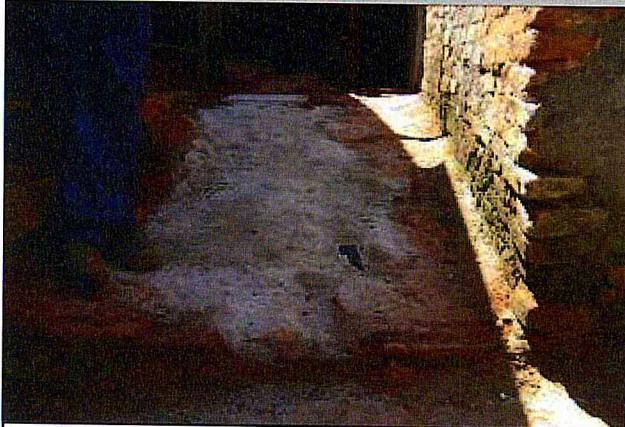
Rede de distribuição de água: Aterro.
