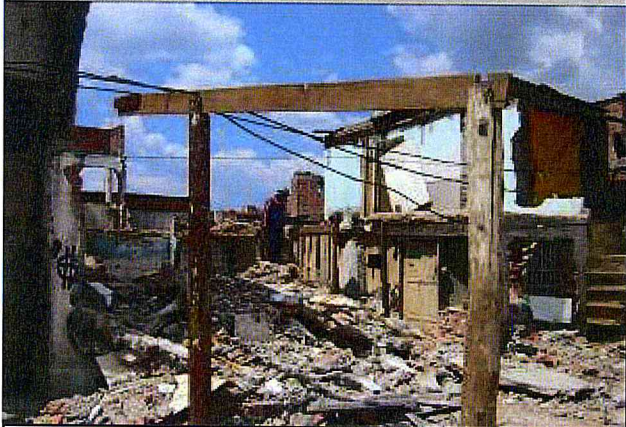
Demolição: Demolições de domicílios.
