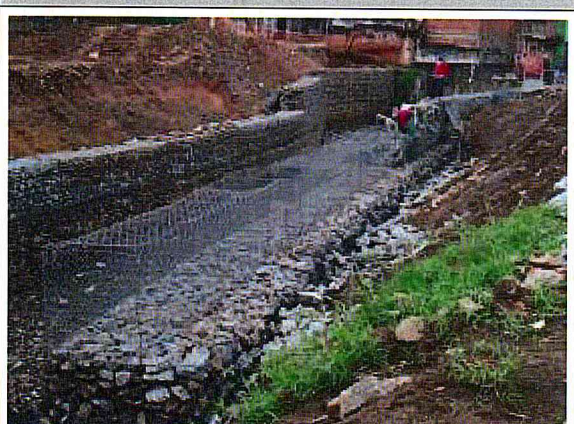
Córrego Bento Henriques : Construção do Gabião
