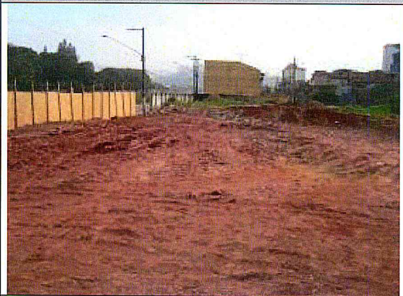
ÁREA DA OBRA. Aterro da área
