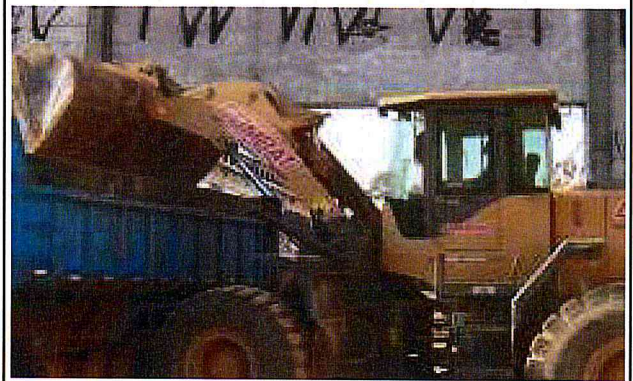
GALPÃO E8 - Remoção do entulho
