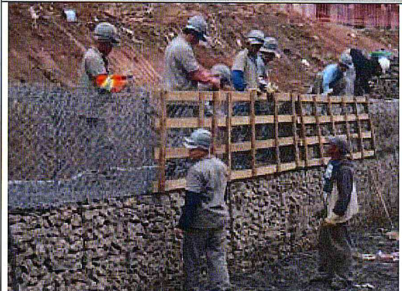
Córrego Bento Henriques : Construção do Gabião
