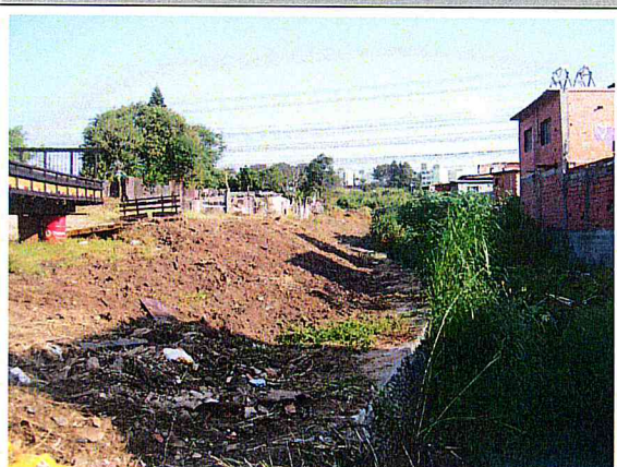
CORREGO CANGUEIRAS.Limpeza da área
