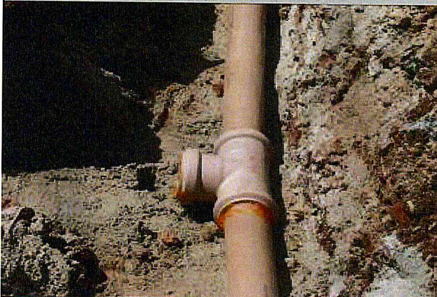
Rede de distribuição de água: Tubulação.
