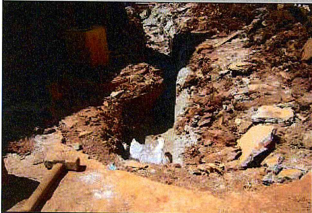
Rede de distribuição de água: Escavação de vala.
