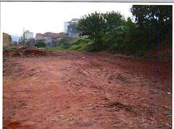
. ÁREA DA OBRA. . Aterro da área
