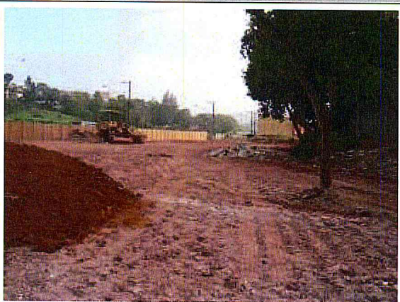
ÁREA DA OBRA. Aterro da área
