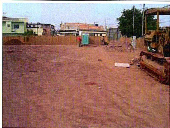
ÁREA DA OBRA. . . Aterro da área
