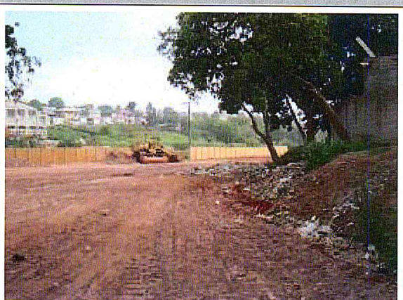
ÁREA DA OBRA. Aterro da área
