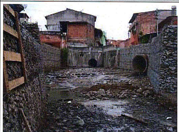
Córrego Bento Henriques : Construção do Gabião
