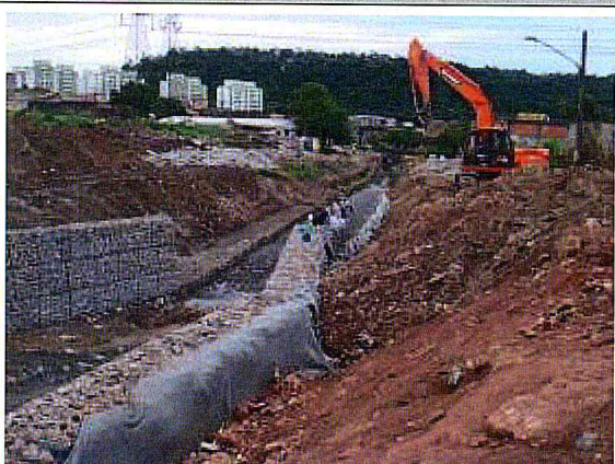
Córrego Bento Henriques : Construção do Gabião
