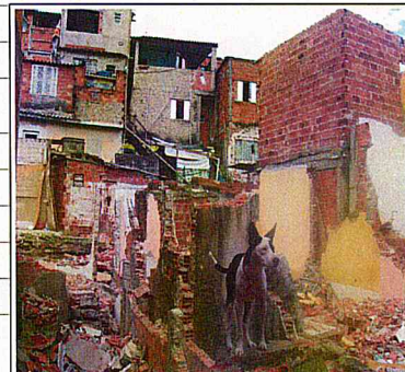
Sapé A: Demolição de moradias.
