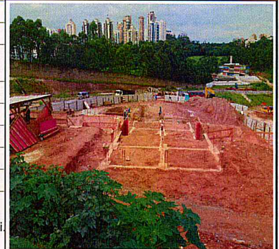
Condomínio G - fundações em andamento.
