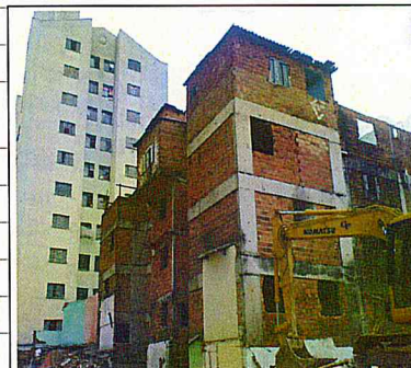
Gleba H: Serviços de demolição em andamento.
