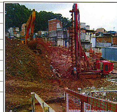
Rocinha: Fundações em andamento.
