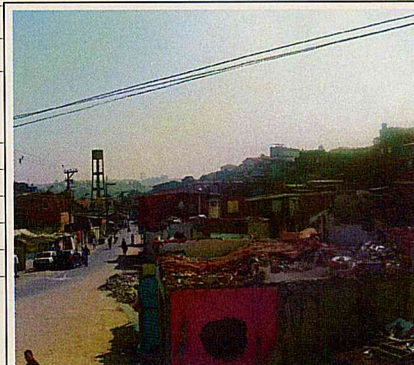
Sapé A: Demolição de moradias.
