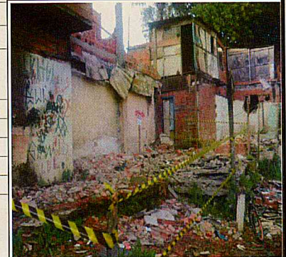
Sapé B: Demolição de moradias.
