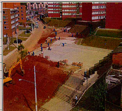
Praça Cond. C - serviços em andamento.
