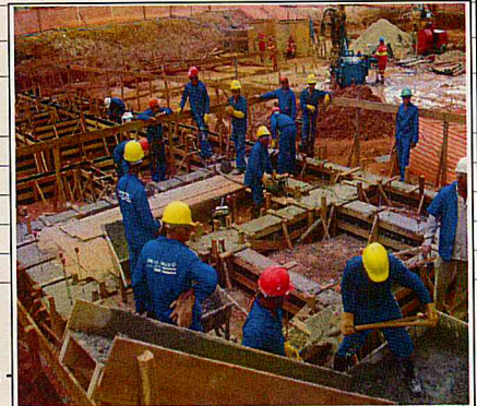
Gleba H: em andamento serviços de fundação.
