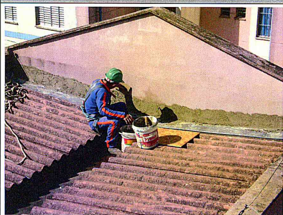
Cobertura: Revisão de calhas e rufos.
