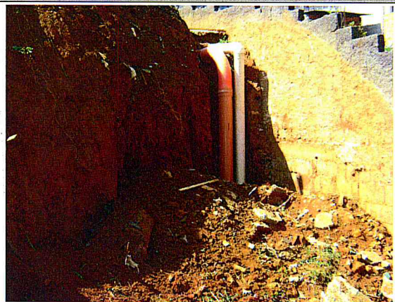
Drenagem e esgoto: Execução em andamento.
