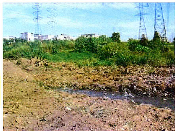
CORREGO CANGUEIRAS.Limpeza da área
