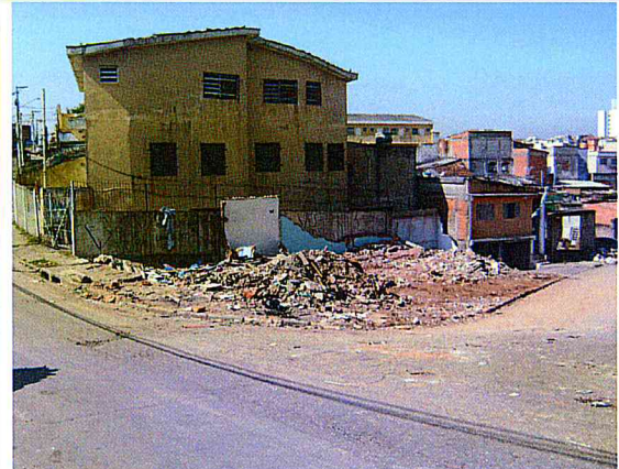
Vista parcial: Domicílios demolidos.
