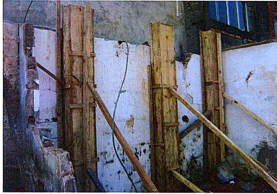
Contenções: Execução de pilares.
