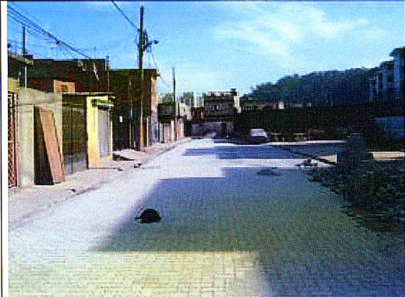
RUA EMILE ZOLA : Pavimentação .
