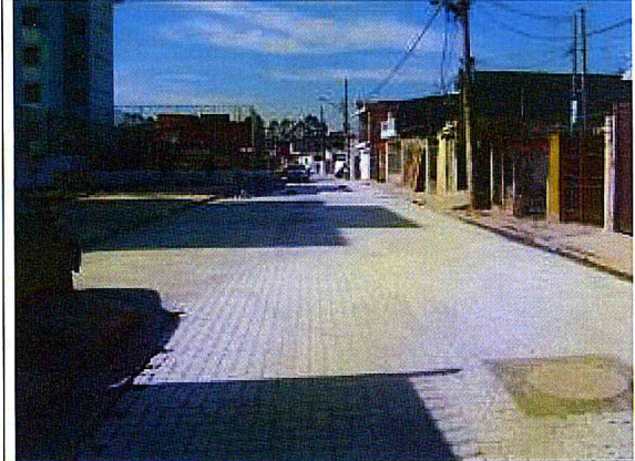
RUA EMILE ZOLA : Pavimentação.
