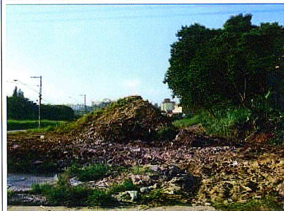
ÁREA DA OBRA. Retirada do entulho
