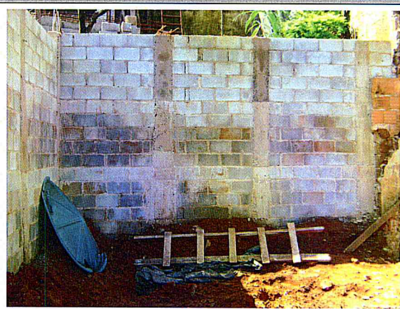
Contenções: Execução de alvenaria.
