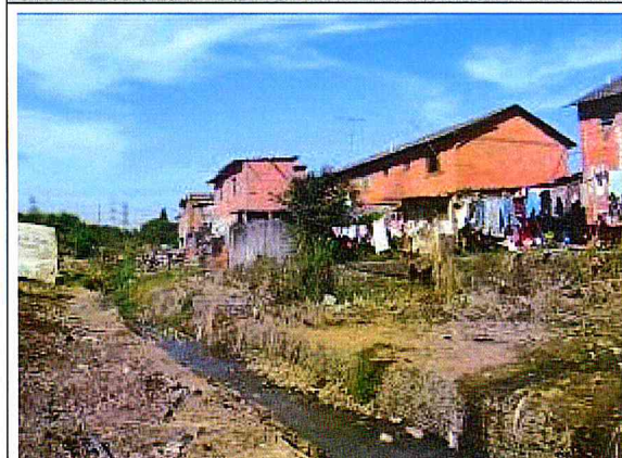
CÓRREGO CANGUEIRAS. Limpeza da área
