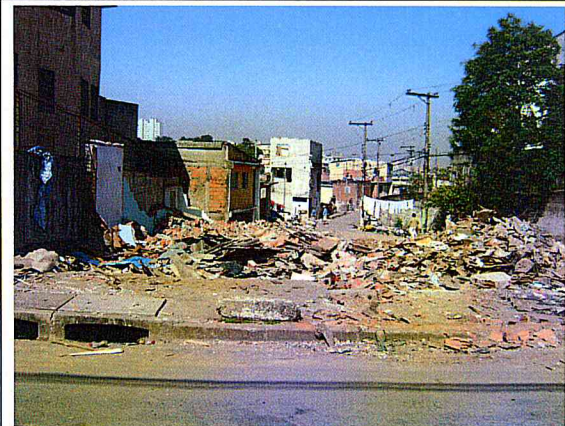
Vista parcial: Domicílios demolidos.
