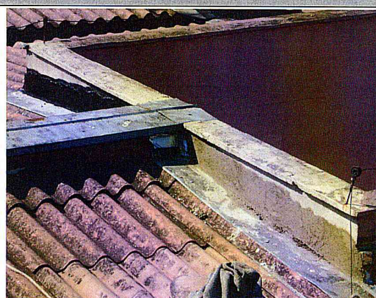
Cobertura: Revisão de calhas e rufos.
