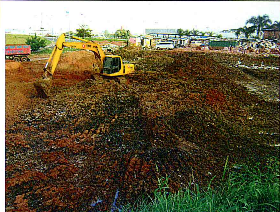
Terraplenagem: Troca de solo.
