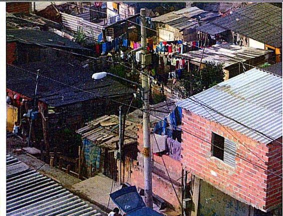
Vista parcial: Domicílios a serem demolidos.
