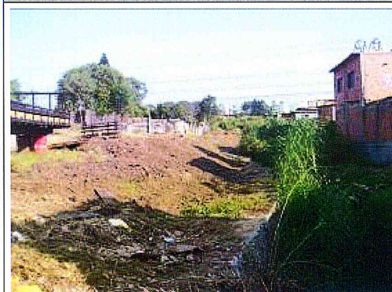
CÓRREGO CANGUEIRAS. Limpeza da área
