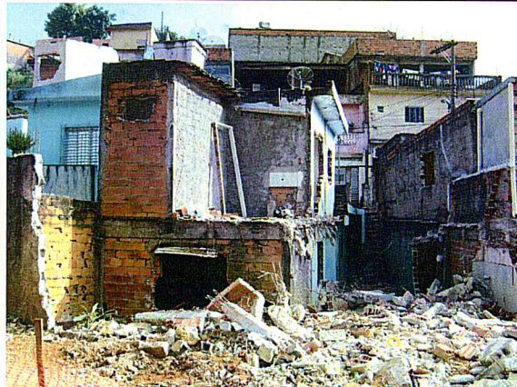
Demolições: Execução em andamento.
