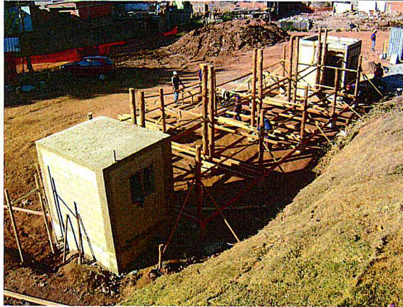
Casa da Conversa: - Execução em andamento.
