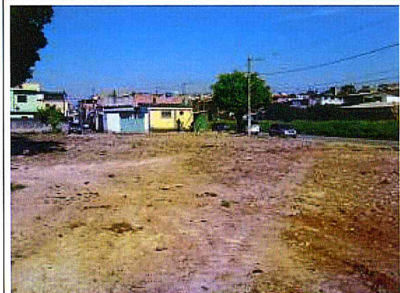
ÁREA DA OBRA. Limpeza do terreno
