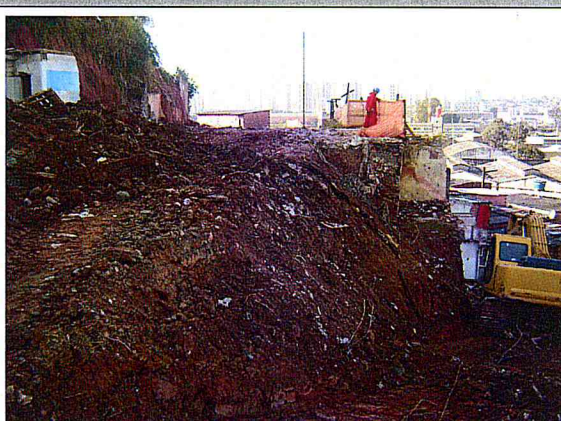
Setor 4 ; Caminho de serviço
