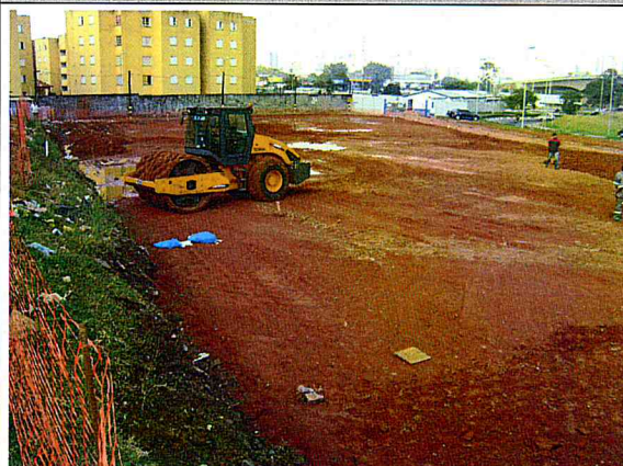
Terraplenagem: Troca de solo.
