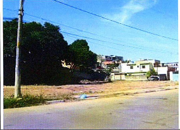
ÁREA DA OBRA. Limpeza do terreno
