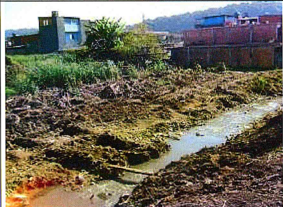
CORREGO CANGUEIRAS.Limpeza da área.
