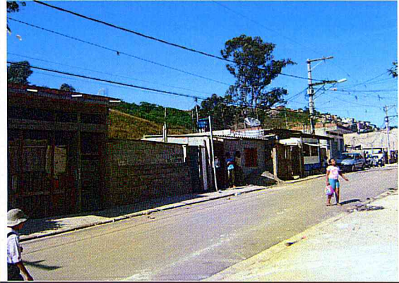
Vista parcial: Domicílios a serem demolidos.
