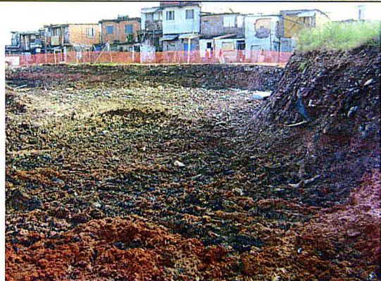
Terraplenagem: Troca de solo.
