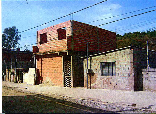
Vista parcial: Domicílios a serem demolidos.
