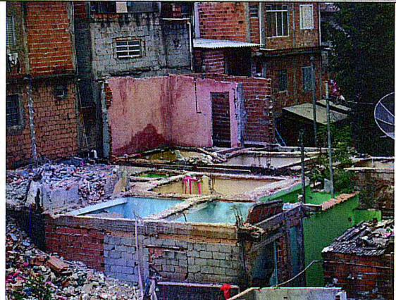
Demolições: Execução em andamento.
