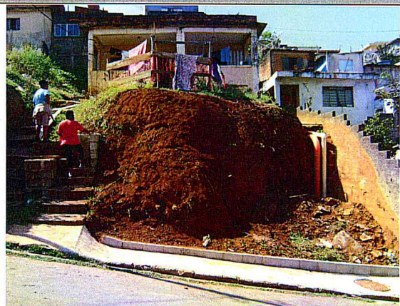
Drenagem e esgoto: Execução em andamento.
