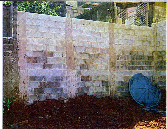
Contenções: Execução de alvenaria.
