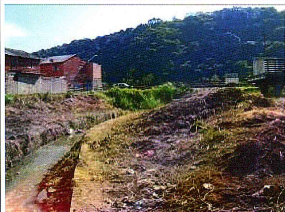
. CORREGO CANGUEIRAS.Limpeza da área
