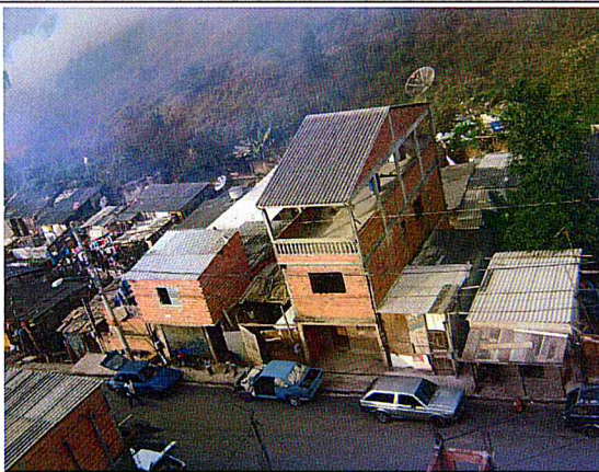
Vista parcial: Domicílios a serem demolidos.
