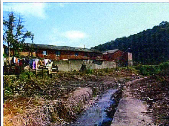
CORREGO CANGUEIRAS.Limpeza da área
