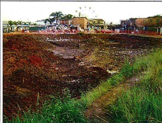
Terraplenagem: Troca de solo.
