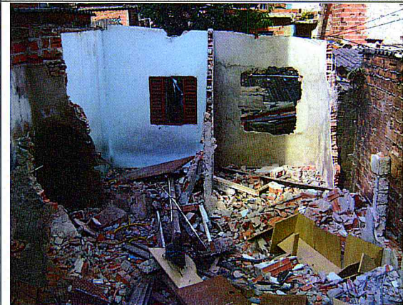
Demolição: Execução em andamento.
