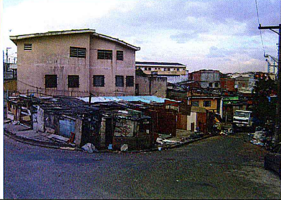
Vista parcial: Domicílios a serem demolidos.
