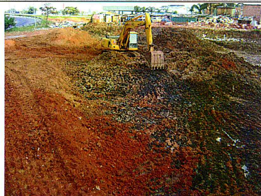
Terraplenagem: Troca de solo.
