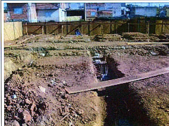
BLOCO 06: Escavação das vigas baldrames.
