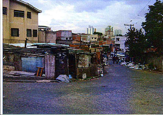
Vista parcial: Domicílios a serem demolidos.
