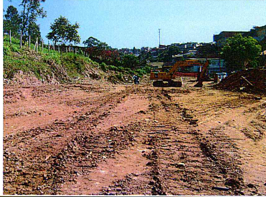
Casa da Conversa: - Execução da terraplenagem.
