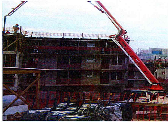
Provisão 6B: UH em andamento-Alvenaria estrutural.
