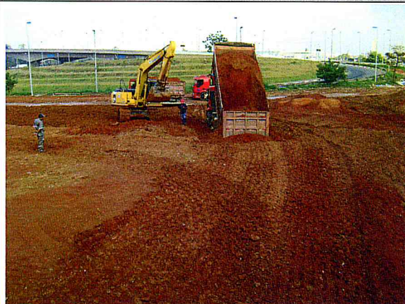
Terraplenagem: Troca de solo.
