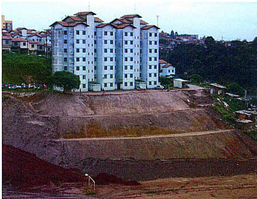
Parque Linear: Terraplenagem – Talude Prover 4.
