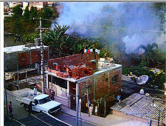
Vista parcial: Domicílios a serem demolidos.
