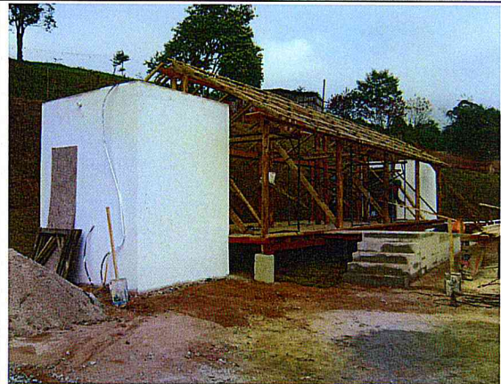
Casa da Conversa: - Execução em andamento.
