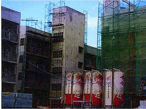
Provisão 6A: UH em andamento-Revestimento externo.
