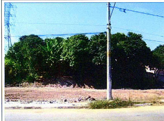
ÁREA DA OBRA. Limpeza do terreno
