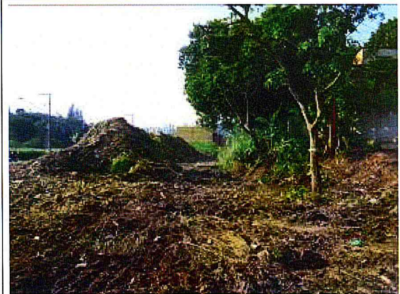
ÁREA DA OBRA. Retirada do entulho
