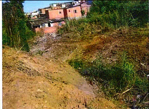
CORREGO CANGUEIRAS.Limpeza da área
