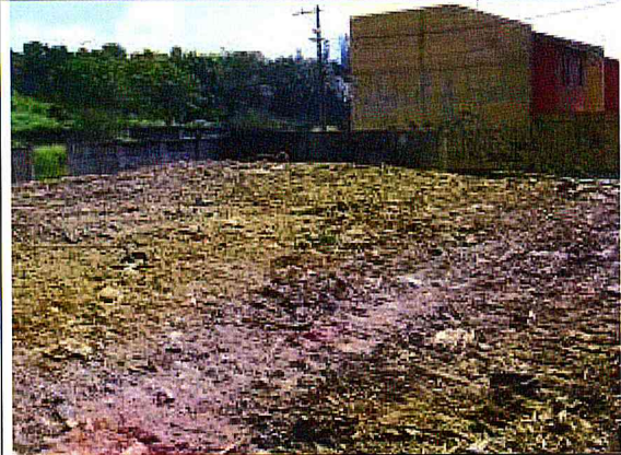
ÁREA DA OBRA. Limpeza do terreno
