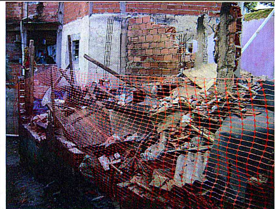
Demolição: Execução em andamento.
