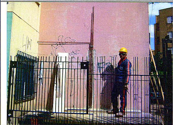
Instalações de gás: Execução de prumadas.
