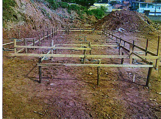
Casa da Conversa: - Execução da locação.
