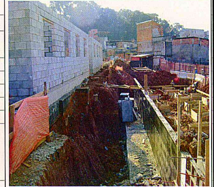
Rocinha- serviços em andamento.
