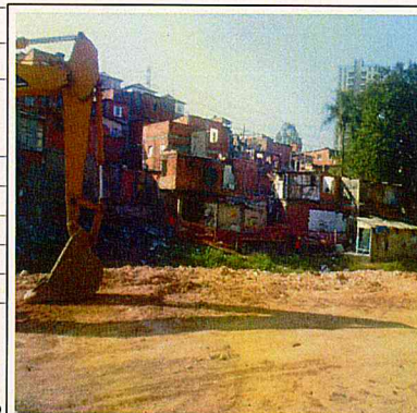
Sapé B: Demolição de moradias.
