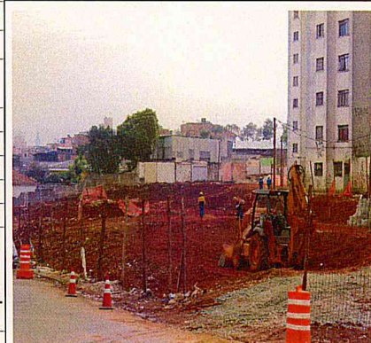
Gleba H: em andamento serviços de fundação.
