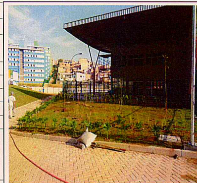
CAPS - serviços em fase final.
