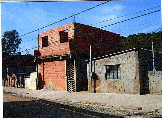
Vista parcial: Domicílios a serem demolidos.
