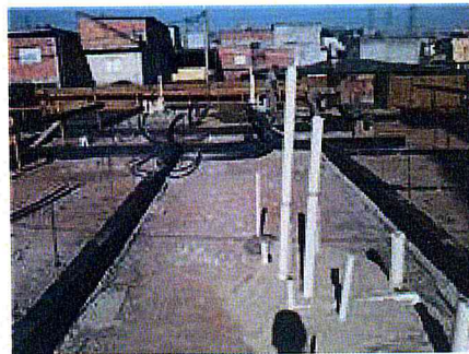
. BLOCO 06: Execução do contra piso e instalação das tubulações de hidráulicas e elétricas.
