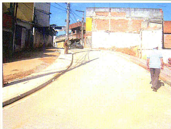
Rua Manuel Marques de Souza: Pavimentação.
