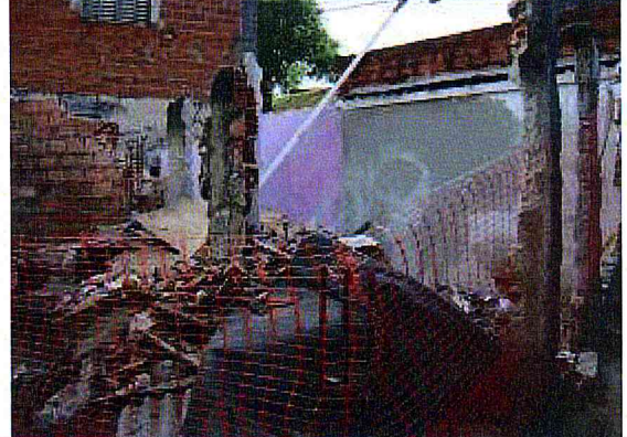
Demolição: Execução em andamento.
