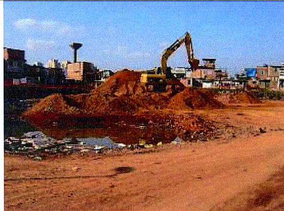
Terraplenagem: Troca de solo.
