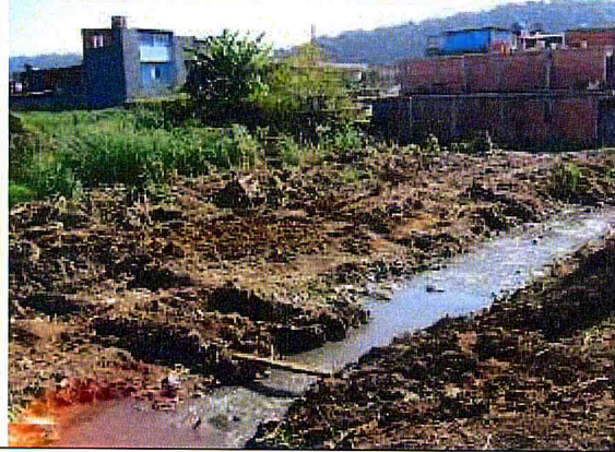
CORREGO CANGUEIRAS. Limpeza da área.
