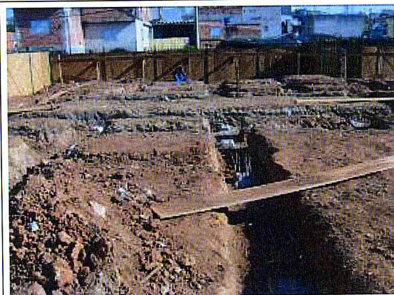
BLOCO 06: Escavação das vigas baldrame.
