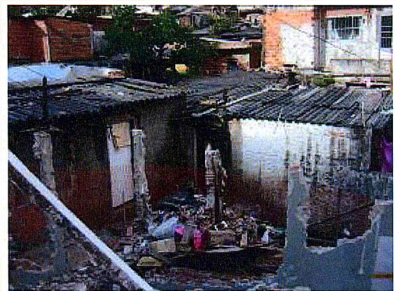
Demolição: Execução em andamento.
