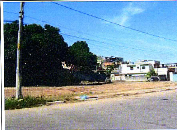
ÁREA DA OBRA. Limpeza do terreno
