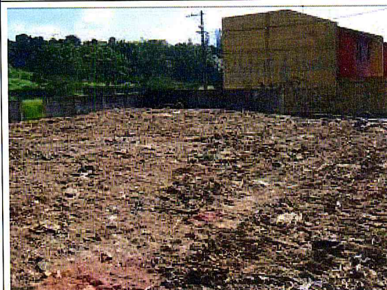
ÁREA DA OBRA. Limpeza do terreno
