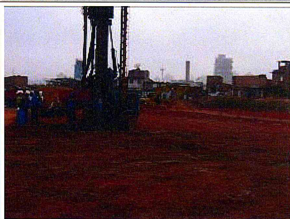
Fundação: Execução de estacas hélice contínua.
