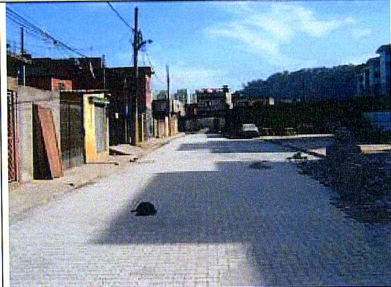
RUA EMILE ZOLA : Pavimentação .
