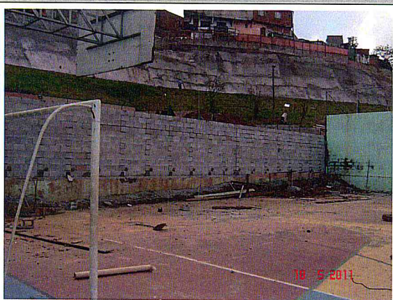
Muro de arrimo Setor 3.
