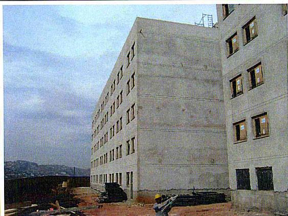
Provisão 6A: UH em andamento-Revestimento externo.
