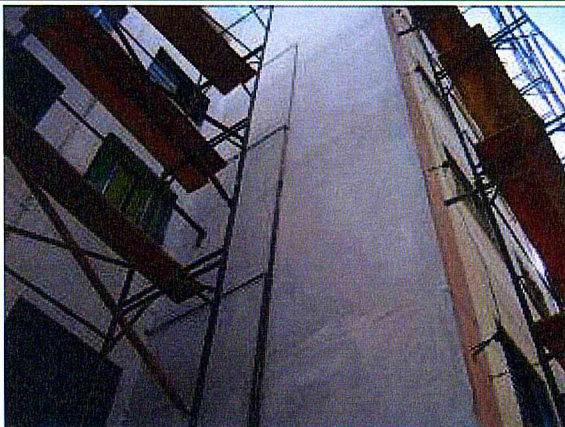
Instalações de Gás: Execução de prumadas.
