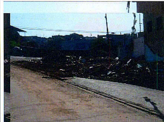
Demolição: Execução em andamento.
