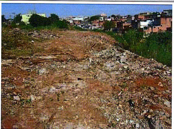
CORREGO CANGUEIRAS. Limpeza da área
