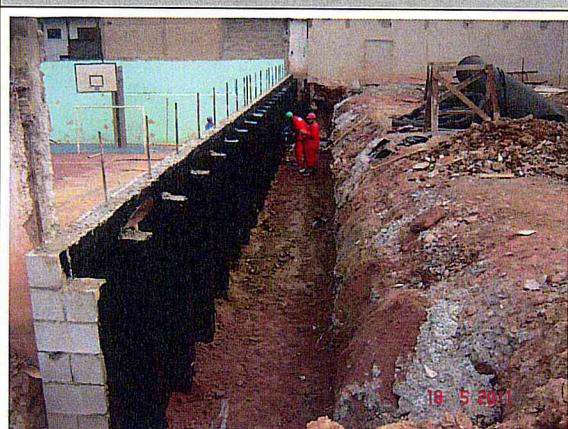
P Muro de arrimo Setor 3.
