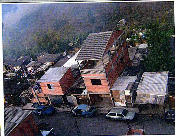
Vista parcial: Domicílios a serem demolidos.
