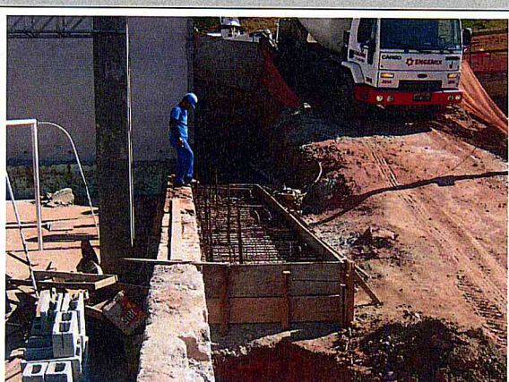
Muro de arrimo Setor 3.
