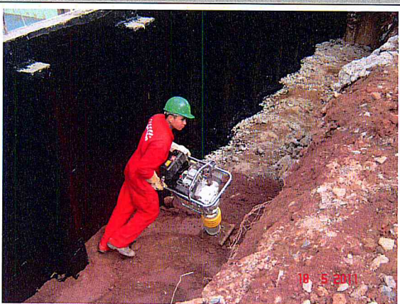
Muro de arrimo Setor 3.
