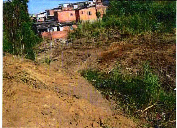
CORREGO CANGUEIRAS. Limpeza da área
