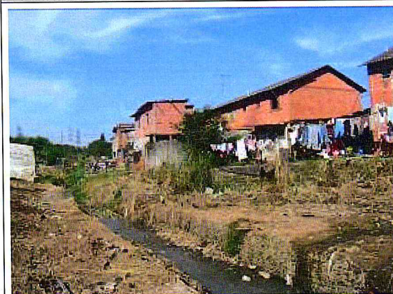
CÓRREGO CANGUEIRAS. Limpeza da área
