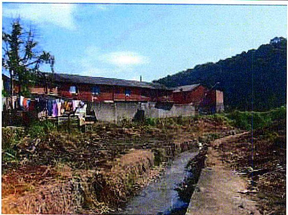
CORREGO CANGUEIRAS. Limpeza da área
