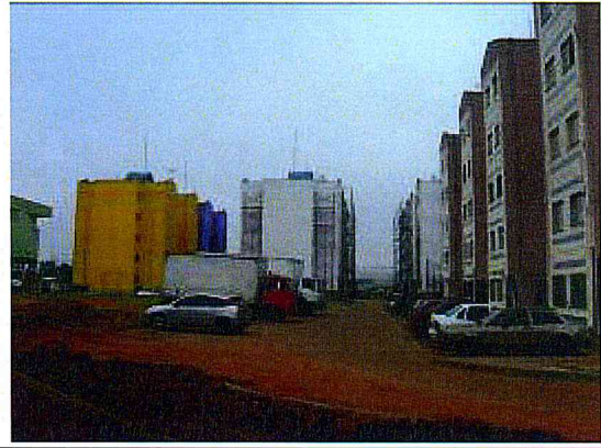
Pintura: Aplicação de látex.
