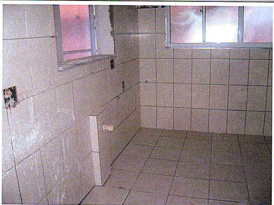
Bloco E: Revestimento cerâmico.
