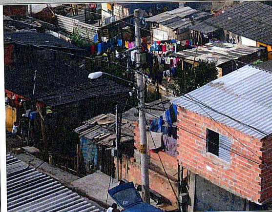
Vista parcial: Domicílios a serem demolidos.
