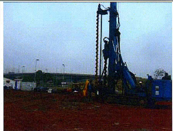
Fundação: Execução de estacas hélice contínua.
