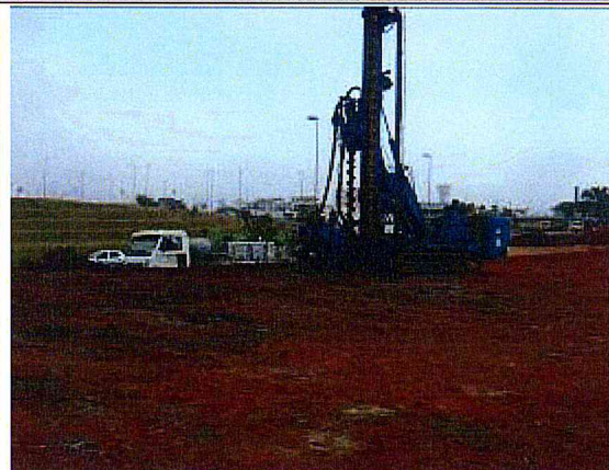
Fundação: Execução de estacas hélice contínua.
