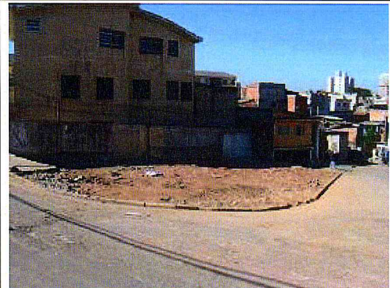
Demolição: Vista parcial da área demolida.
