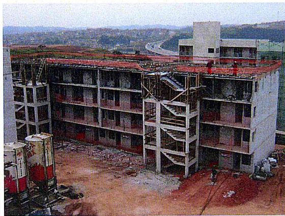
Provisão 6B: UH em andamento-Alvenaria estrutural.
