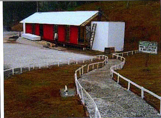
Casa da Conversa: - Execução da cobertura e pintura.
