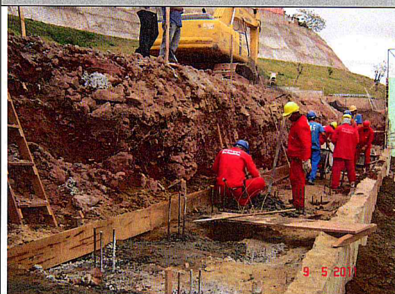
Muro de arrimo Setor 3.
