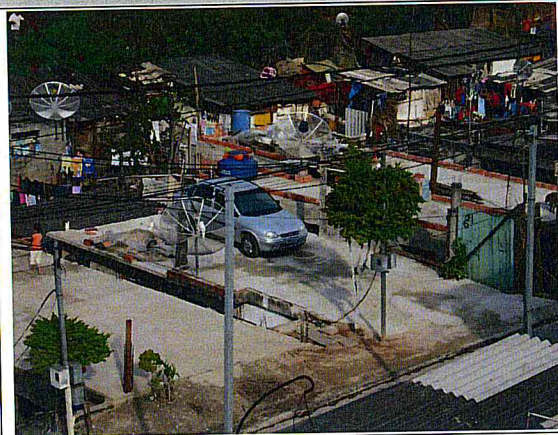
Vista parcial: Domicílios a serem demolidos.
