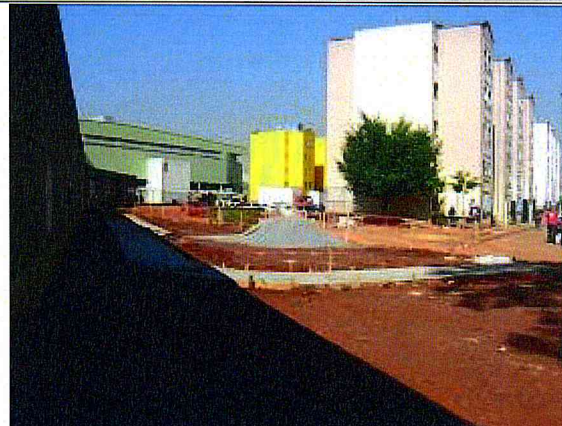
Urbanismo: Pista de cooper concretada.
