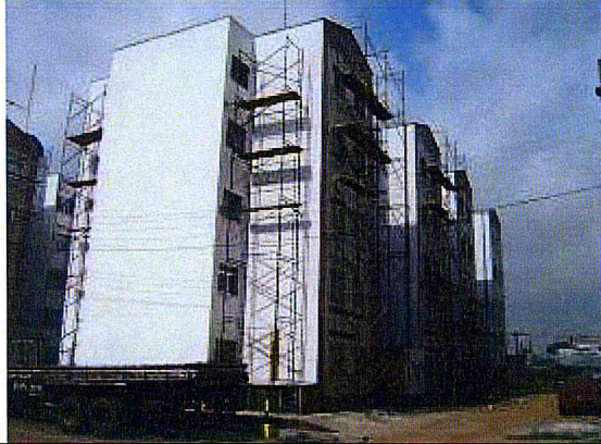
Pintura: Aplicação de seladora.
