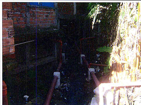
Córrego Guarani: Rede de esgoto.
