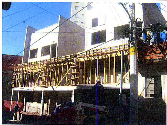
Tripostas Agulhamento 1 e 2: UH's em andamento.
