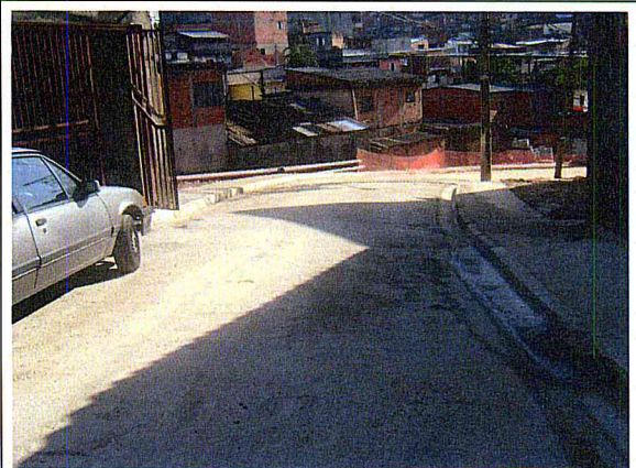
Rua Manuel Marques de Souza: Pavimentação.
