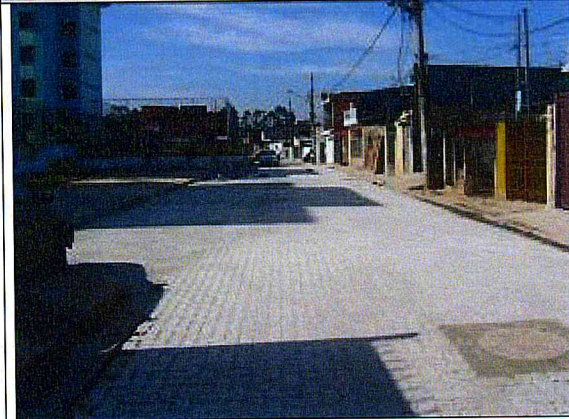
RUA EMILE ZOLA : Pavimentação.
