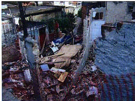
Demolição: Execução em andamento.
