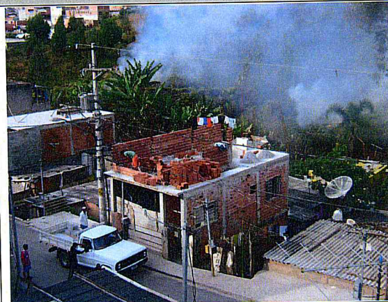
Vista parcial: Domicílios a serem demolidos.
