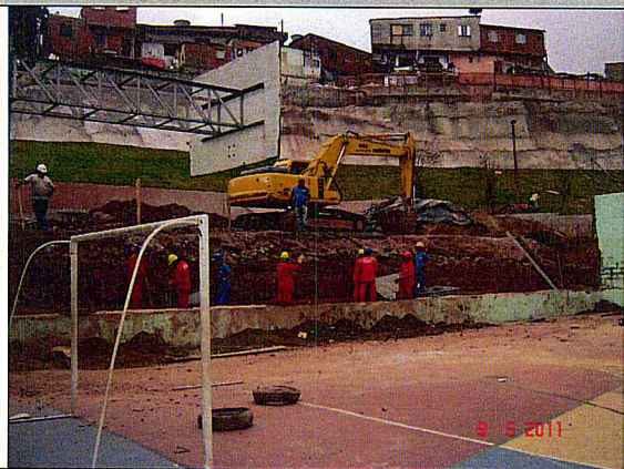
Muro de arrimo Setor 3.
