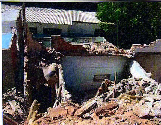
Demolições: Execução em andamento.
