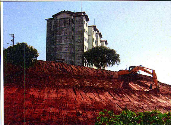
Parque Linear: Terraplenagem – Talude Prover 4.
