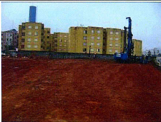
Fundação: Execução de estacas hélice contínua.
