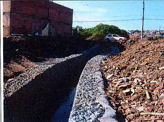
Parque Linear: Canalização de córrego.
