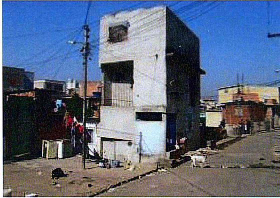
Demolição: Domicílio a ser demolido.
