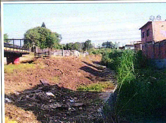
CÓRREGO CANGUEIRAS. Limpeza da área
