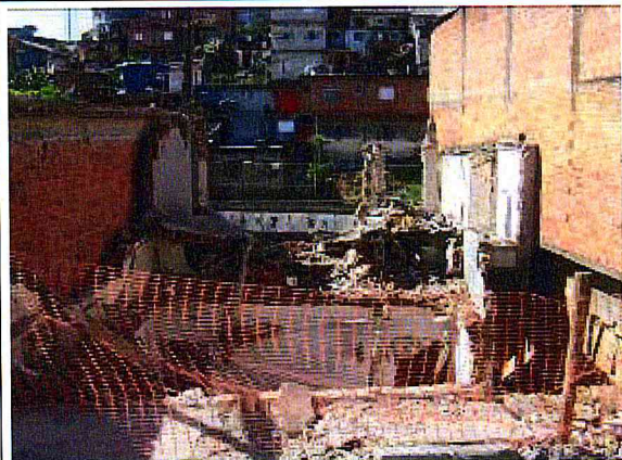
Demolições: Execução em andamento.
