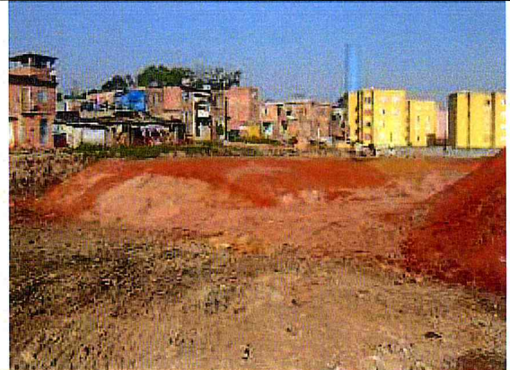
Terraplenagem: Troca de solo.
