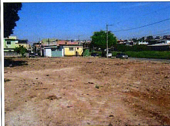
ÁREA DA OBRA. Limpeza do terreno
