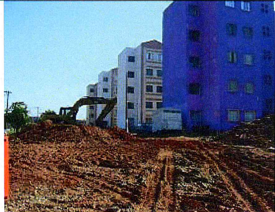
Urbanismo: Demolição de piso de concreto.
