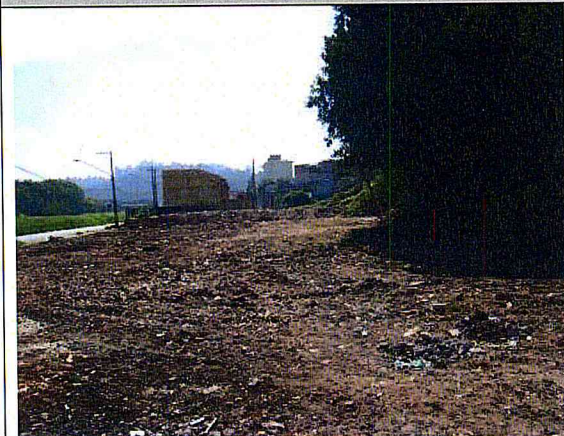
ÁREA DA OBRA. Limpeza do terreno
