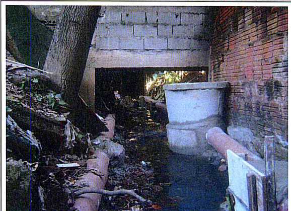
Córrego Guarani: Rede de esgoto.
