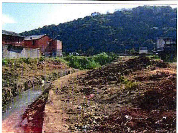
. CORREGO CANGUEIRAS. Limpeza da área
