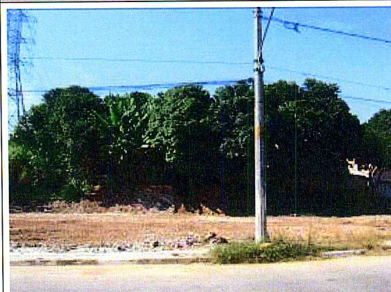
ÁREA DA OBRA. Limpeza do terreno
