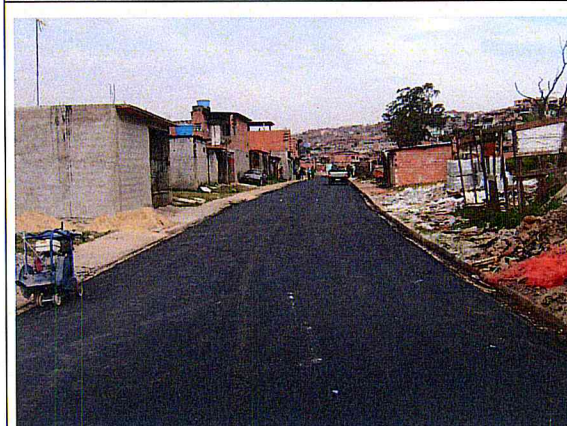
Núcleo C: Pavimentação-Rua Beira Rio.
