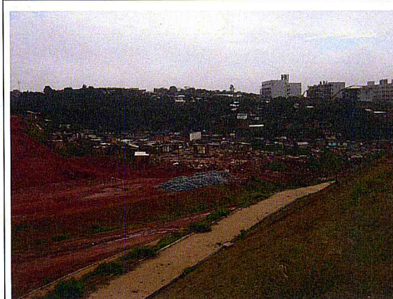
Parque Linear: Demolição de barracos.
