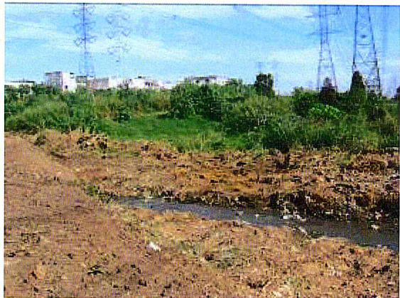
CORREGO CANGUEIRAS. Limpeza da área
