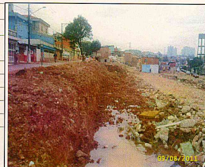
Sapé A: Demolição de moradias.
