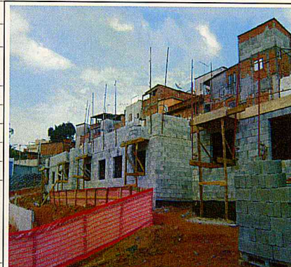
Rocinha- serviços em andamento.
