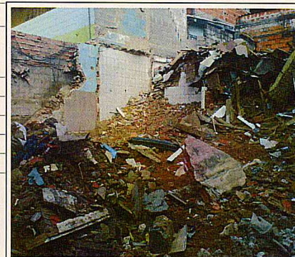
Núcleo Pan: Execução de demolição para construção de mini quadra.
