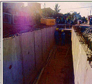
Córrego do Brejo - serviços em andamento.
