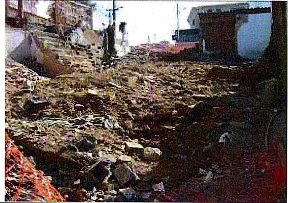
Demolição: Vista parcial da área demolida.
