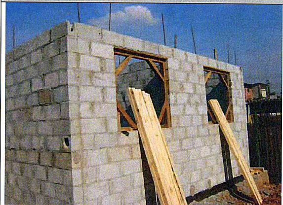
Bloco 6 : Alvenaria do pavimento terreo
