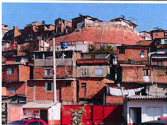
Preparo de talude para projetado
