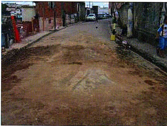
Drenagem: Área a ser executada a rede.
