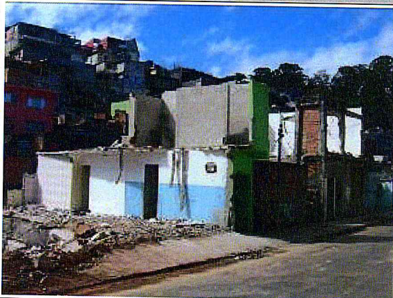
Demolição: - Execução em andamento.
