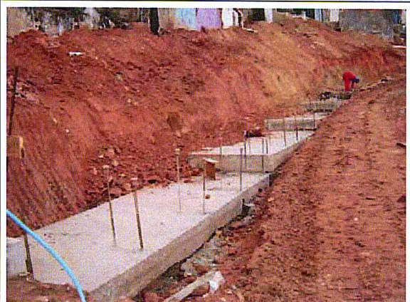
Muro de Contenção
