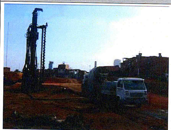
Fundação: Execução de estacas hélice contínua.
