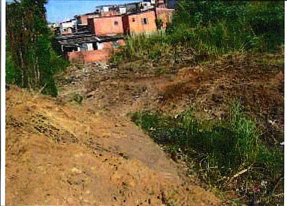
CORREGO CANGUEIRAS.Limpeza da área
