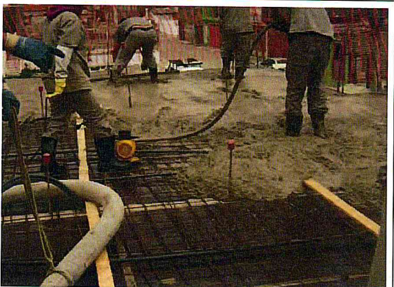
Bloco 6 : Concreto da laje
