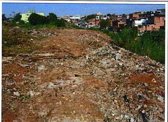
CORREGO CANGUEIRAS.Limpeza da área
