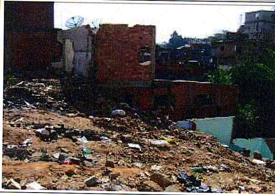
Demolição: - Execução em andamento.
