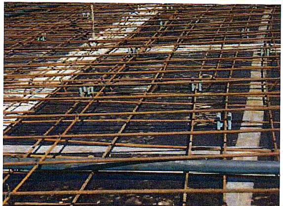
Bloco 6 : Montagem da forma da laje e ferragem
