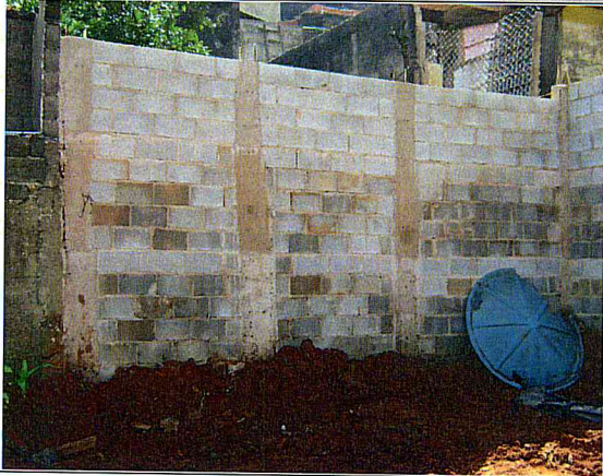
Contenções: Execução de alvenaria.
