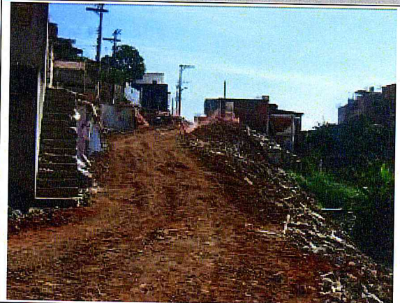
Vista Parcial: Abertura de via de acesso ao canteiro.
