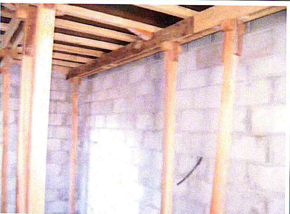
Bloco 6 : Escoramento da laje
