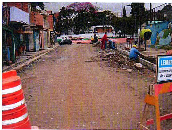
Pavimentação de Sistema Viário.
