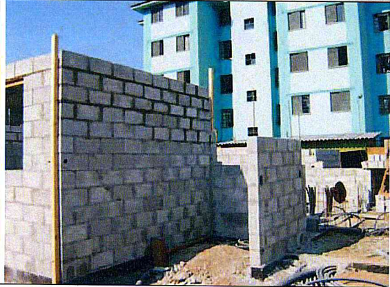
Bloco 6 : Alvenaria do pavimento terreo
