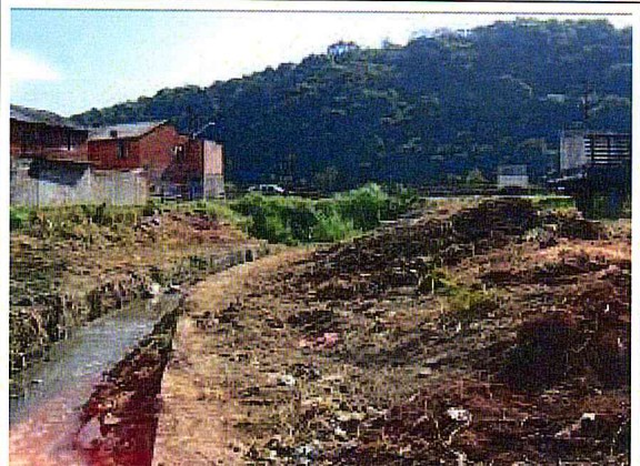
CORREGO CANGUEIRAS.Limpeza da área
