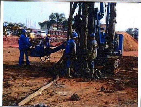
Fundação: Execução de estacas hélice contínua.
