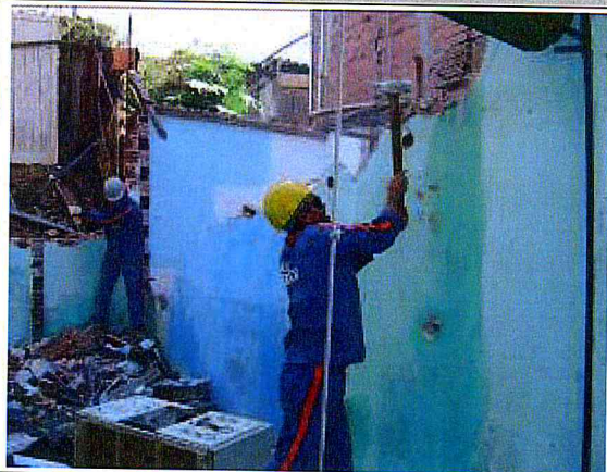
Demolição: Execução em andamento.
