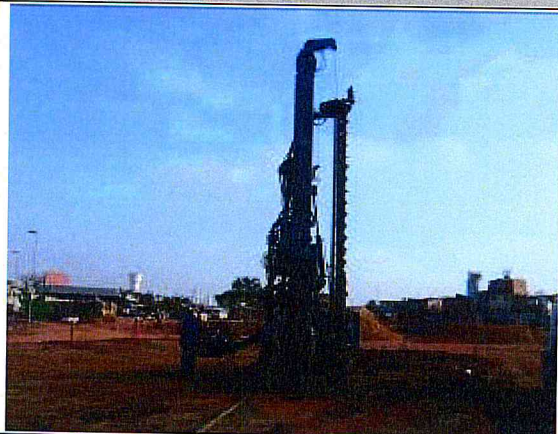
Fundação: Execução de estacas hélice contínua.
