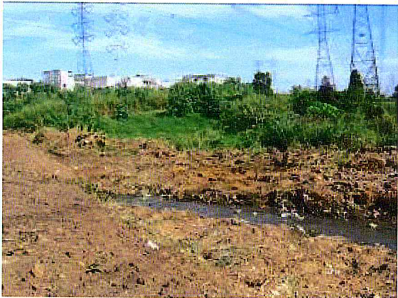
CORREGO CANGUEIRAS.Limpeza da área
