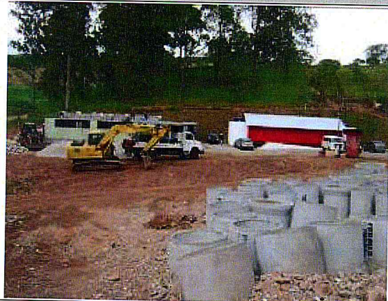
Vista Parcial: Casa da Conversa e Canteiro.
