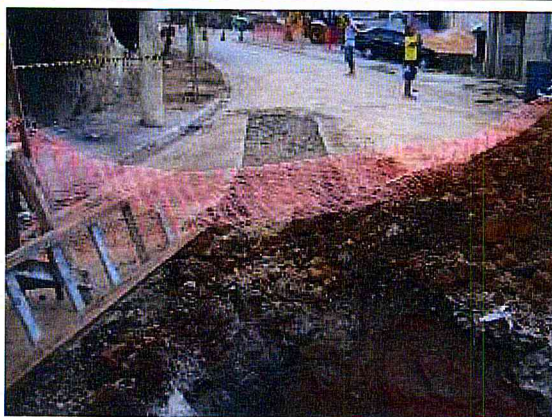
Drenagem: Execução em andamento.
