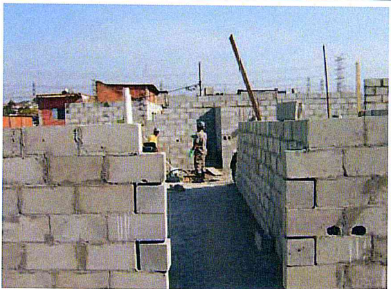
Bloco 6 : Alvenaria do pavimento terreo
