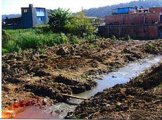
CORREGO CANGUEIRAS.Limpeza da área.
