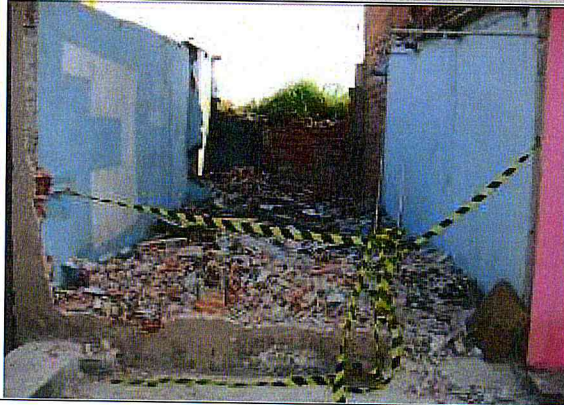
Demolição: Execução em andamento.
