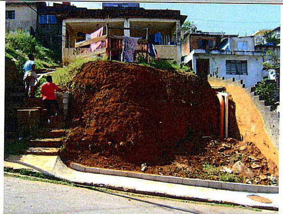
Drenagem e esgoto: Execução em andamento.
