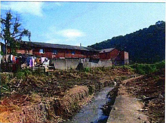
CORREGO CANGUEIRAS.Limpeza da área
