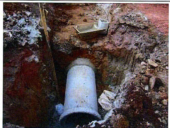
Drenagem: Execução em andamento.
