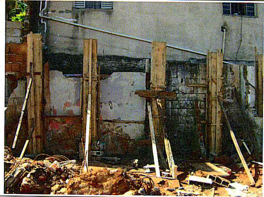
Contenções: Execução de pilares.
