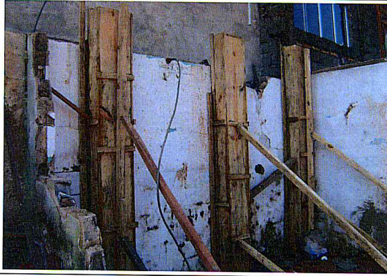
Contenções: Execução de pilares.
