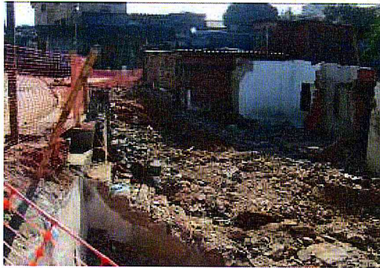
Demolição: Vista parcial da área demolida.
