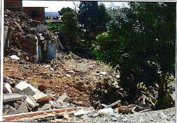
Demolição: - Execução em andamento.
