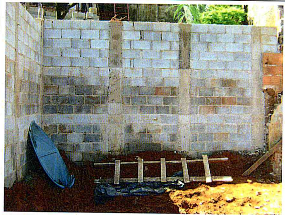
Contenções: Execução de alvenaria.
