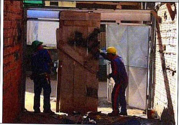
Demolição: Execução em andamento.
