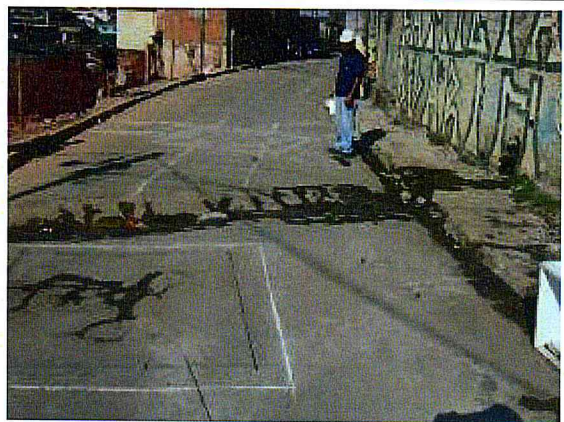
Drenagem: Demarcação da área a ser executada a rede.
