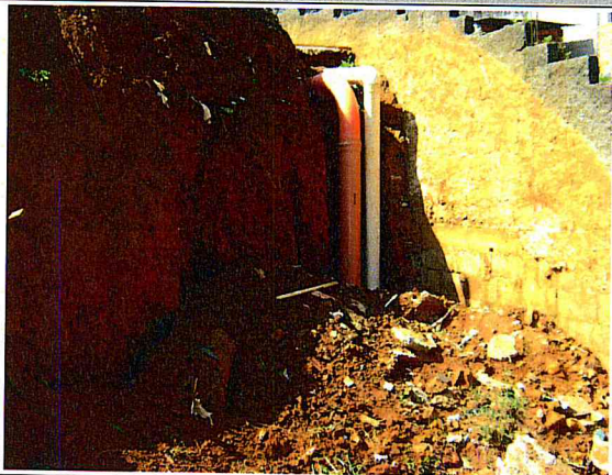
Drenagem e esgoto: Execução em andamento.
