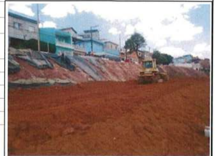
Sapé A: Execução de terraplenagem para execução dos serviços.
