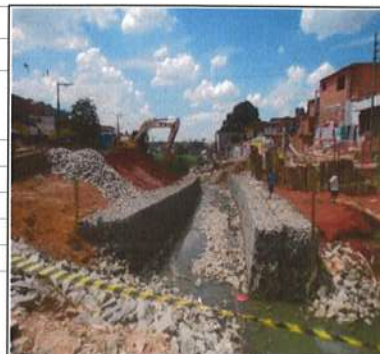
Sapé B: Canalização do córrego.
