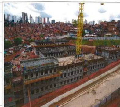
Condomínio E - Serviços em andamento.
