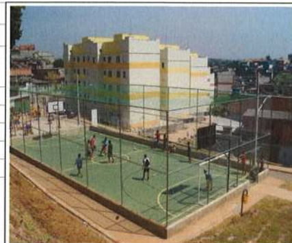
Jardim das Rosas - Obra concluída.
