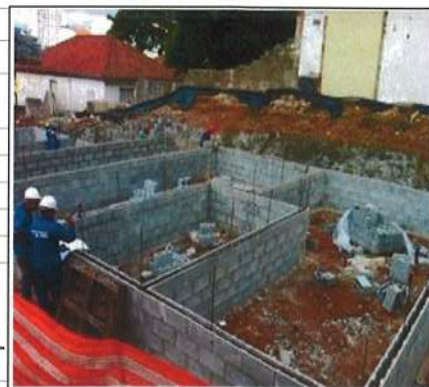
Gleba H : Alvenaria em execução.
