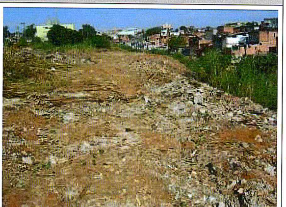
CORREGO CANGUEIRAS.Limpeza da área
