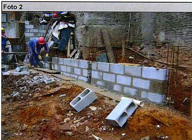
Urbanismo: Execução de muros.
