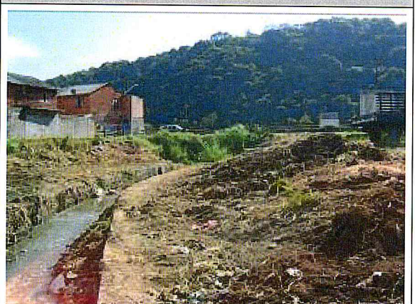
. CORREGO CANGUEIRAS.Limpeza da área
