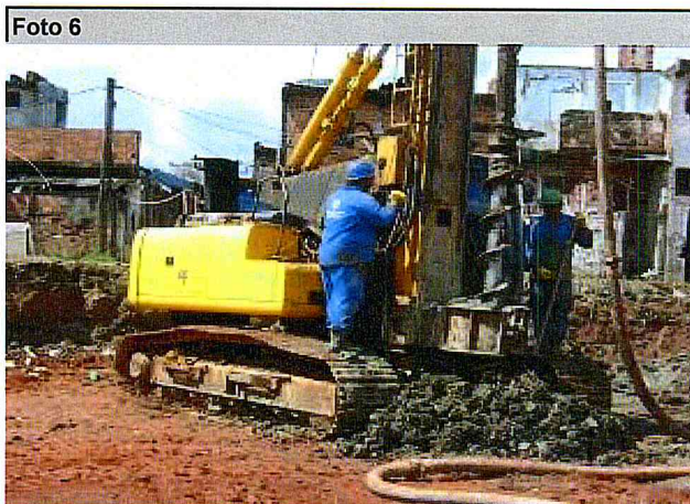
UH's: Estaqueamento do "Bloco D".
