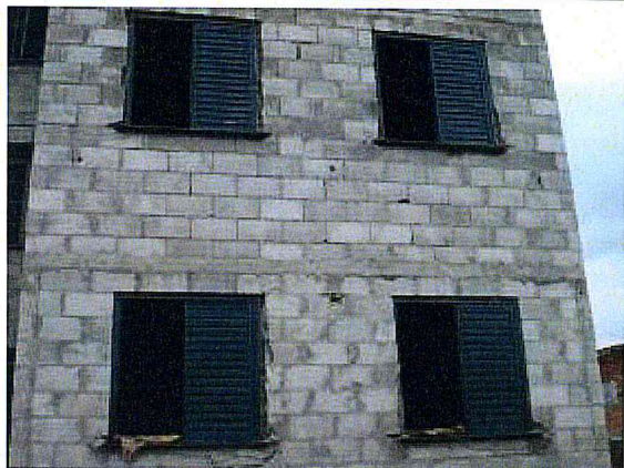
ÁREA DA OBRA. Colocação de esquadrias metálicas.
