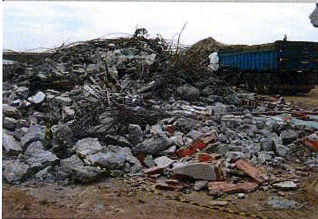
GALPÃO E8 -Remoção do entulho
