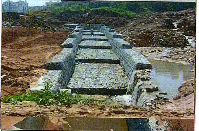
Córrego Parque Linear Trecho B: Canalização.
