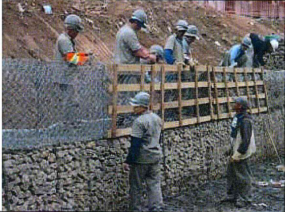
ÁREA DA OBRA. Gabião em execução.
