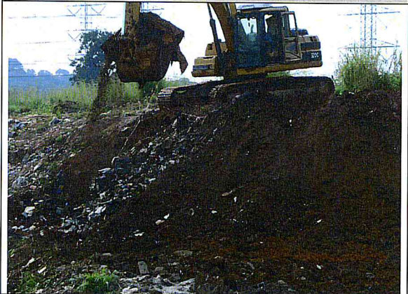
CORREGO CANGUEIRAS.Limpeza da área
