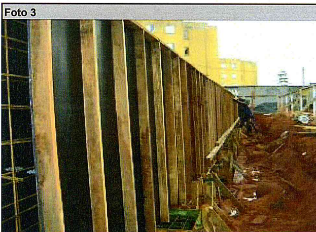
UH's: Armação de fundação do "Bloco A".
