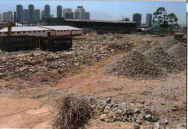
GALPÃO E8 - Demolição
