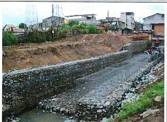
ÁREA DA OBRA. Gabião em execução.
