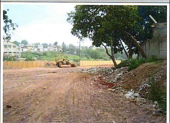
ÁREA DA OBRA. Aterro da área
