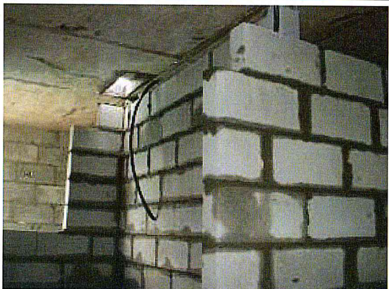
ÁREA DA OBRA. Execução de Alvenaria de vedação.
