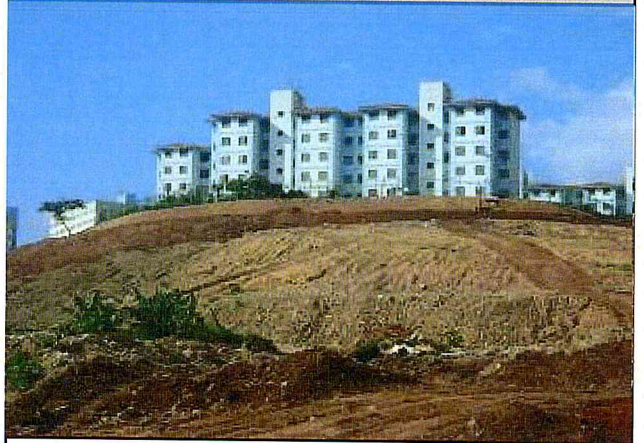
Provisão 4: Terraplenagem: Serviço iniciado.
