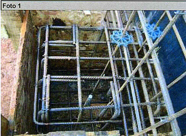
UH's: Armação de fundação do "Bloco A".
