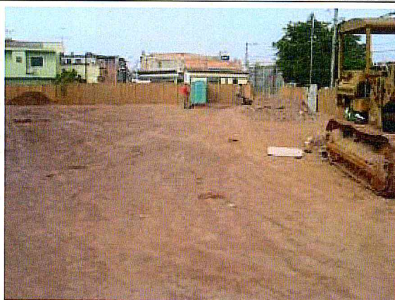
ÁREA DA OBRA. . . Aterro da área
