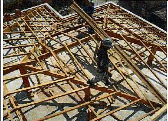
ÁREA DA OBRA. Estrutura de madeira do telhado.
