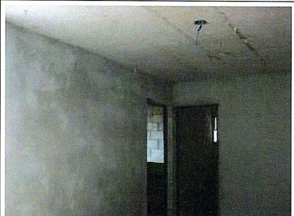
ÁREA DA OBRA. Revestimento interno do apto.
