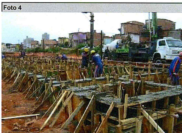
UH's: Concretagem de viga baldrame do "Bloco A".
