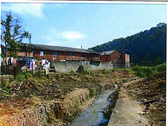
CORREGO CANGUEIRAS.Limpeza da área
