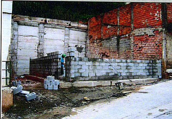
Triposta Buraco: Alvenaria estrutural
