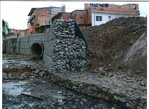
ÁREA DA OBRA. Gabião em execução.
