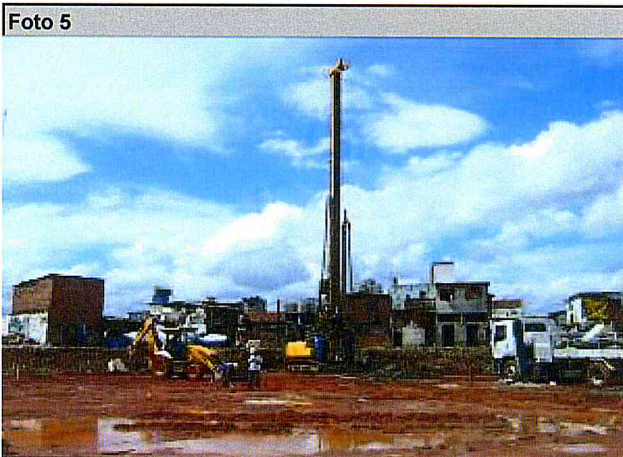
UH's: Estaqueamento do "Bloco D".
