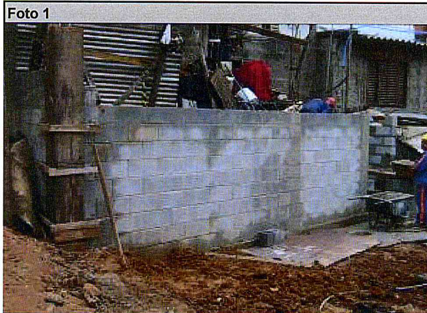
Urbanismo: Execução de muros.
