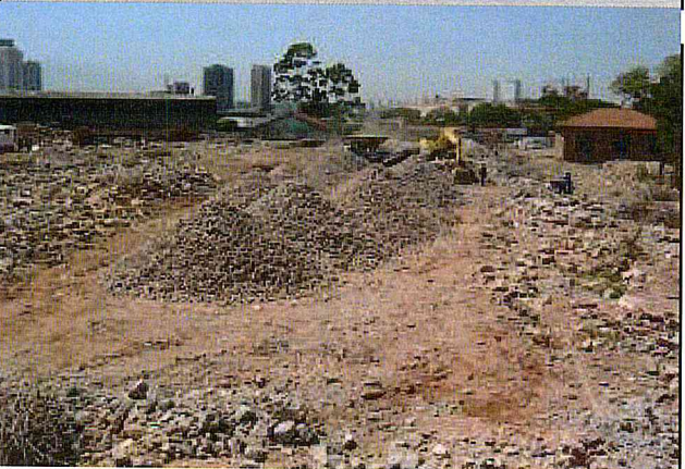
GALPÃO E7 - Demolição
