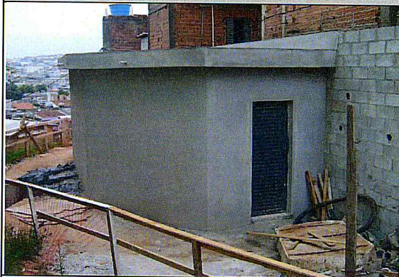
Centro de Medição: Blocos A, B e E
