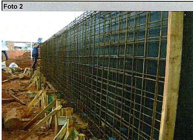
UH's: Armação de fundação do "Bloco A".
