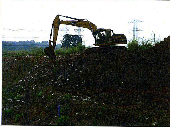
CORREGO CANGUEIRAS.Limpeza da área.
