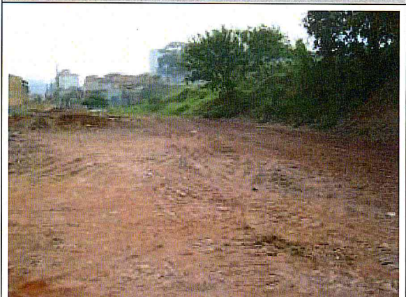
ÁREA DA OBRA. . Aterro da área
