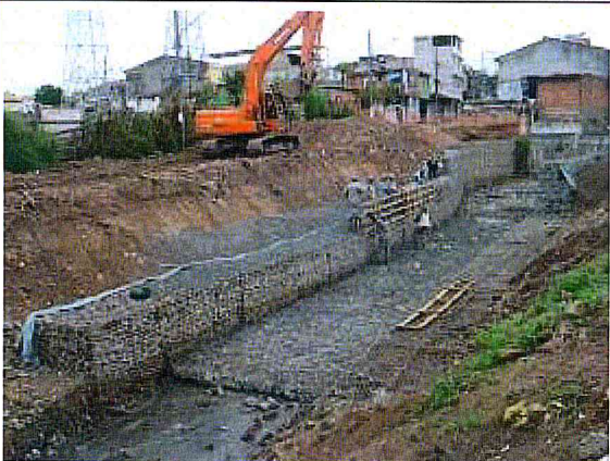
ÁREA DA OBRA. Gabião em execução.
