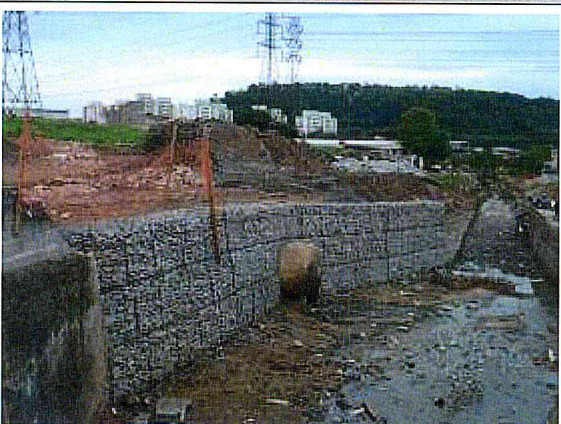
ÁREA DA OBRA. Gabião em execução.
