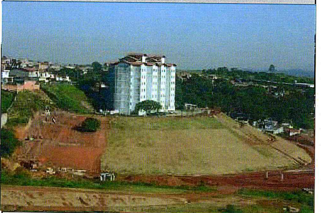
Prover 4: Retaludamento e drenagem.
