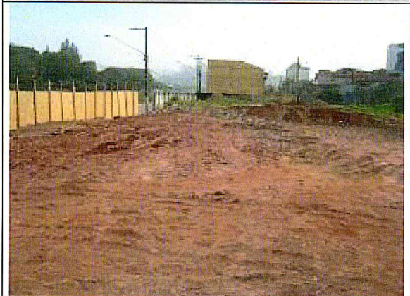
ÁREA DA OBRA. Aterro da área
