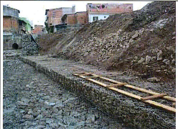
ÁREA DA OBRA. Gabião em execução.
