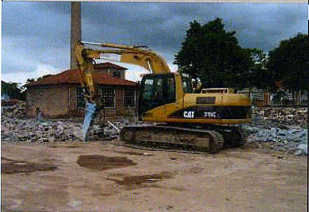
GALPÃO E7 - Demolição
