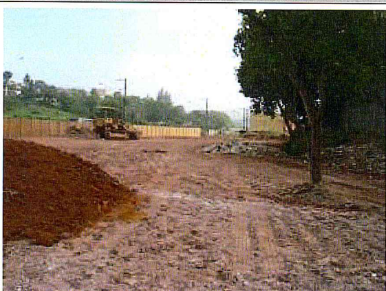
ÁREA DA OBRA. Aterro da área
