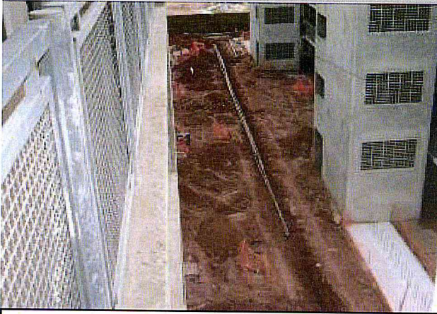
Provisão 6A : Execução da rede condominial de incêndio.
