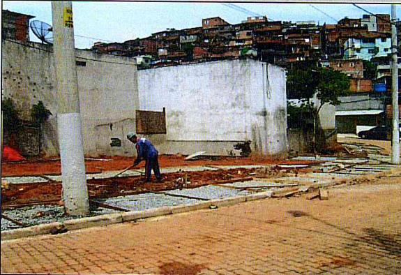
Rua Manoel marques da silva: calçamento
