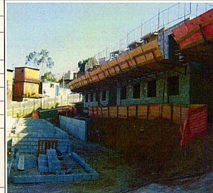
Rocinha- serviços em andamento.
