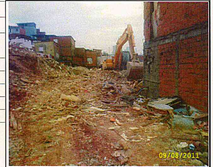
Sapé A: Demolição de moradias.
