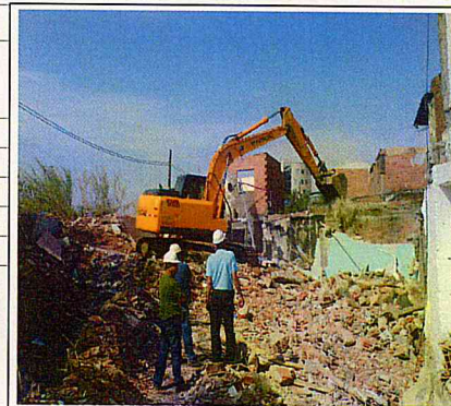
Gaivotas: Execução de demolição.
