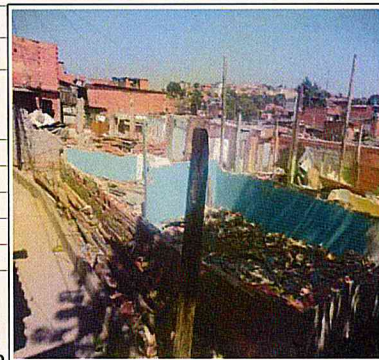
Sapé B: Demolição de moradias.
