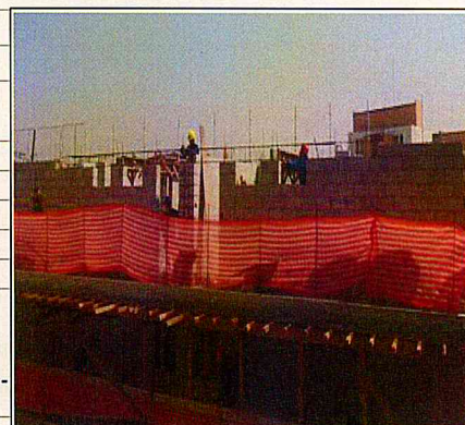
Gleba H: Elevação de alvenaria em andamento
