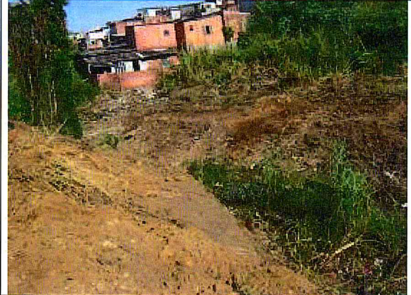
CORREGO CANGUEIRAS.Limpeza da área
