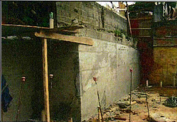
Intervenção 5: Muro de contenção
