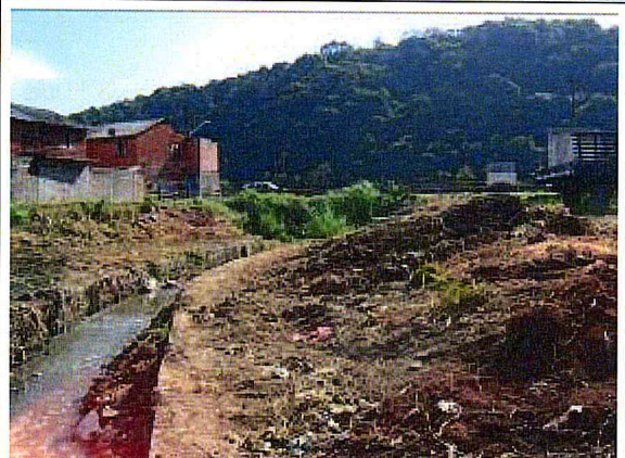
CORREGO CANGUEIRAS.Limpeza da área
