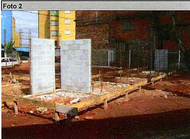
Urbanismo: Execução de lixeira.
