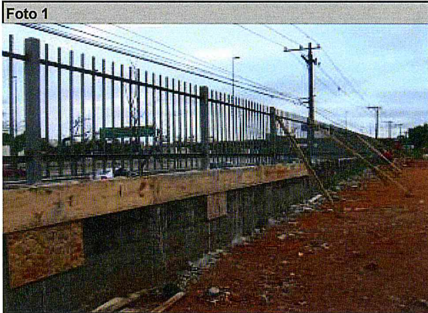
Urbanismo: Execução de gradil.
