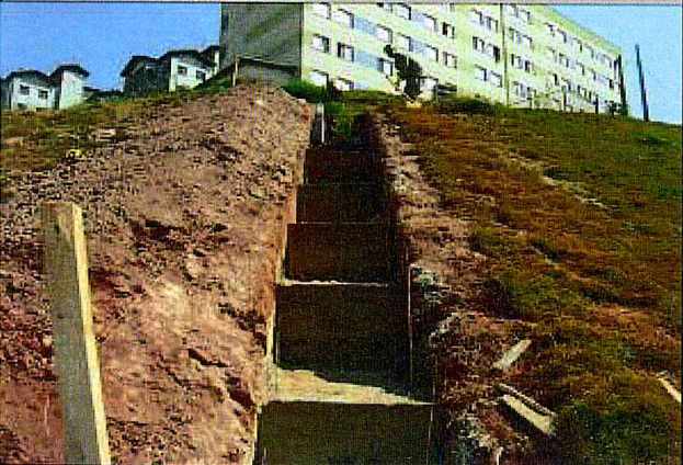
Vale do Morumbi: Drenagem do talude.
