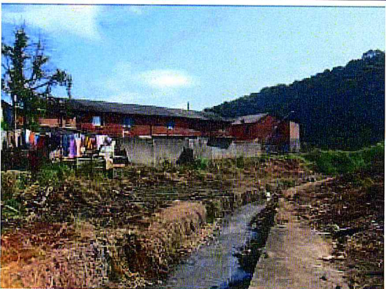
CORREGO CANGUEIRAS.Limpeza da área
