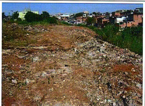
CORREGO CANGUEIRAS.Limpeza da área
