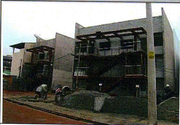
Blocos 15 a 17: UH's em andamento
