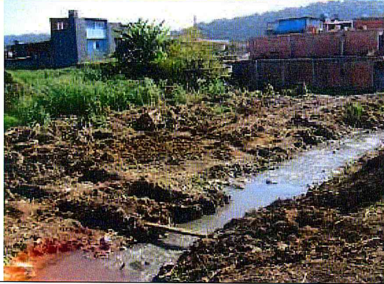
CORREGO CANGUEIRAS.Limpeza da área.
