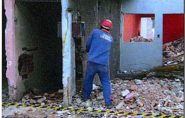
Rua Bamburral: Demolição de domicílios.
