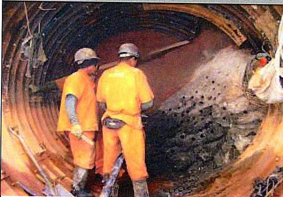
Túnel linear: desmonte de rocha
