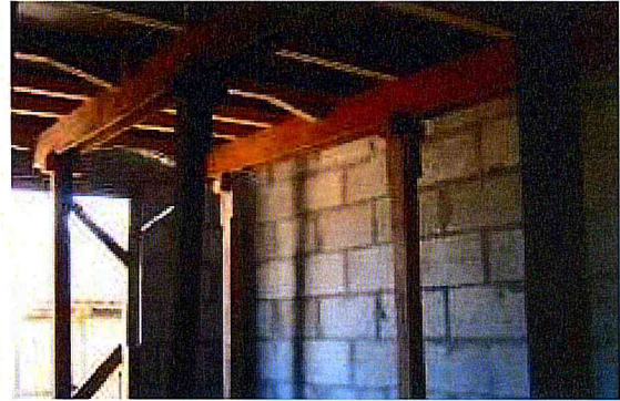
Rua Emilia Zola : Escoramento de laje
