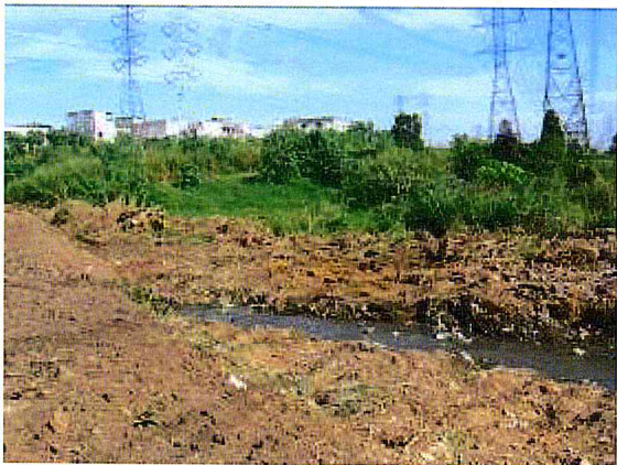
CORREGO CANGUEIRAS.Limpeza da área
