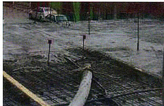
Bloco 6 : Concretagem de laje
