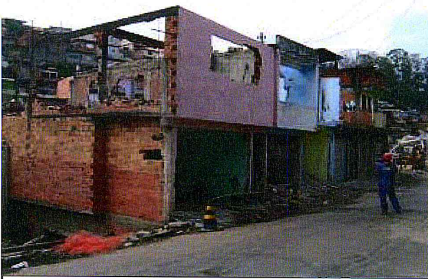
Rua Bamburral: Demolição de domicílios.
