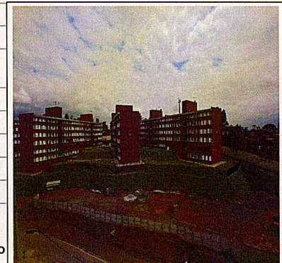
Praça Cond. C - serviços em andamento.
