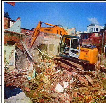
Sapé A: Demolição de moradias.
