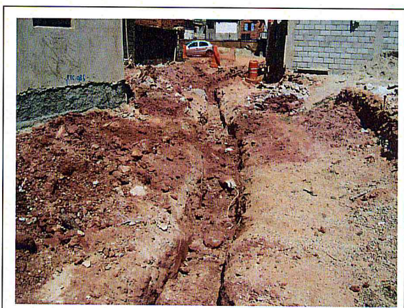
FOTO 2 – Área 157 - Vila Rubi - Rua Projetada 1
