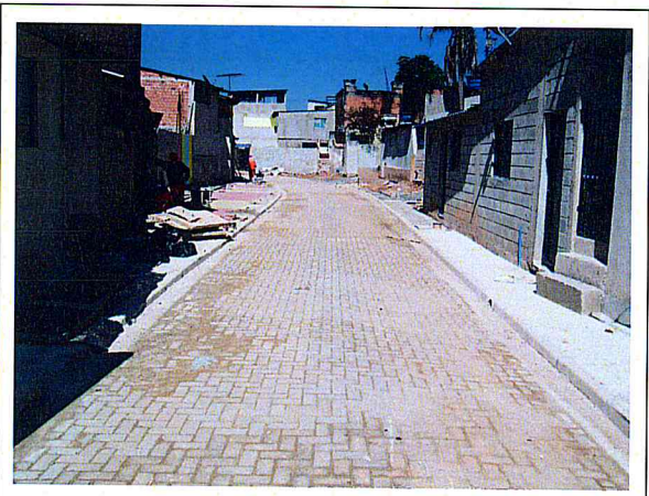
FOTO 3 – Área 157 - Vila Rubi - Rua Projetada 1
