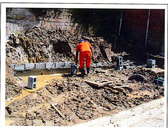
FOTO 4 – Área 157 - Vila Rubi - Rua Projetada 1
