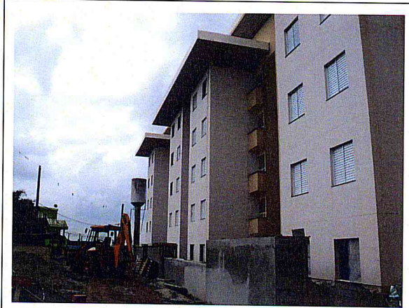
FOTO 2 – Área 173 - Conjunto Habitacional Mata Virgem – Prédio 2
