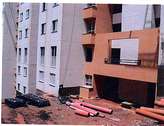
FOTO 5 – Área 173 - Conjunto Habitacional Mata Virgem – Prédio 5
