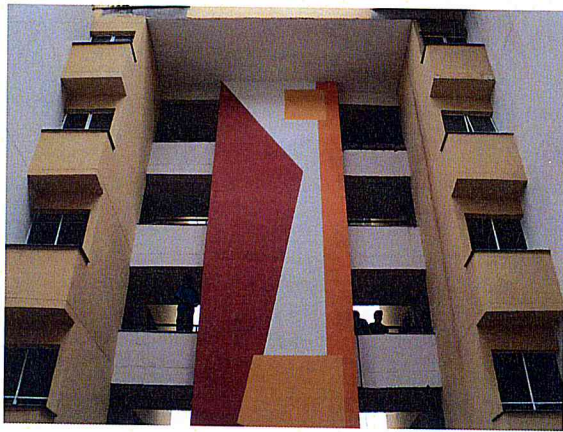
FOTO 1 – Área 173 - Conjunto Habitacional Mata Virgem – Prédio 1
