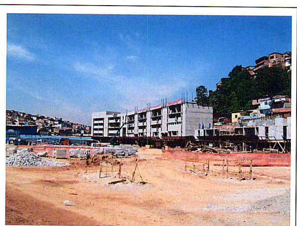
FOTO 4 – Área 183 - Boulevard da Paz - Unidades Habitacionais
