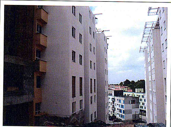
FOTO 4 – Área 173 - Conjunto Habitacional Mata Virgem – Prédio 4
