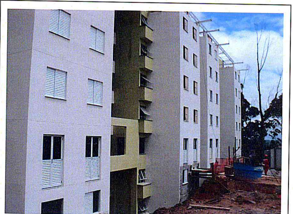
FOTO 6 – Área 173 - Conjunto Habitacional Mata Virgem – Prédio 6
