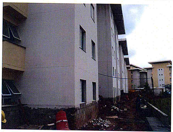
FOTO 3 – Área 173 - Conjunto Habitacional Mata Virgem – Prédio 3
