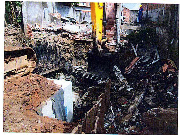
FOTO 2 – Área 185 - Jd Novo Marilda - Rua Projetada 8
