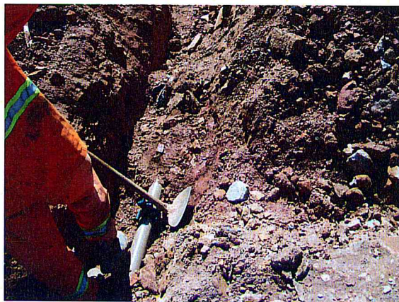
FOTO 1 – Área 157 - Vila Rubi - Rua Projetada 1
