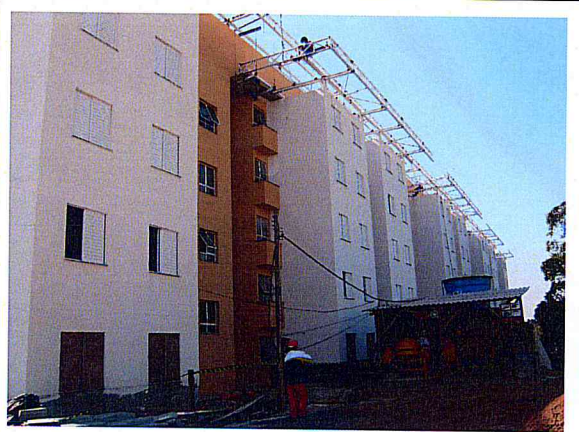
FOTO 5 – Área 173 - Conjunto Habitacional Mata Virgem – Prédio 5
