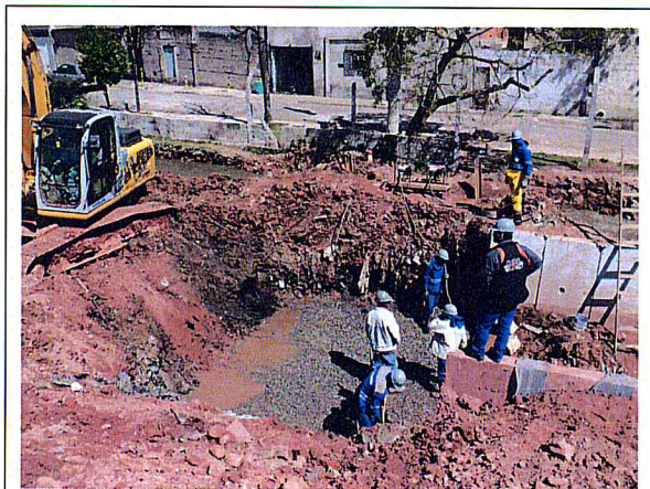
FOTO 1 - Área 174 - Cidade Júlia - Córrego Apucás
