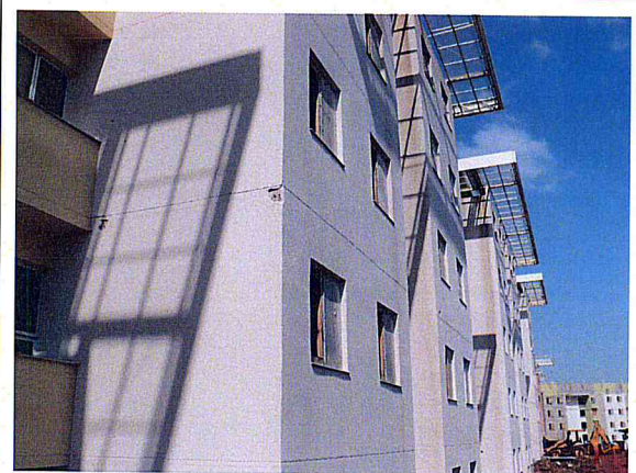
FOTO 3 – Área 173 - Conjunto Habitacional Mata Virgem – Prédio 3
