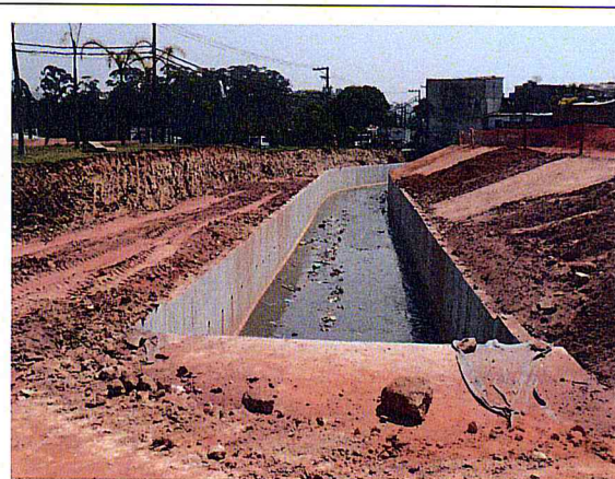
FOTO 2 - Área 174 - Cidade Júlia - Córrego Apucás
