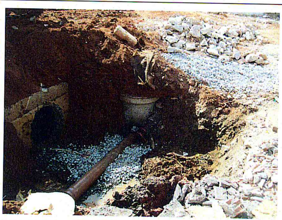
FOTO 1 – Área 185 - Jd Novo Marilda - Rua Projetada 8
