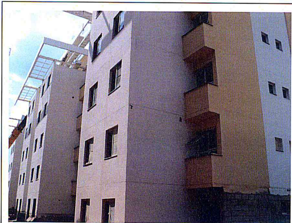
FOTO 1 – Área 173 - Conjunto Habitacional Mata Virgem – Prédio 1
