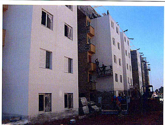
FOTO 4 – Área 173 - Conjunto Habitacional Mata Virgem – Prédio 4
