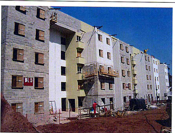
FOTO 6 – Área 173 - Conjunto Habitacional Mata Virgem – Prédio 6
