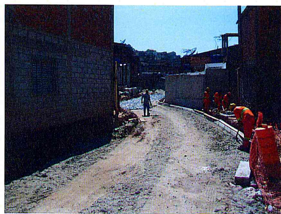
FOTO 2 – Área 157 - Vila Rubi - Rua Projetada 1
