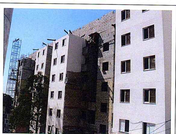
FOTO 4 – Área 173 - Conjunto Habitacional Mata Virgem – Prédio 4
