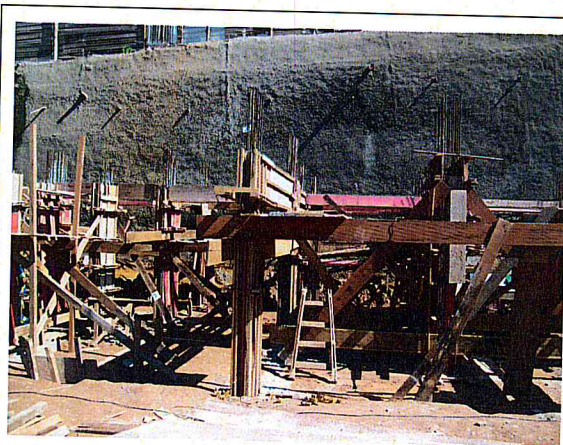
FOTO 5 – Área 183 - Boulevard da Paz - Unidades Habitacionais
