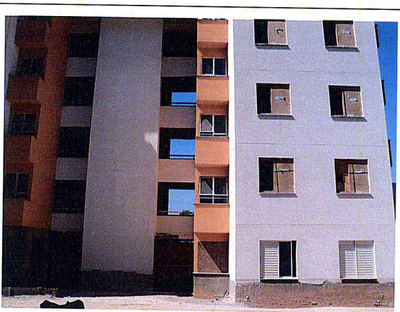
FOTO 5 – Área 173 - Conjunto Habitacional Mata Virgem – Prédio 5
