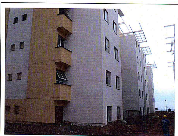
FOTO 2 – Área 173 - Conjunto Habitacional Mata Virgem – Prédio 2
