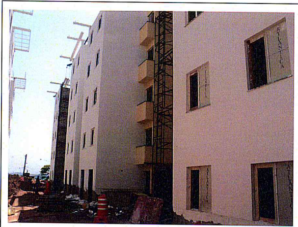
FOTO 1 – Área 173 - Conjunto Habitacional Mata Virgem – Prédio 1
