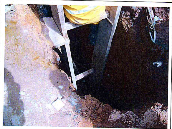
FOTO 4 – Área 172 - Arizona - Rua Sabóia
