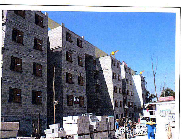
FOTO 6 – Área 173 - Conjunto Habitacional Mata Virgem – Prédio 6
