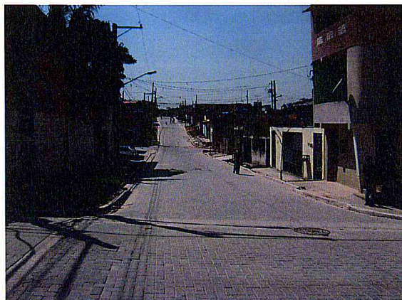
FOTO 1 – Área 231 - Condomínio Vargem Grande - Rua Bem Te Vi
