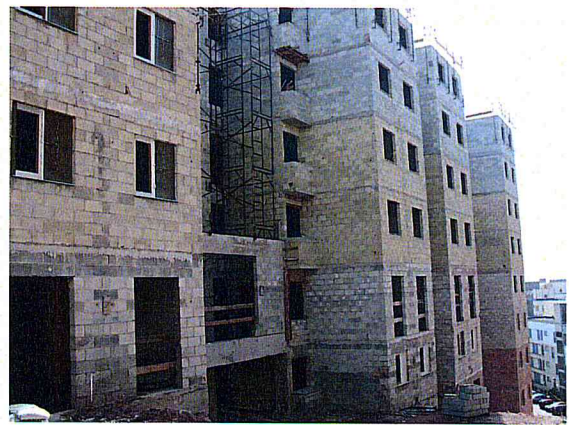
FOTO 4 – Área 173 - Conjunto Habitacional Mata Virgem – Prédio 4
