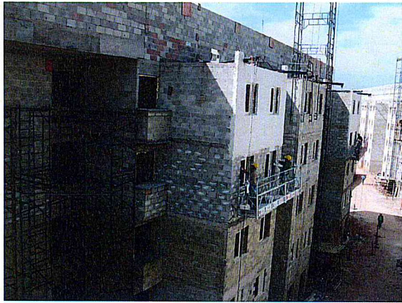
FOTO 1 – Área 173 - Conjunto Habitacional Mata Virgem – Prédio 1
