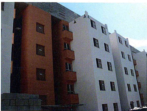
FOTO 5 – Área 173 - Conjunto Habitacional Mata Virgem – Prédio 5
