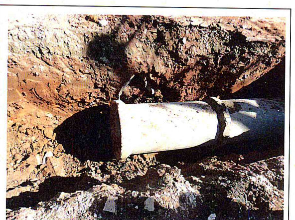
FOTO 6 – Área 183 - Boulevard da Paz - Rua Berthelot
