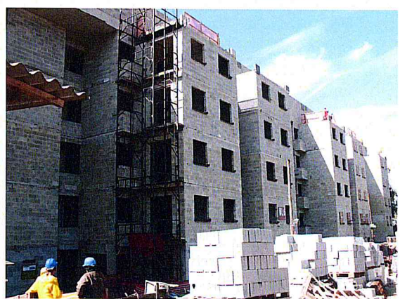
FOTO 6 – Área 173 - Conjunto Habitacional Mata Virgem – Prédio 6
