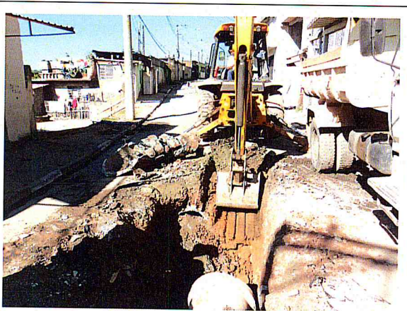
FOTO 5 – Área 183 - Boulevard da Paz - Rua Berthelot
