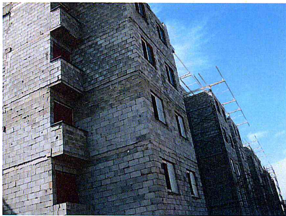
FOTO 3 – Área 173 - Conjunto Habitacional Mata Virgem – Prédio 3
