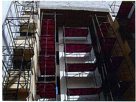
FOTO 2 – Área 173 - Conjunto Habitacional Mata Virgem – Prédio 2
