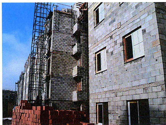
FOTO 2 – Área 173 - Conjunto Habitacional Mata Virgem – Prédio 2
