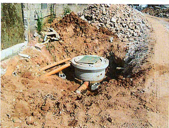
FOTO 6 – Área 157 - Vila Rubi - Rua Projetada 1
