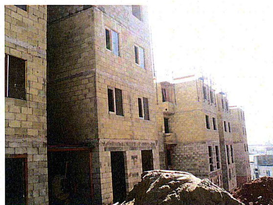
FOTO 4 – Área 173 - Conjunto Habitacional Mata Virgem – Prédio 4
