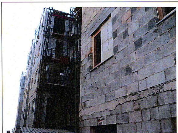
FOTO 1 – Área 173 - Conjunto Habitacional Mata Virgem – Prédio 1
