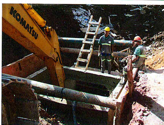
FOTO 4 – Área 157 - Vila Rubi - Rua Projetada 1
