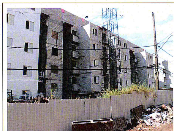
FOTO 3 – Área 173 - Conjunto Habitacional Mata Virgem – Prédio 3
