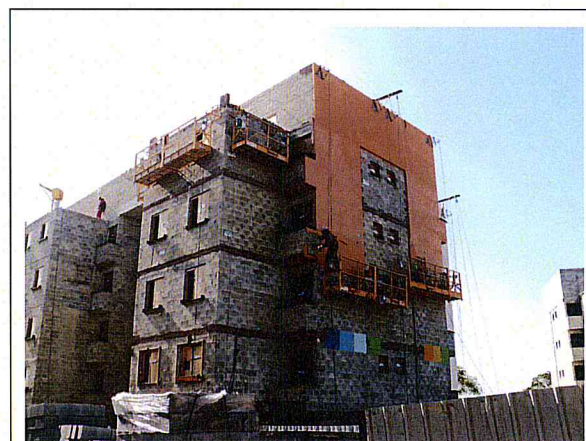
FOTO 5 – Área 173 - Conjunto Habitacional Mata Virgem – Prédio 5
