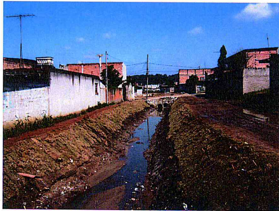
FOTO 1 – Área 231 - Condomínio Vargem Grande - Rua Coqueiros
