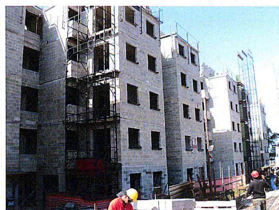
FOTO 6 – Área 173 - Conjunto Habitacional Mata Virgem – Prédio 6
