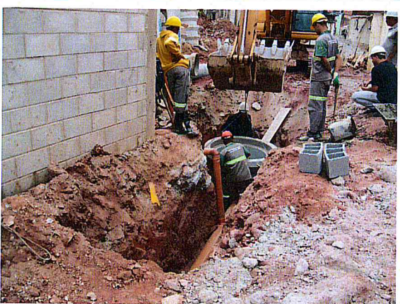
FOTO 5 – Área 157 - Vila Rubi - Rua Projetada 1
