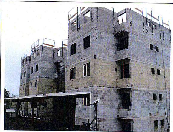
FOTO 3 – Área 173 - Conjunto Habitacional Mata Virgem – Prédio 4
