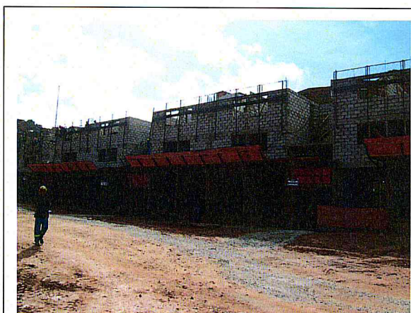
FOTO 2 – Área 183 - Boulevard da Paz - Unidades Habitacionais
