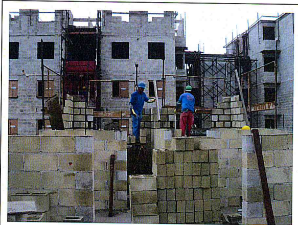
FOTO 4 – Área 173 - Conjunto Habitacional Mata Virgem – Prédio 5
