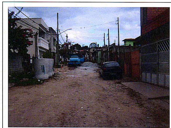
FOTO 4 – Área 231 - Condomínio Vargem Grande - Rua Macieira
