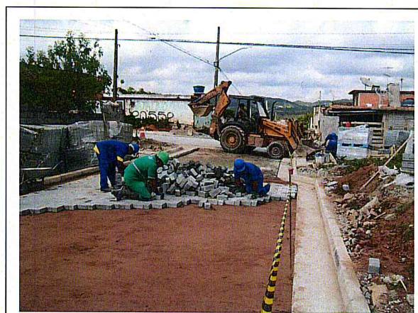
FOTO 6 – Área 231 - Condomínio Vargem Grande - Rua Paineiras
