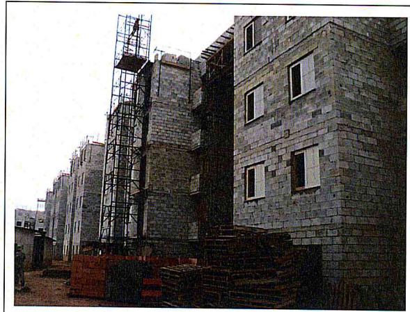
FOTO 2 – Área 173 - Conjunto Habitacional Mata Virgem – Prédio 3
