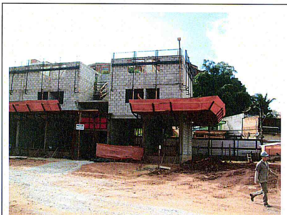
FOTO 1 – Área 183 - Boulevard da Paz - Unidades Habitacionais
