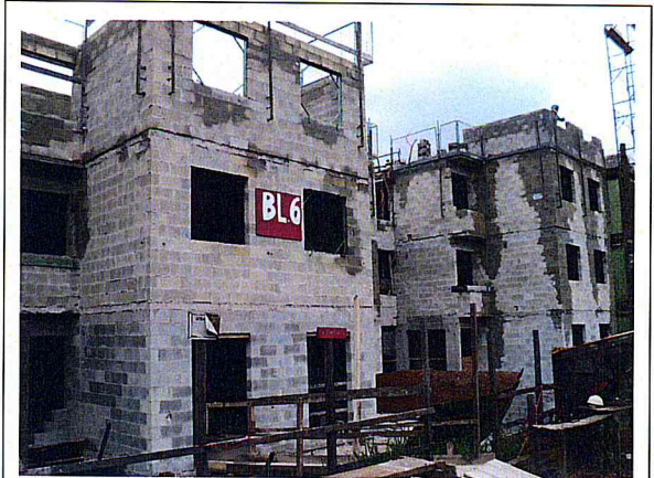
FOTO 6 – Área 173 - Conjunto Habitacional Mata Virgem – Prédio 6
