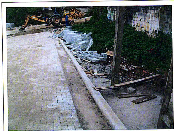
FOTO 1 – Área 231 - Condomínio Vargem Grande - Rua das Figueiras
