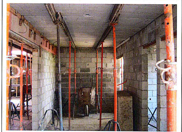
FOTO 4 – Área 173 - Conjunto Habitacional Mata Virgem – Prédio 4
