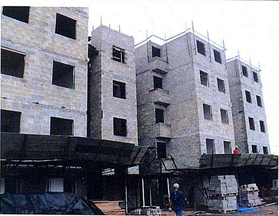
FOTO 5 – Área 173 - Conjunto Habitacional Mata Virgem – Prédio 5
