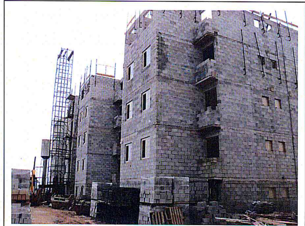
FOTO 2 – Área 173 - Conjunto Habitacional Mata Virgem – Prédio 2
