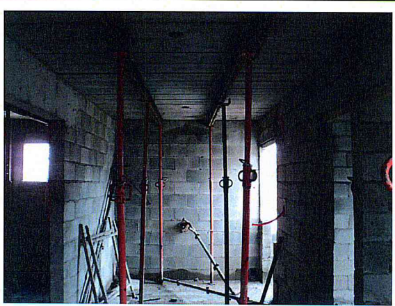
FOTO 1 – Área 173 - Conjunto Habitacional Mata Virgem – Prédio 1
