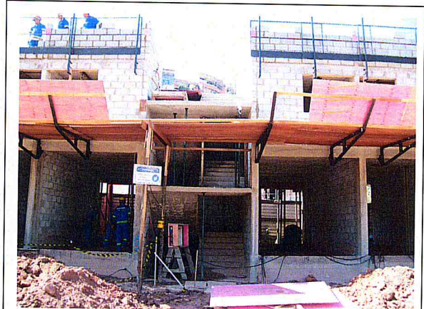
FOTO 4 – Área 183 - Boulevard da Paz - Unidades Habitacionais
