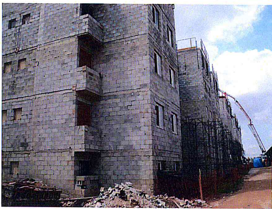
FOTO 3 – Área 173 - Conjunto Habitacional Mata Virgem – Prédio 3
