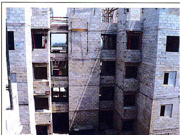
FOTO 2 – Área 173 - Conjunto Habitacional Mata Virgem – Prédio 2
