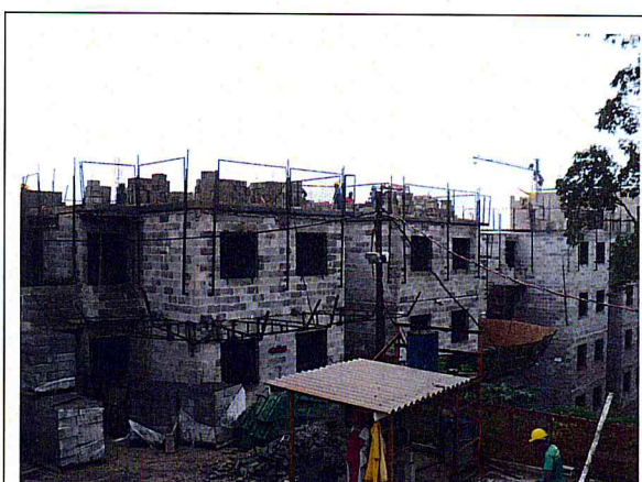
FOTO 4 – Área 173 - Conjunto Habitacional Mata Virgem – Prédio 4
