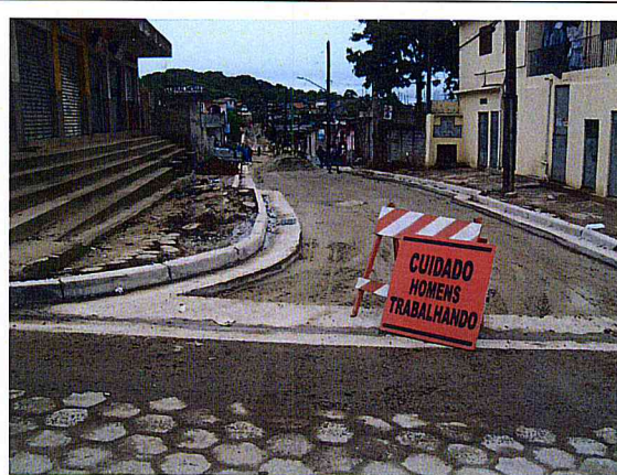
FOTO 4 – Área 231 - Condomínio Vargem Grande - Rua das Figueiras
