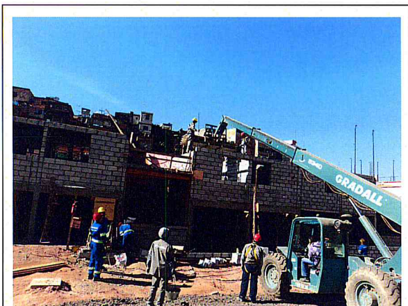
FOTO 1 – Área 183 - Boulevard da Paz - Unidades Habitacionais
