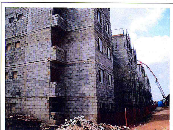
FOTO 3 – Área 173 - Conjunto Habitacional Mata Virgem – Prédio 3
