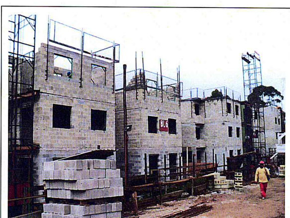
FOTO 6 – Área 173 - Conjunto Habitacional Mata Virgem – Prédio 6
