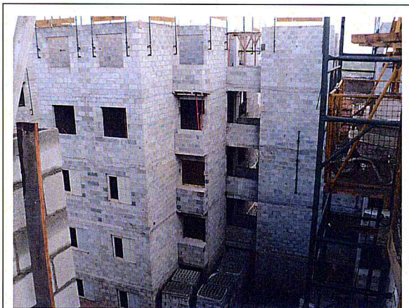
FOTO 1 – Área 173 - Conjunto Habitacional Mata Virgem – Prédio 1
