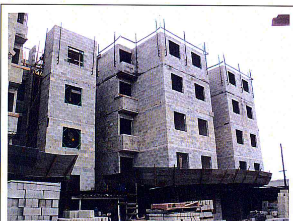
FOTO 5 – Área 173 - Conjunto Habitacional Mata Virgem – Prédio 5
