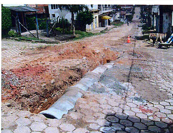
FOTO 3 – Área 231 - Condomínio Vargem Grande - Rua Sabiá
