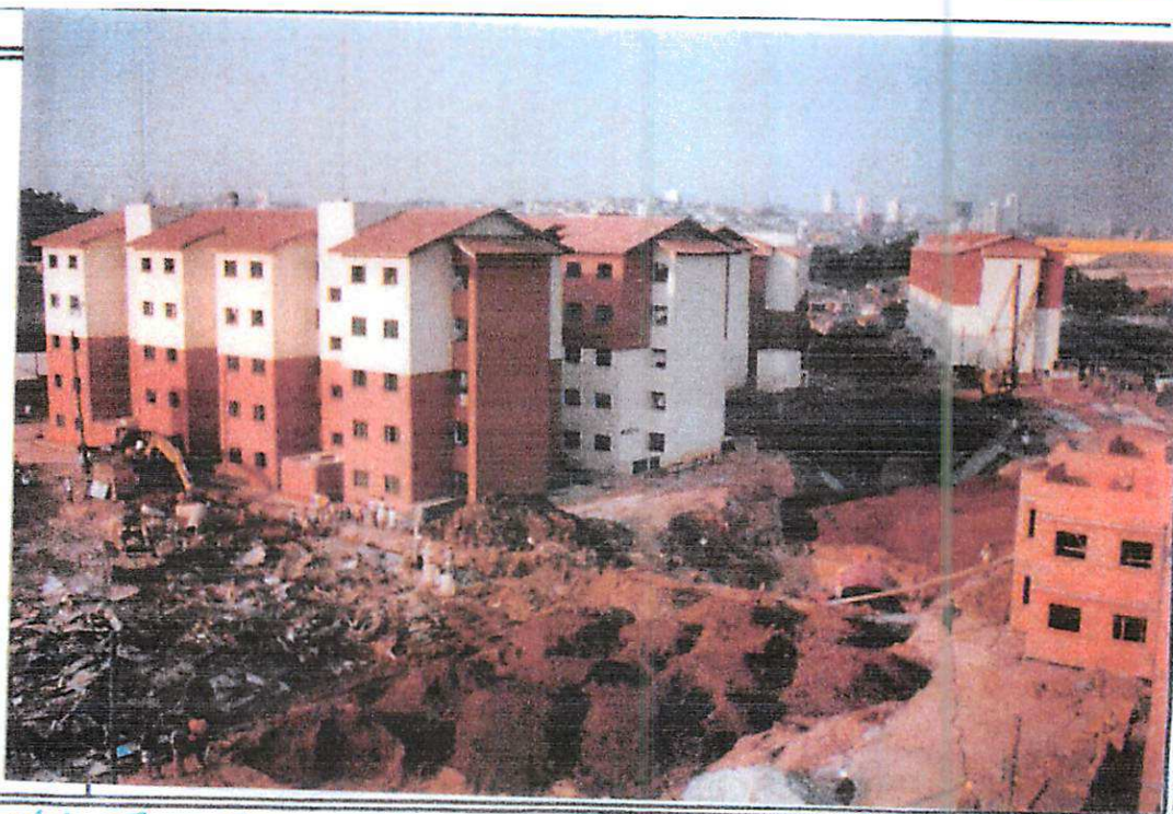
atraso do concreto
