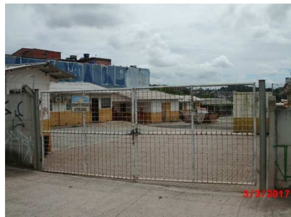
LOTE 3 – CANTEIRO DE OBRAS
