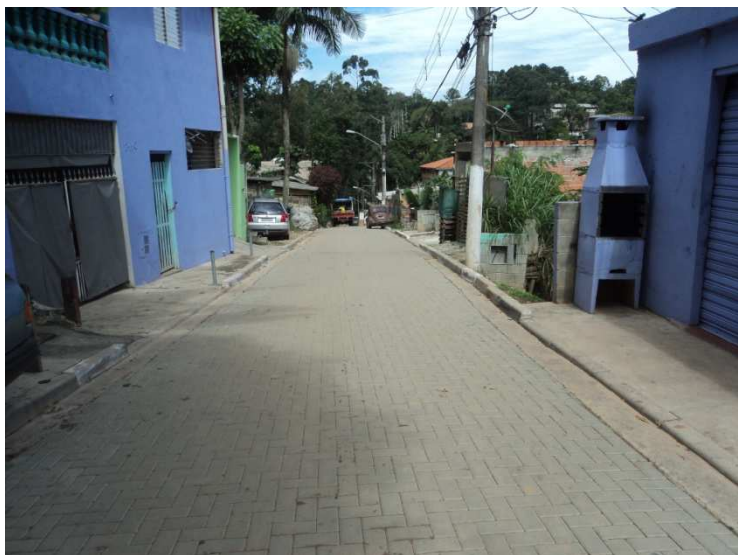
LOTE 5 – PAVIMENTAÇÃO DA RUA CÔNEGO JOSÉ
