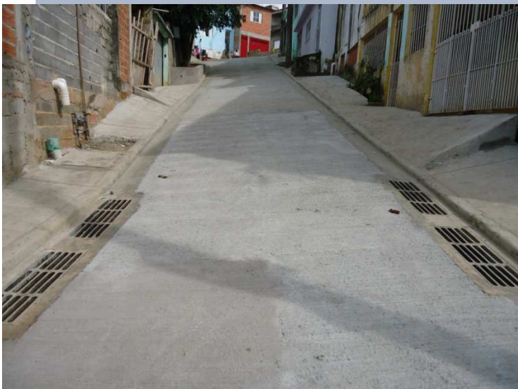
LOTE 7 – PAVIMENTAÇÃO DA RUA SÃO RAFAEL
