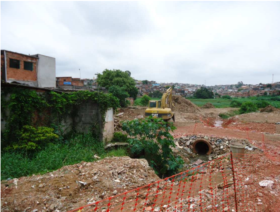
LOTE 6 – VILA BREJINHO – LIMPEZA E REMOÇÃO DE ENTULHO
