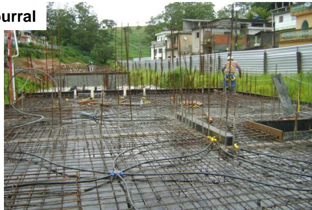
Laje piso do 2º pavimento (armação) – Bloco C
