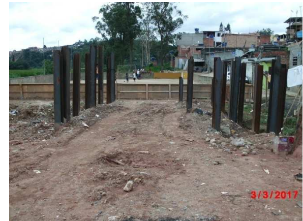
LOTE 3 – ESTAÇÃO ELEVATÓRIA
