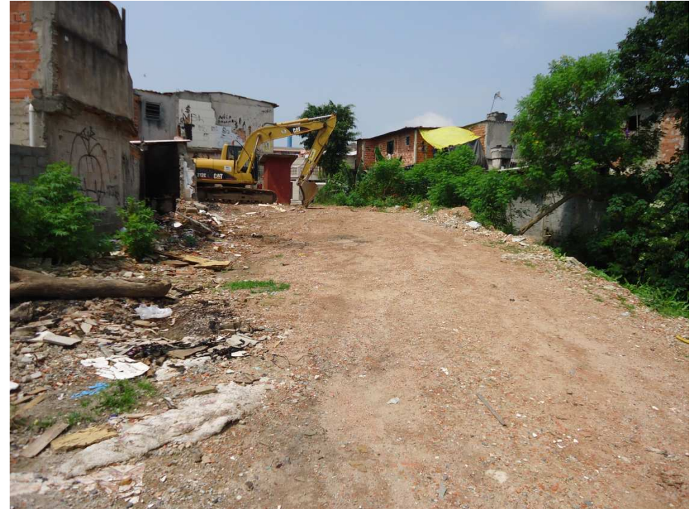
LOTE 6 – VILA BREJINHO – DEMOLIÇÃO MECÂNICA DE CONCRETO ARMADO
