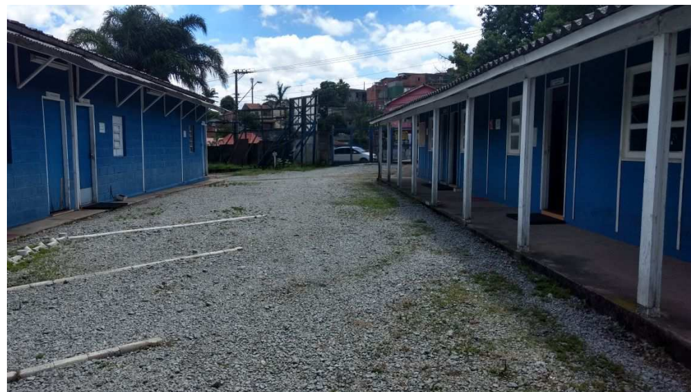
LOTE 2 – CANTEIRO DE OBRAS
