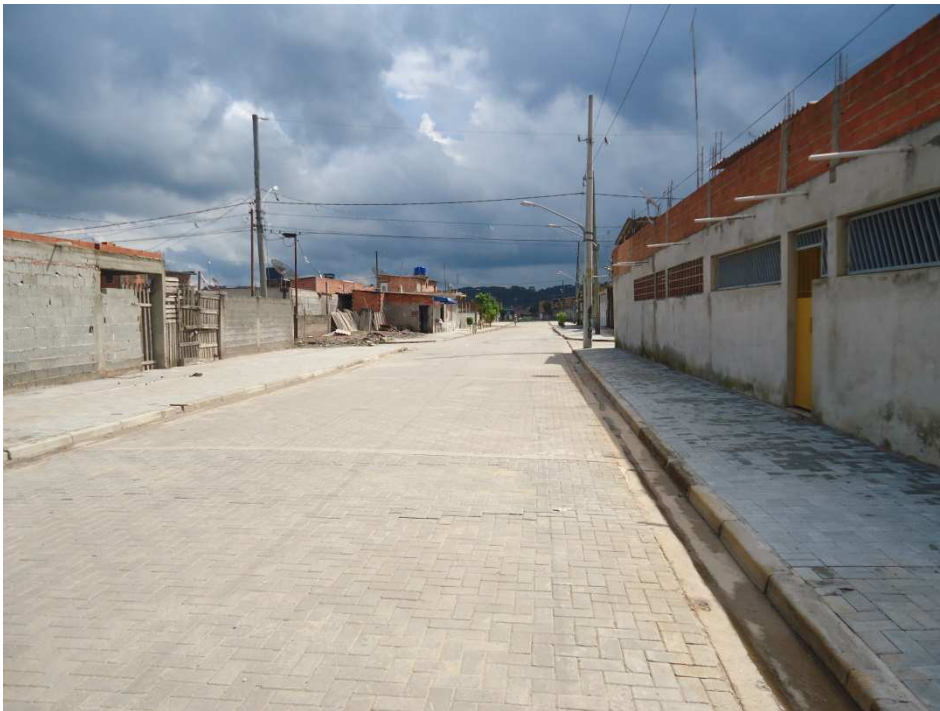
LOTE 8 – RUA DOS COQUEIROS - INTERTRAVADO
