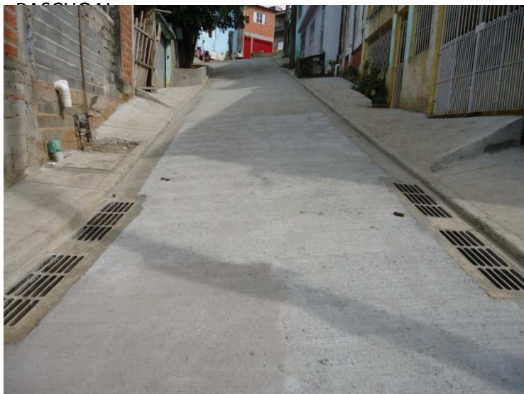
LOTE 5 – PAVIMENTAÇÃO DA RUA SÃO RAFAEL
