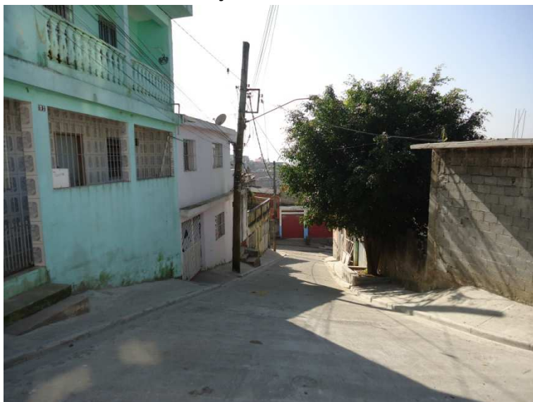
LOTE 7 – PAVIMENTAÇÃO DA RUA SÃO JOSÉ
