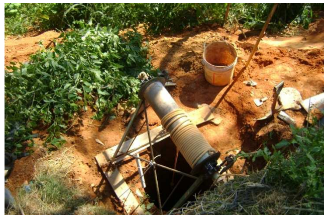
Tubulão para muro de contenção da Rua Projetada
