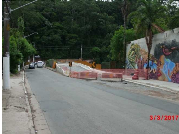
LOTE 3 – PONTE ARACATI
