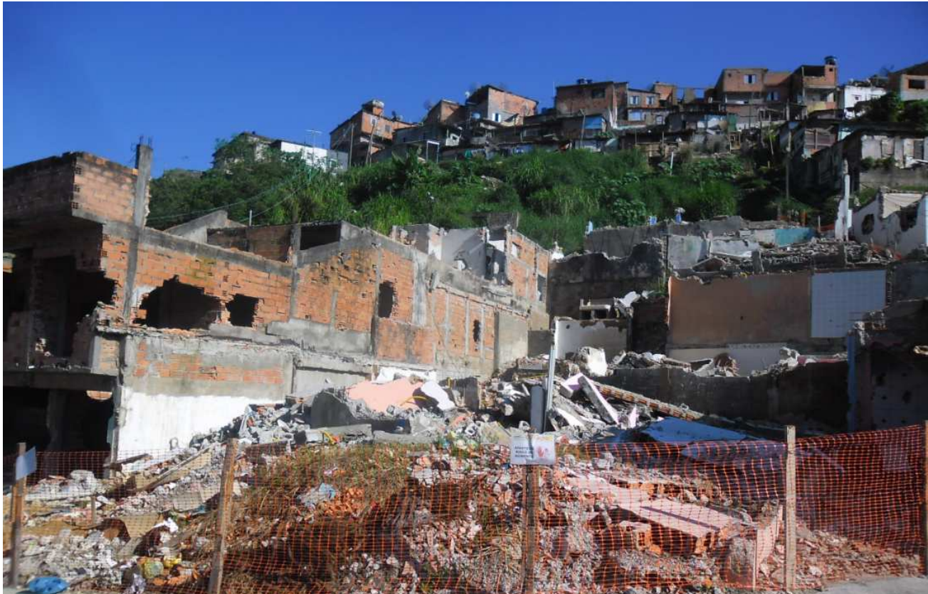
LOTE 1 – DEMOLIÇÃO DAS CASAS N- 03 00 14 A, B, C, D, E, e F
