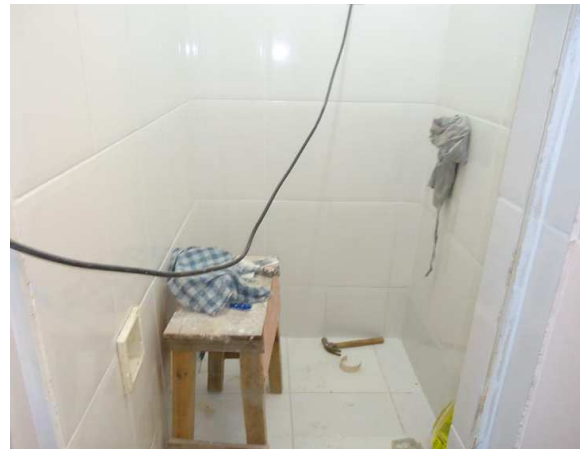
Execução de limpeza e colocação de louças e metais sanitários
