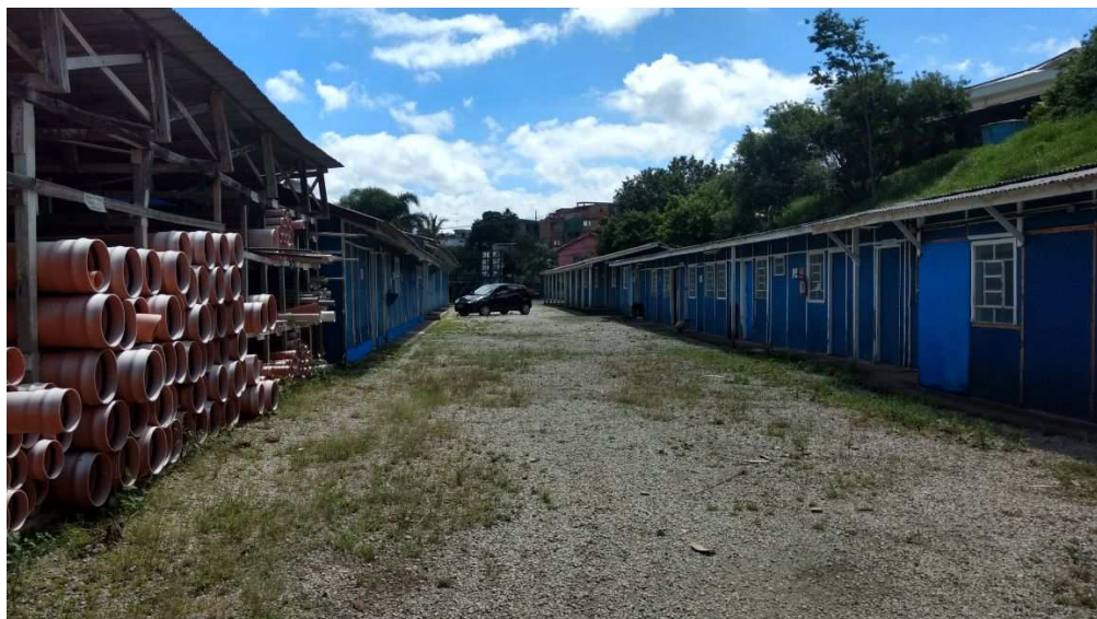
LOTE 2 – CANTEIRO DE OBRAS
