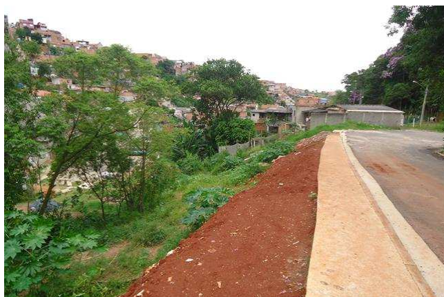
Rua da Bica – Retaludamento para plantio de grama
