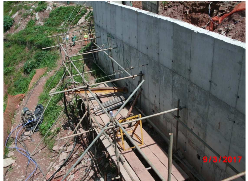
LOTE 4 – MONTAGEM DE ANDAIMES PARA EXECUÇÃO DE TIRANTES
