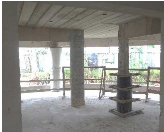
Condomínio 4 – Pavimento de acesso da passarela
