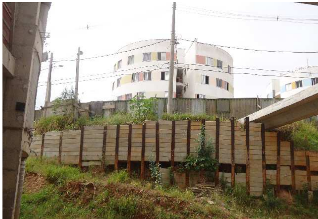
Condomínio 4 – Muro de arrimo junto a via de acesso
