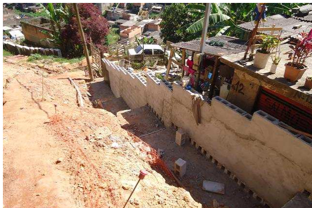
Rua Catazetum – Execução de muro de arrimo
