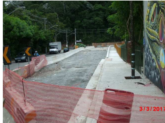
LOTE 3 – PONTE ARACATI
