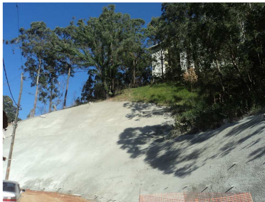
LOTE 5 – CONSOLIDAÇÃO DO TALUDE NA ESTRADA DA ENCOSTA
