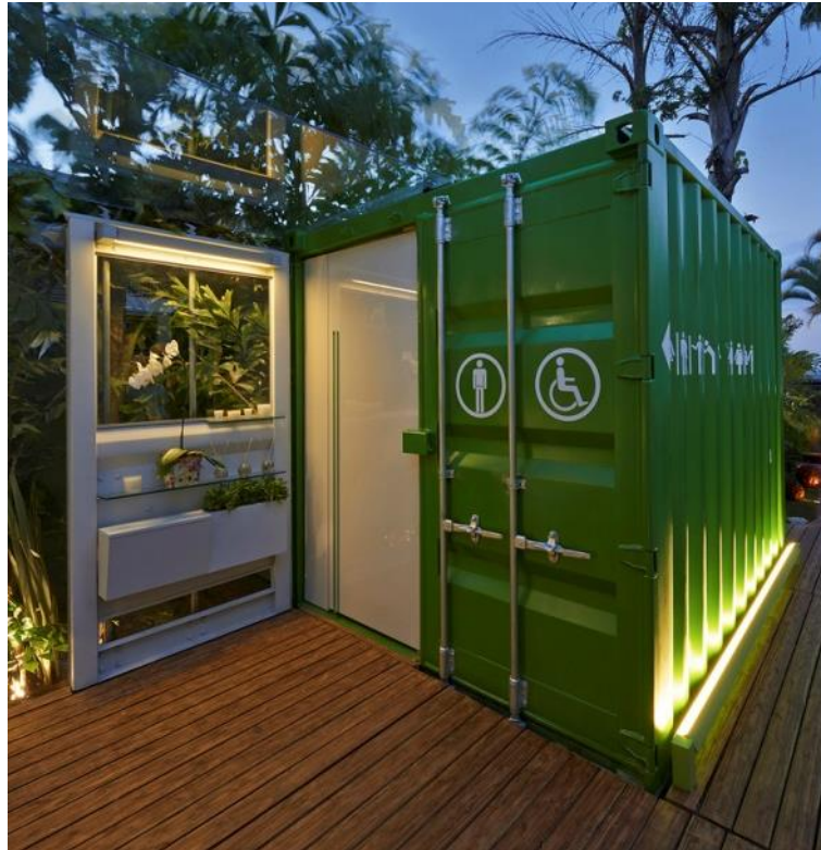
Figura 10 - Banheiros Ecotransportáveis em Belo Horizonte. Fonte: https://www.archdaily.com.br
