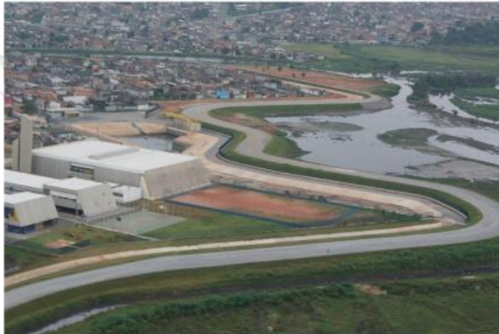
Dique e piscinão no Jardim Romano
