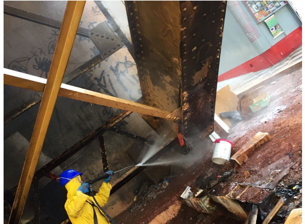
Módulo 1 (sobre Rua Brigadeiro Tobias): jateamento com água quente
