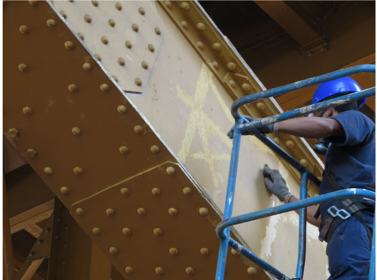
Módulo 2 (sobre Terminal de ônibus Pedro Lessa): lixamento manual
