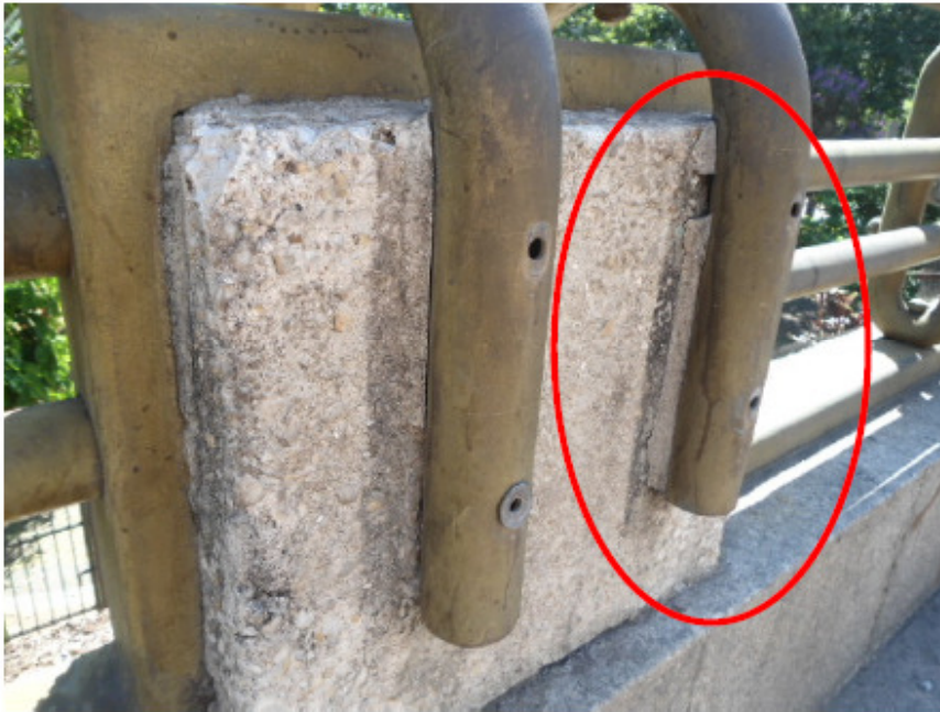
Figura 10. Notar completamente inadequado de argamassa entre o arco metálico e o pilarete. Foto: Mahyra A. N. de Araújo, 2014.
