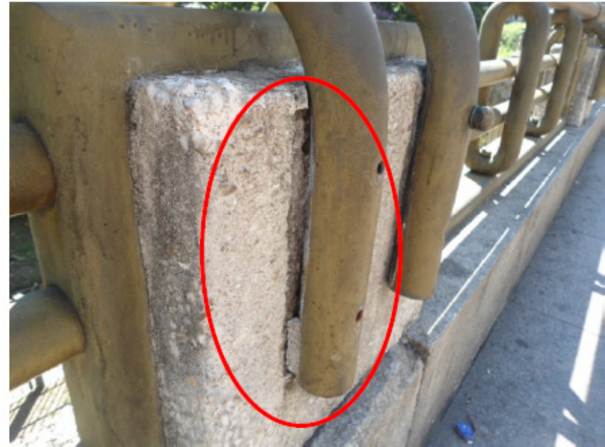
Figura 11. Notar perda do completamento de argamassa entre o arco metálico e o pilarete. Foto: Mahyra A. N. de Araújo, 2014.
