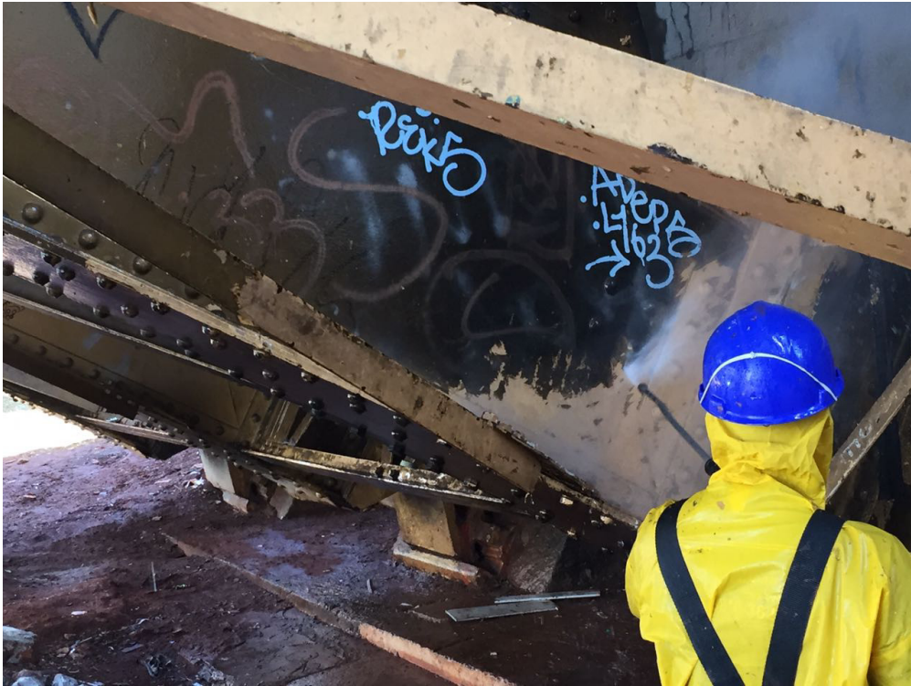
Módulo 1 (sobre Rua Brigadeiro Tobias): jateamento com água quente
