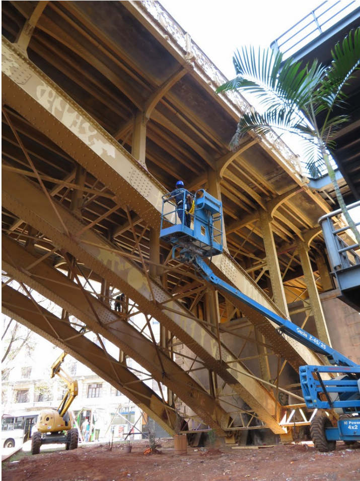
Módulo 2 (sobre Terminal de ônibus Pedro Lessa): lixamento manual
