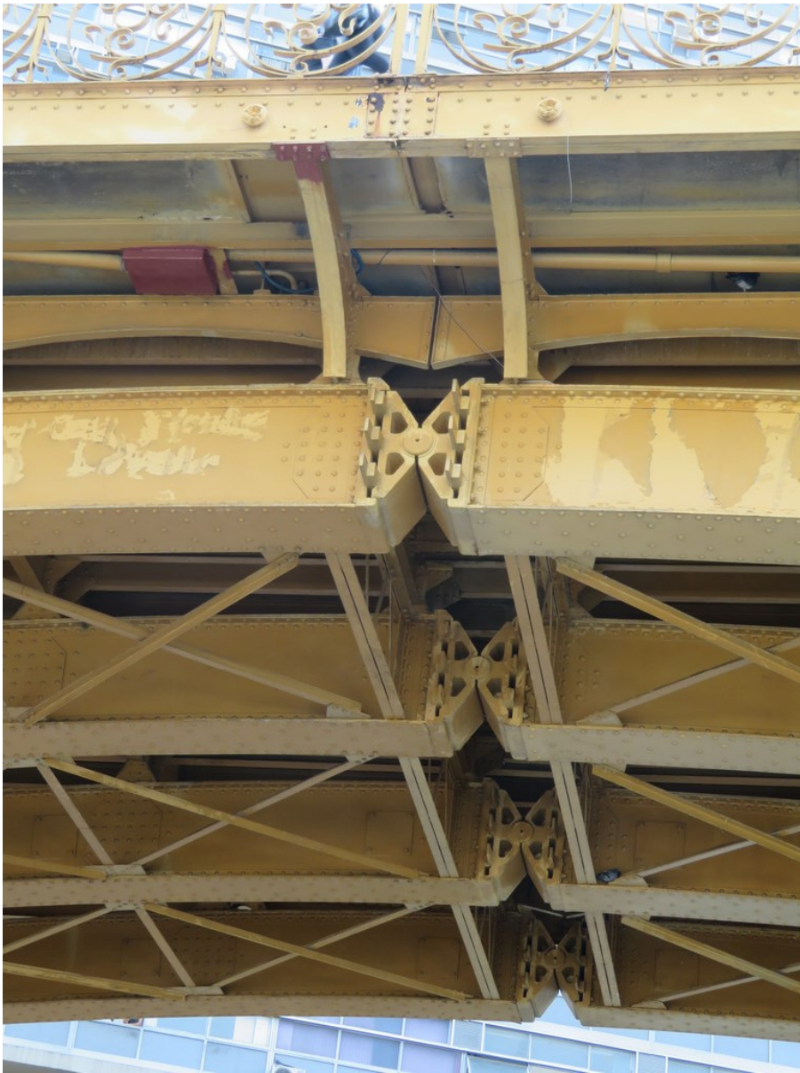
Módulo 2 (sobre Terminal de ônibus Pedro Lessa): superfície após lavagem e lixamento
