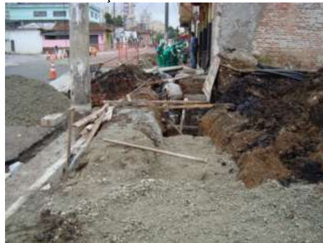
Enterramento de eletrodutos para sinalização semafórica
