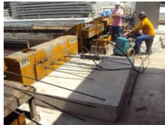
Protenção de laje alveolar executada
