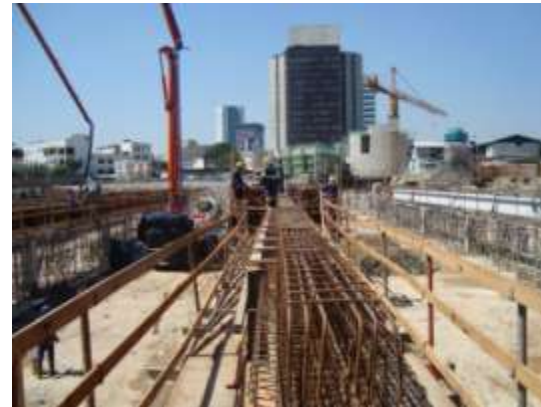
Execução de vigas do Terminal Capri
