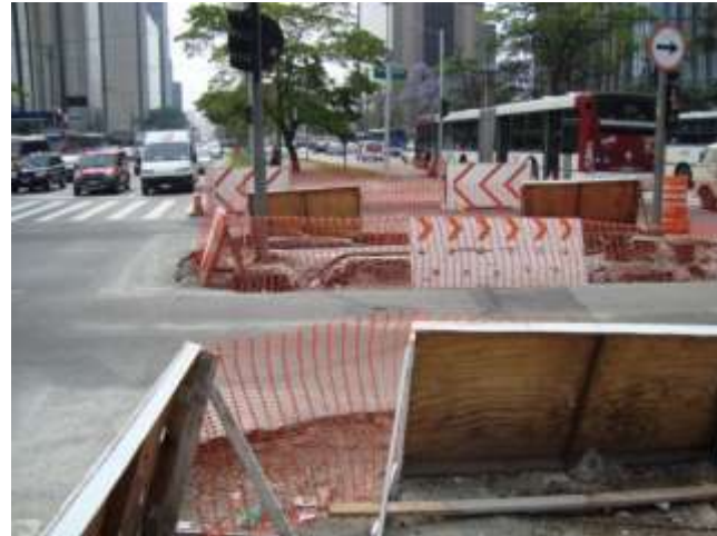
Demolição das ilhas na esquina da Av. Faria Lima com Av. Rebouças
