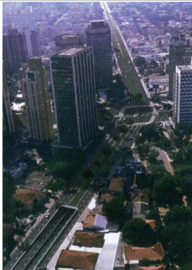
Passagem em desnível das Av. Faria Lima x Av. Rebouças x Av. Eusébio Matoso
