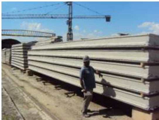
Laje alveolar executada para o Terminal Capri
