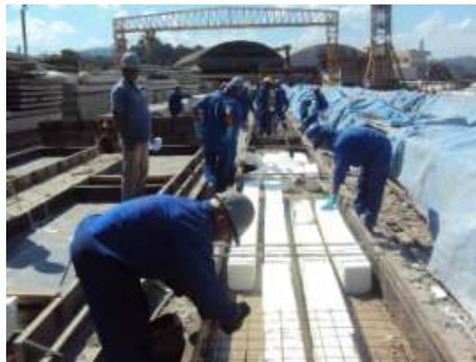
Montagem de forma para concretagem de laje alveolar
