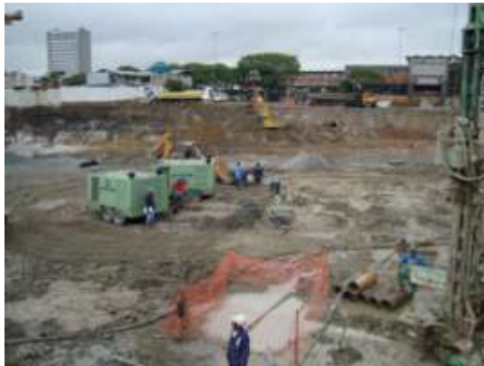
Escavação de estacas de fundação da garagem subterrânea
