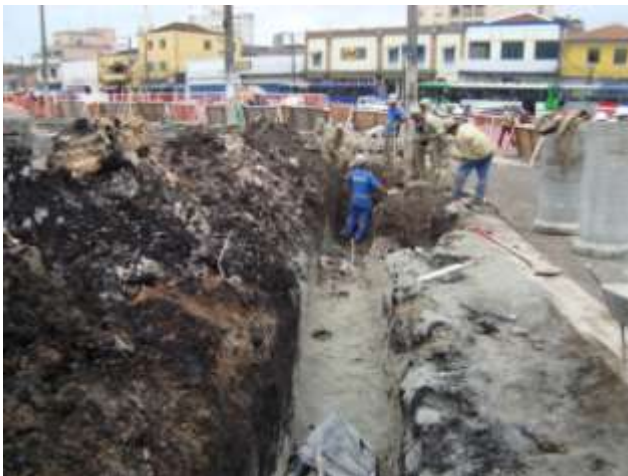
Enterramento de eletrodutos para sinalização semafórica
