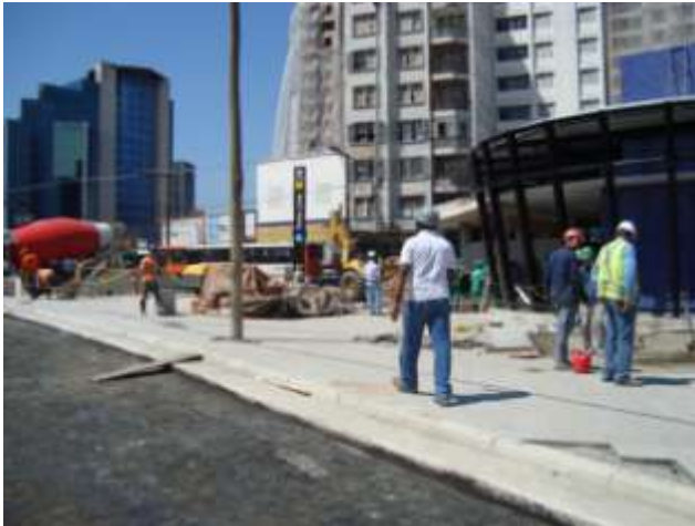
Assentamento de granito em frente a Estação Faria Lima
