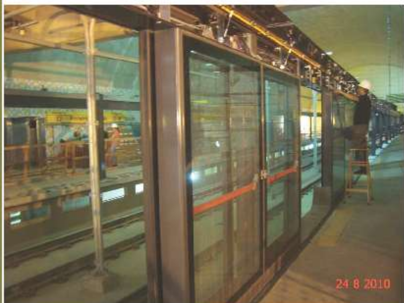
Montagem das portas de plataforma.
