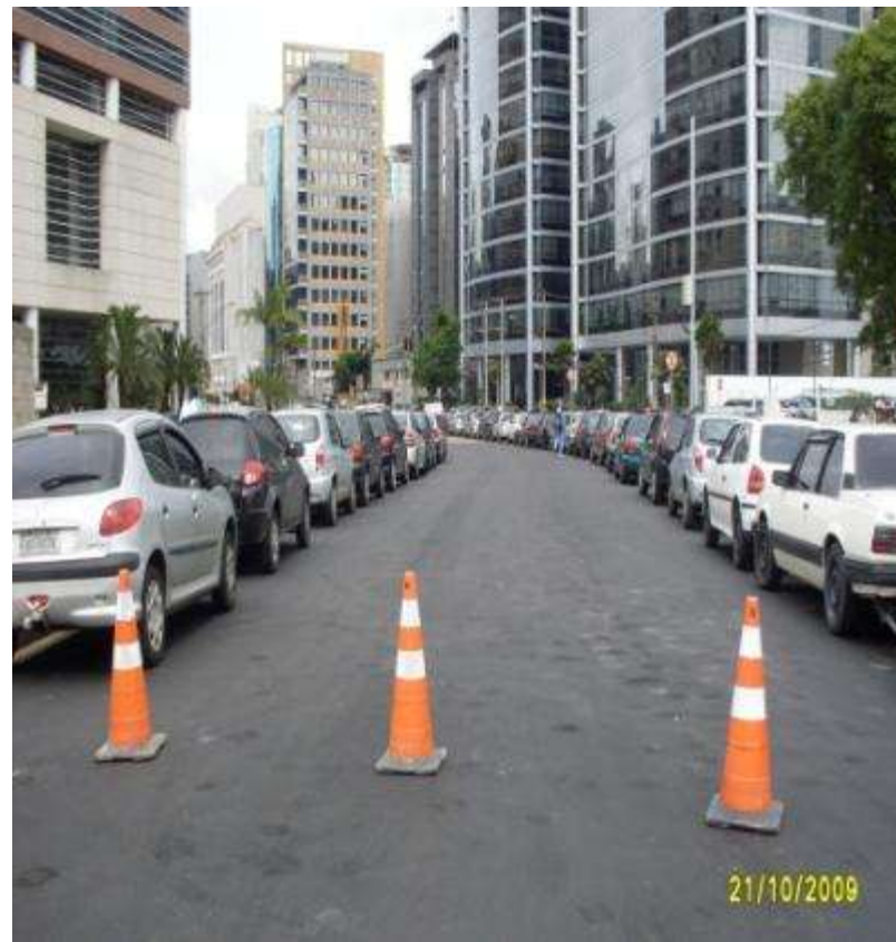
PAVIMENTAÇÃO NA RUA OLIMPIADAS
