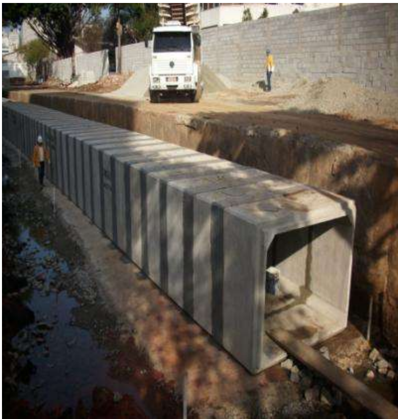
EXECUÇÃO DE GALERIA NO RAMO 200
