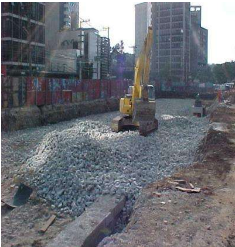
GOMES DE CARVALHO - EXECUÇÃO DE REFORÇO DE SUB-LEITO TERRENO VINICOLA AURORA
