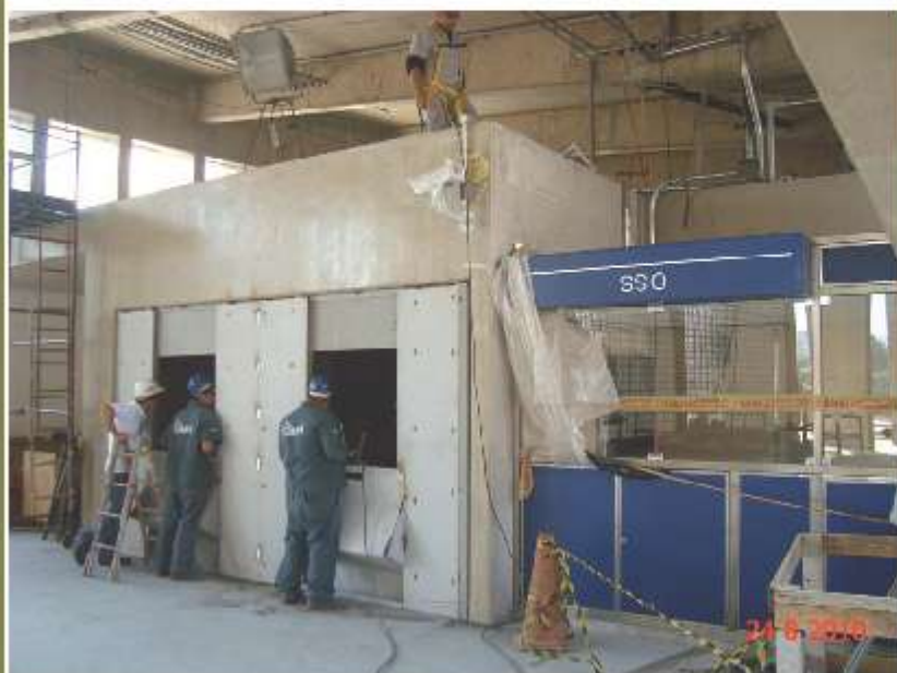
Montagem de bilheteria blindada.
