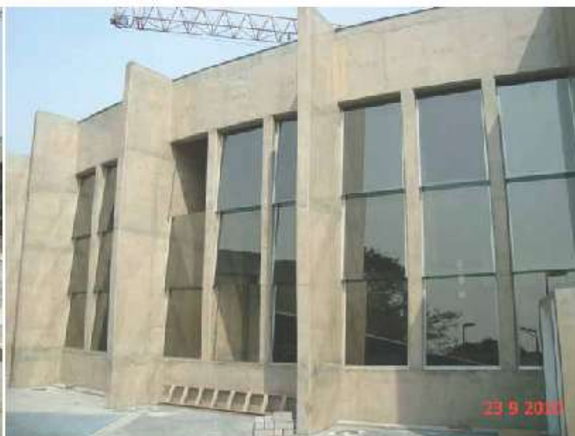
Colocação de veneziana fixa de vidro.
