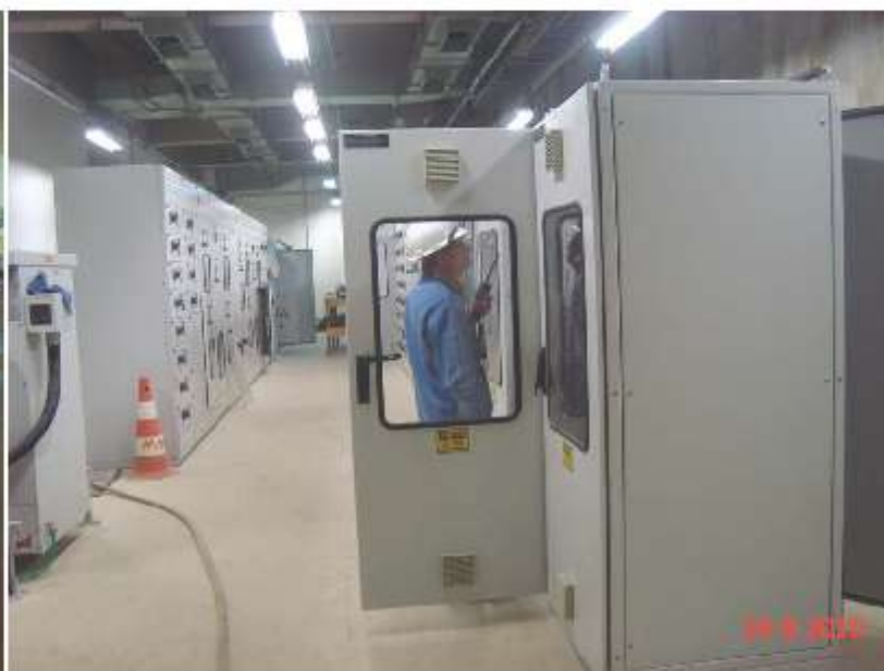
Instalação de equipamentos de sistemas.
