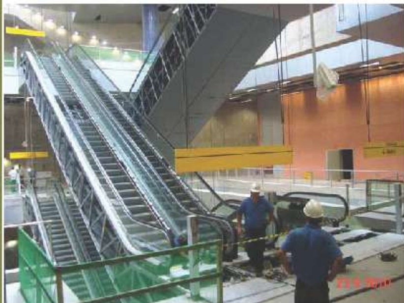
Montagem de escada rolante.
