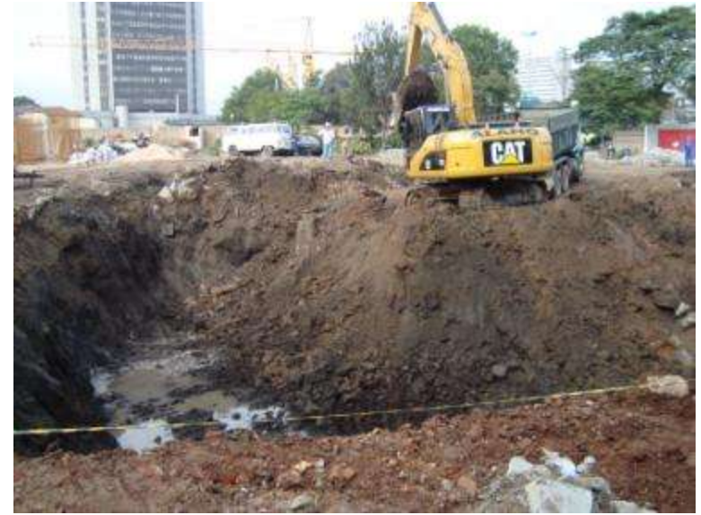
Terminal Capri – início de escavação
