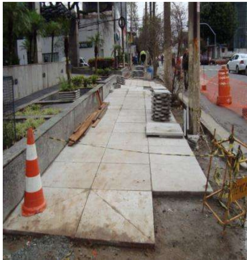
EXECUÇÃO DE PASSEIO PRÉ-MOLDADA NA RUA GOMES DE CARVALHO
