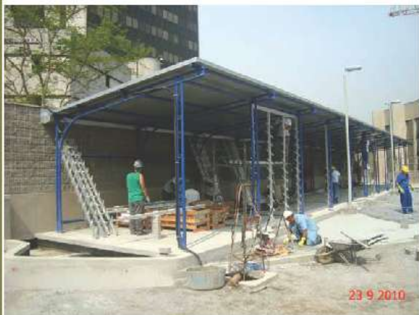
Execução do piso junto ao bicicletário.
