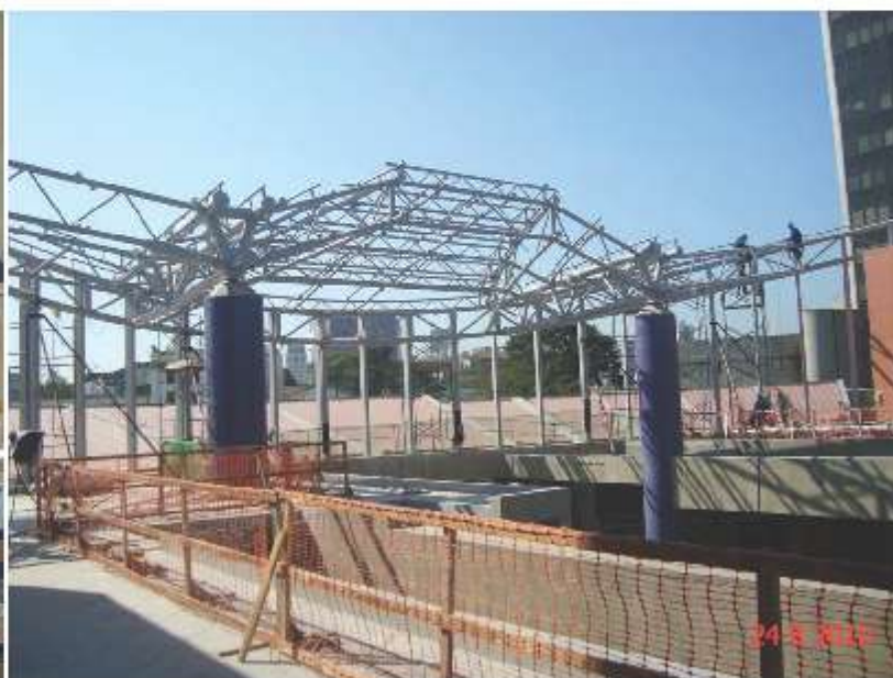
Cobertura metálica em execução.
