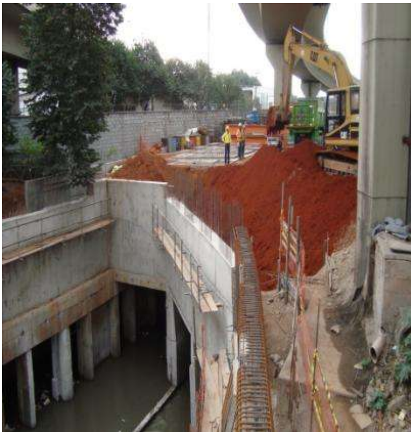
EXECUÇÃO DE LAJE DE COBERTURA DA GALERIA TRAIÇÃO
