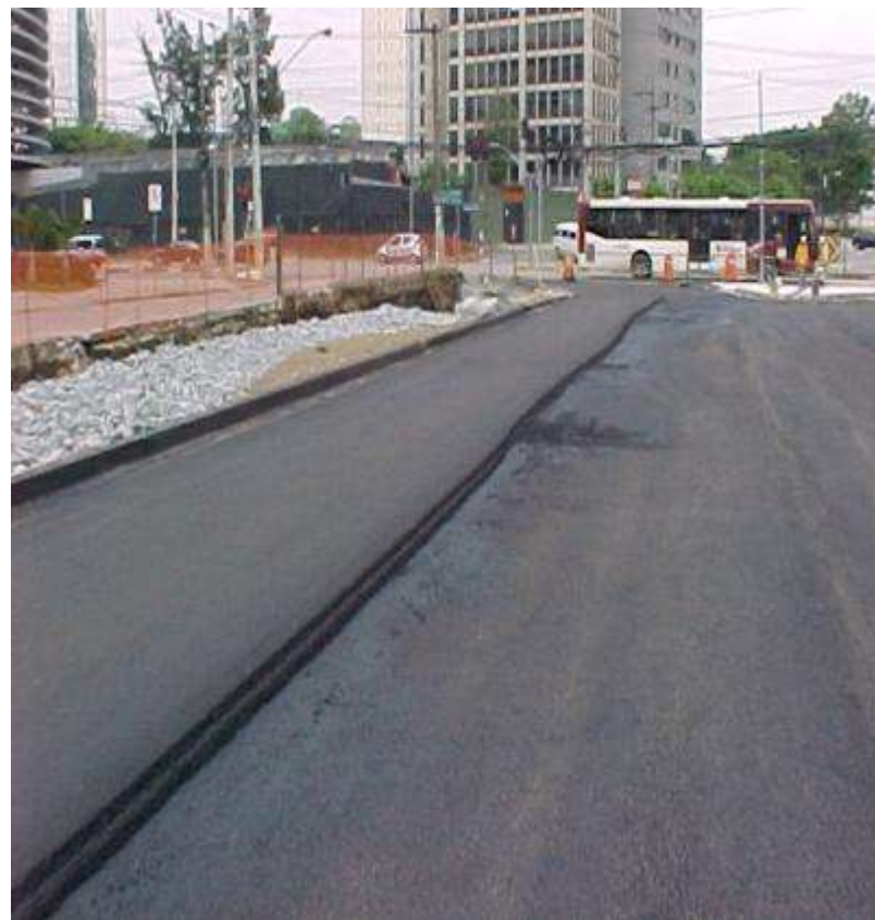
PAVIMENTAÇÃO RUA GOMES DE CARVALHO
