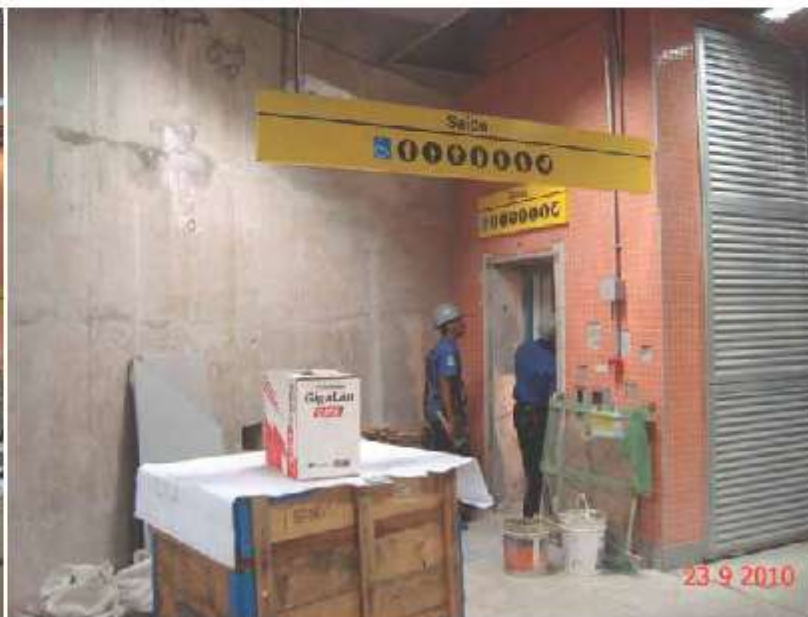
Montagem de elevador.
