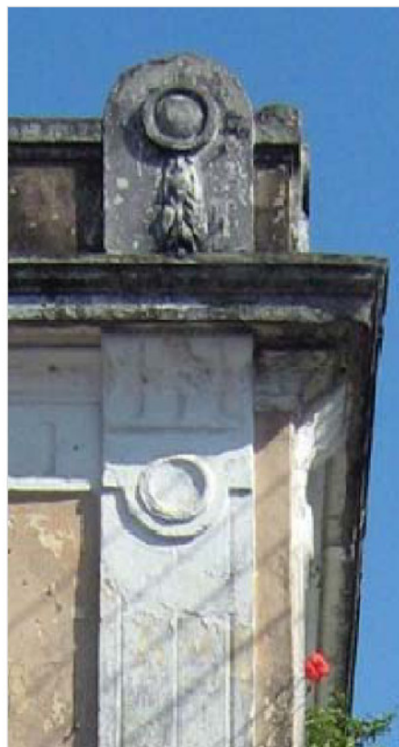
FOTO SITUAÇÃO ATUAL FONTE: DPH
