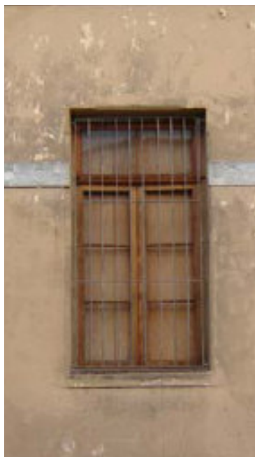
FOTO SITUAÇÃO ATUAL FONTE: DPH
