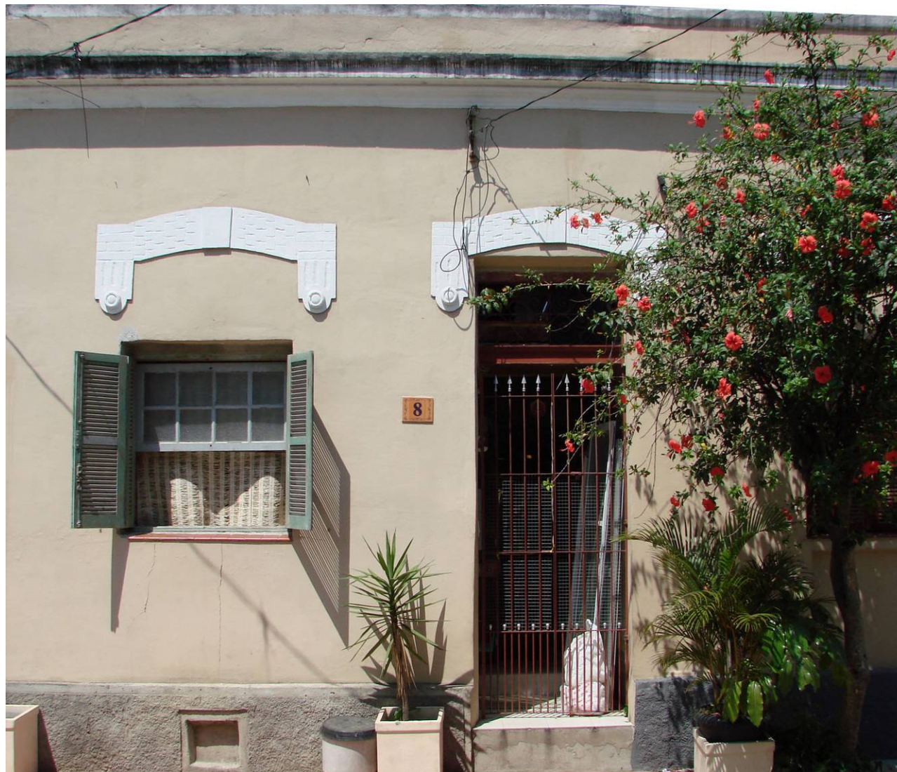
SITUAÇÃO ATUAL DA FACHADA - 2009
