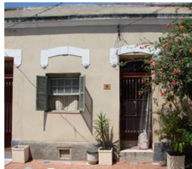
SITUAÇÃO ATUAL DA FACHADA - 2009 FOTO: CONDEPHAAT
