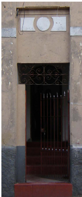
FOTO SITUAÇÃO ATUAL FONTE: DPH
