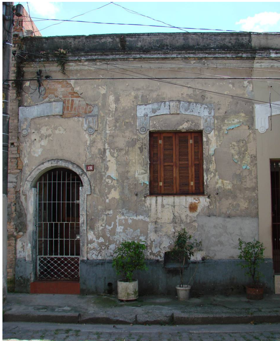
SITUAÇÃO ATUAL DA FACHADA - 2009
