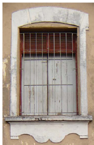
FOTO SITUAÇÃO ATUAL FONTE: DPH
