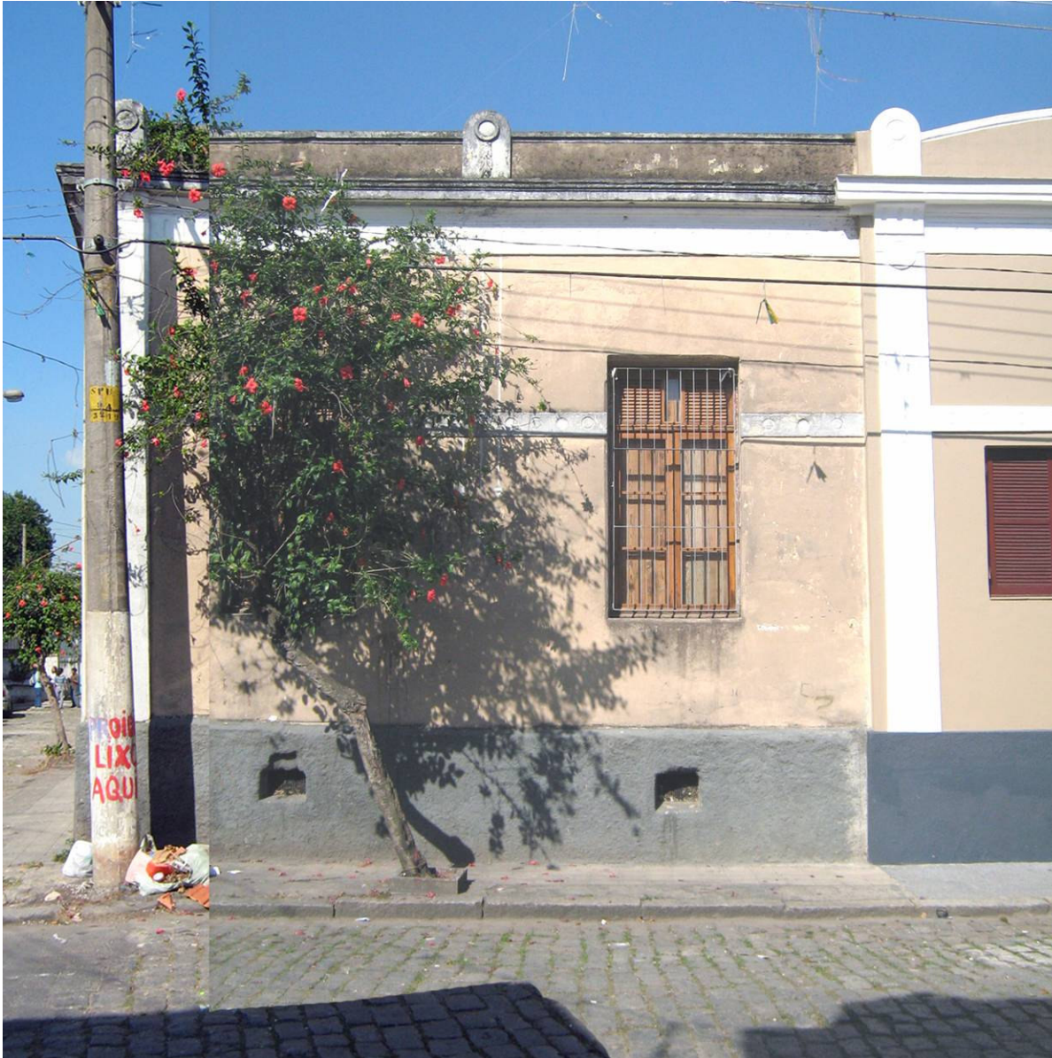
SITUAÇÃO ATUAL DA FACHADA - 2009
