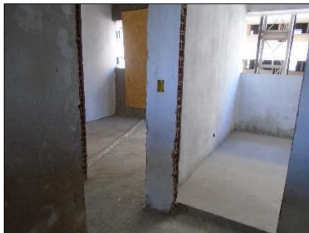
Bloco C – Execução de contrapiso
