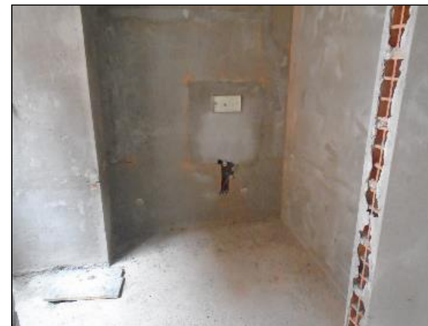
Bloco A - Colocação da caixa de descarga de embutir nas unidades adaptadas e para idosos
