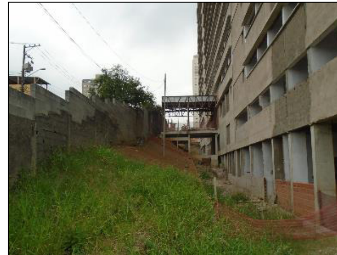
Trecho Norte área condominial junto ao acesso da Rua Estevão Baião
