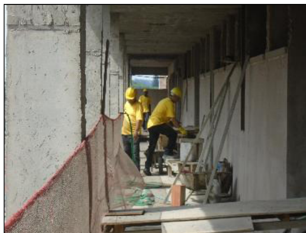
Bloco B - Revestimento das paredes do corredor de acesso às unidades habitacionais
