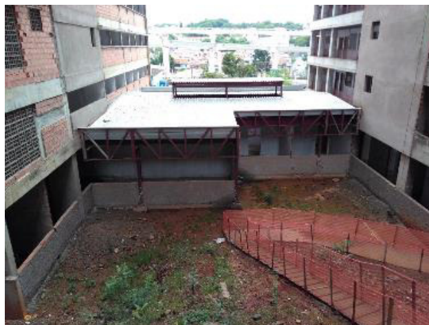
Vista do fundo entre os blocos B e C
