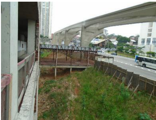
Trecho Sul área condominial junto ao acesso da Avenida Washington Luís
