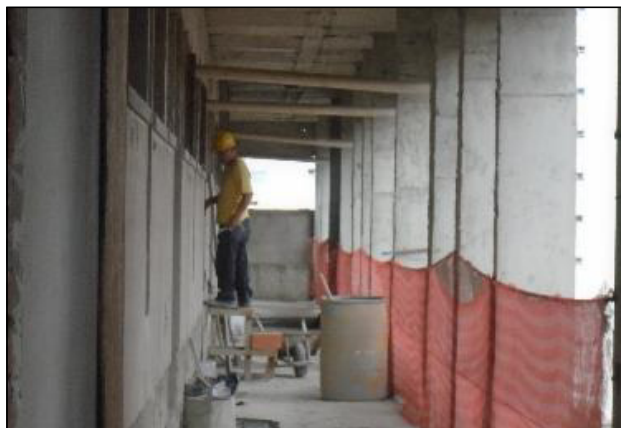
Bloco B - Execução do requadro do shaft
