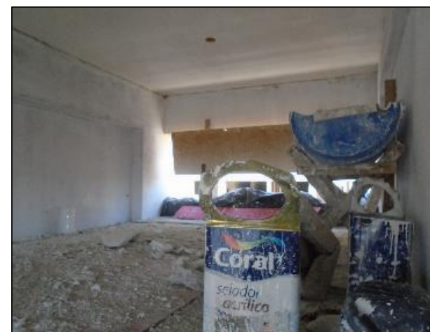
Bloco C – Execução de revestimento das lajes em gesso
