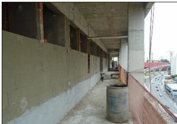
Bloco C – Execução do peitoril nas janelas internas ao corredor de acesso
