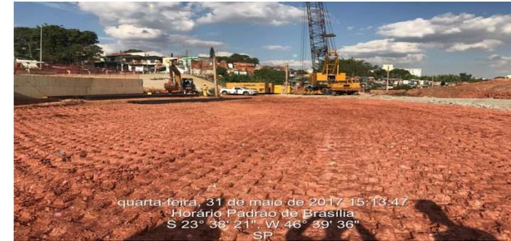
Aterro compactado do corta-rio; margem esquerda do canal
