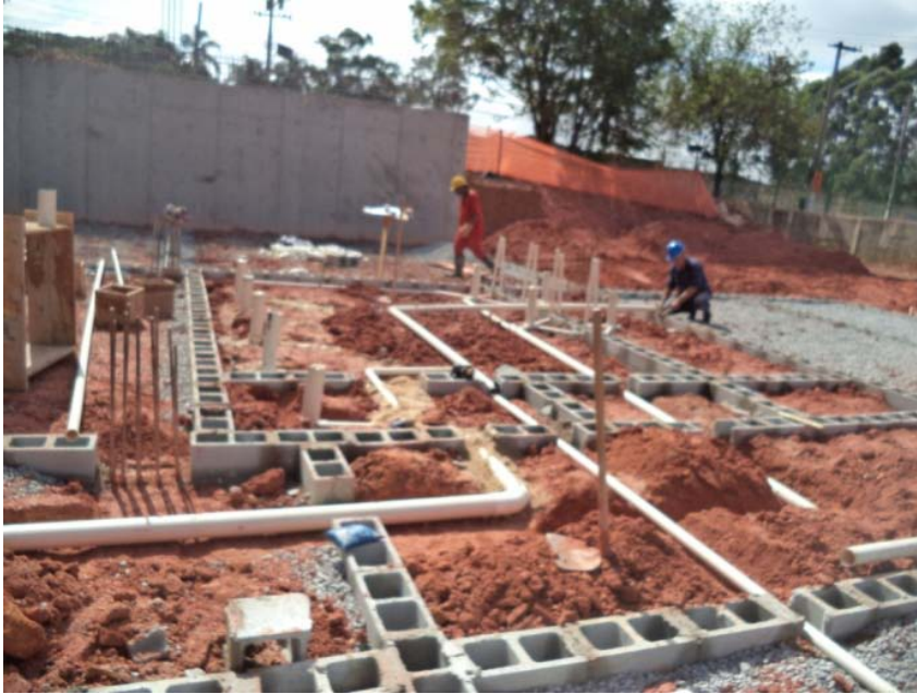
Execução de alvenaria de embasamento e passagem de infraestrutura do subsolo Galpão Multiuso
