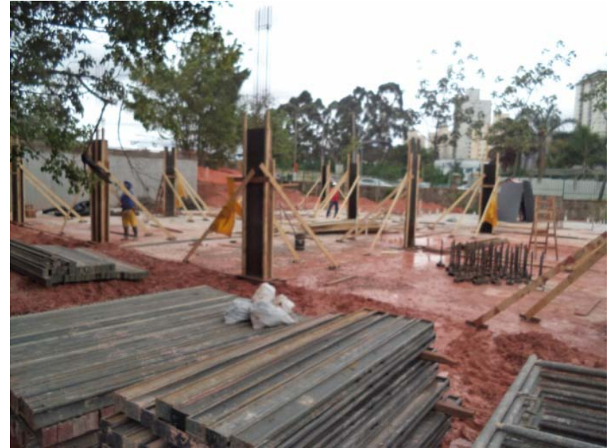
Execução das armações e forma dos pilares no subsolo do Galpão Multiuso
