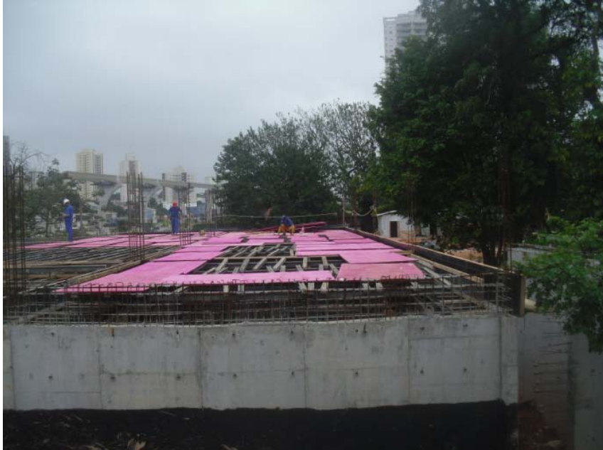
Assoalho da laje térreo do Galpão Multiuso
