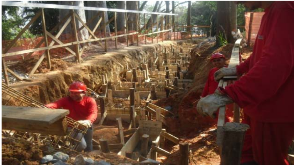
Execução forma e armação dos blocos da fundação do muro de arrimo próximo ao projeto do Núcleo de Vivência.
