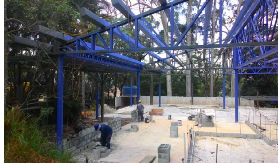
Pintura da Estrutura metálica
