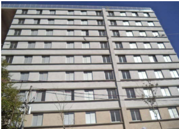
Vista frontal da fachada do prédio
