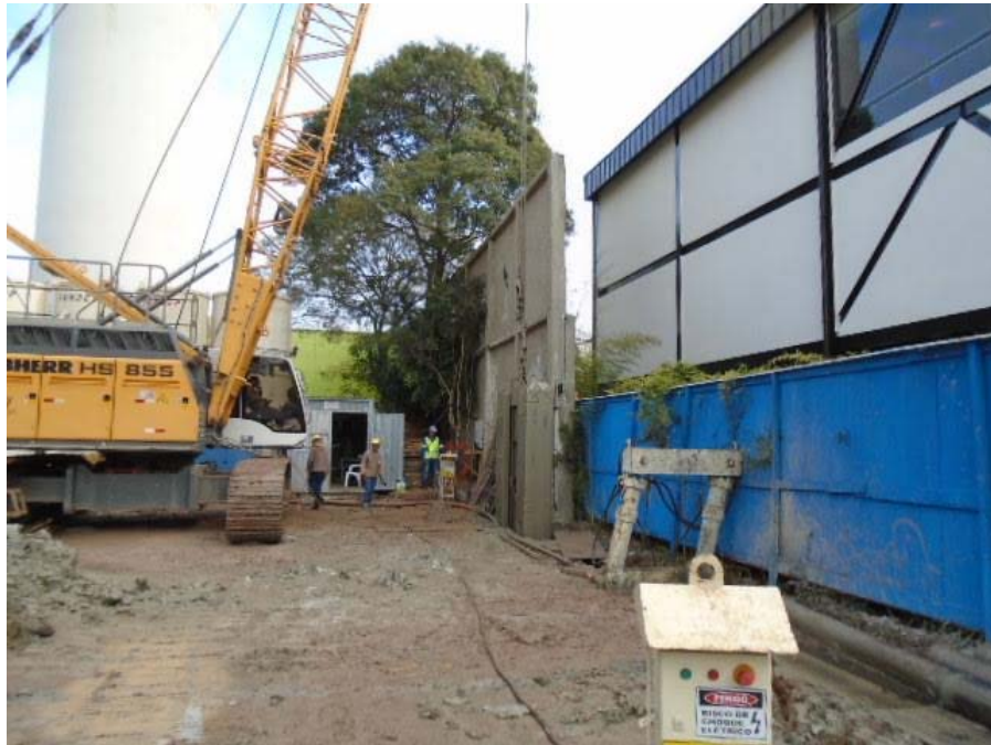
Parede Diafragma – Poço de Ventilação
