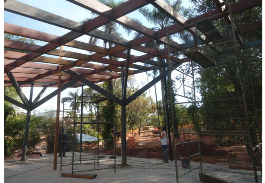
Estrutura metálica do Galpão multiuso
