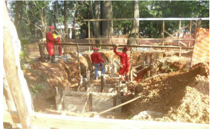
Execução forma e armação dos blocos da fundação do muro de arrimo próximo ao projeto do Núcleo de Vivência
