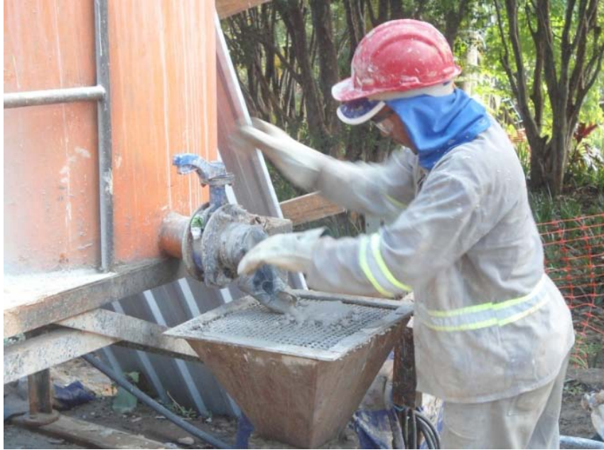
Injeção de argamasa das estacas raiz Núcleo de Vivência
