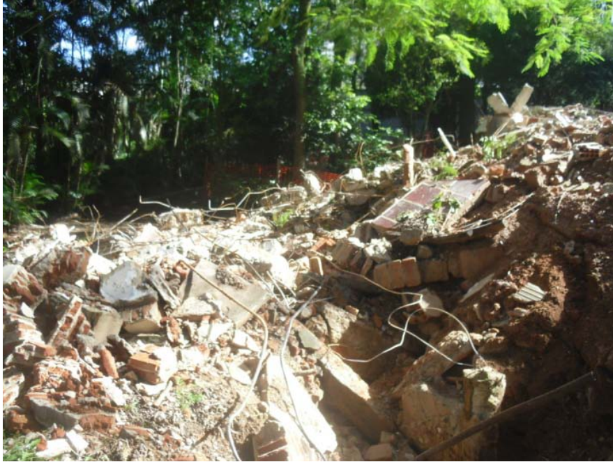
Demolição prédio de Vivência
