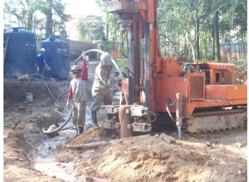
Injeção de argamasa das estacas raiz Núcleo de Vivência
