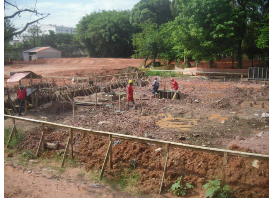
Execução da forma dos blocos de fundação do subsolo Galpão Multiuso
