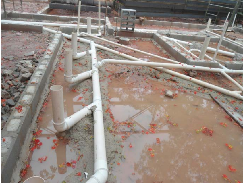
Execução da rede de esgoto pavimento térreo do Galpão Multiuso
