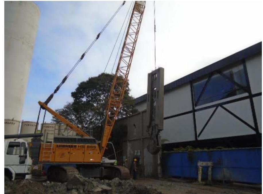
Parede Diafragma – Poço de Ventilação
