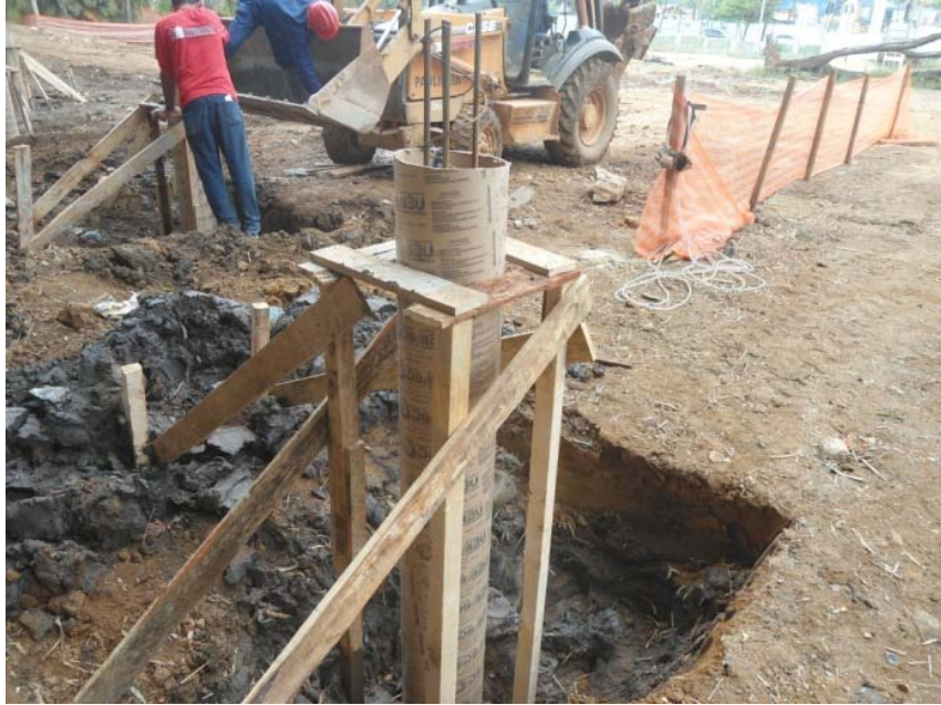
Execução forma e armação para complementos das Estacas do Galpão Multi-uso.
