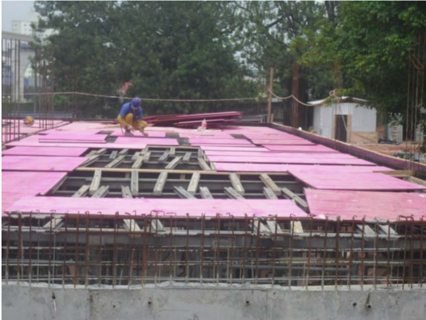
Assoalhamento da laje do Galpão Multiuso.
