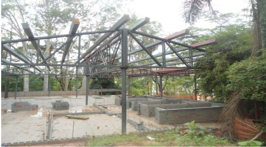
Elevação da alvenaria de Vedação
