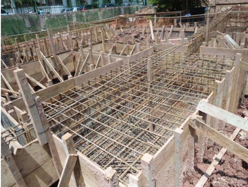
Execução das armações dos blocos de fundação do subsolo Galpão Multiuso
