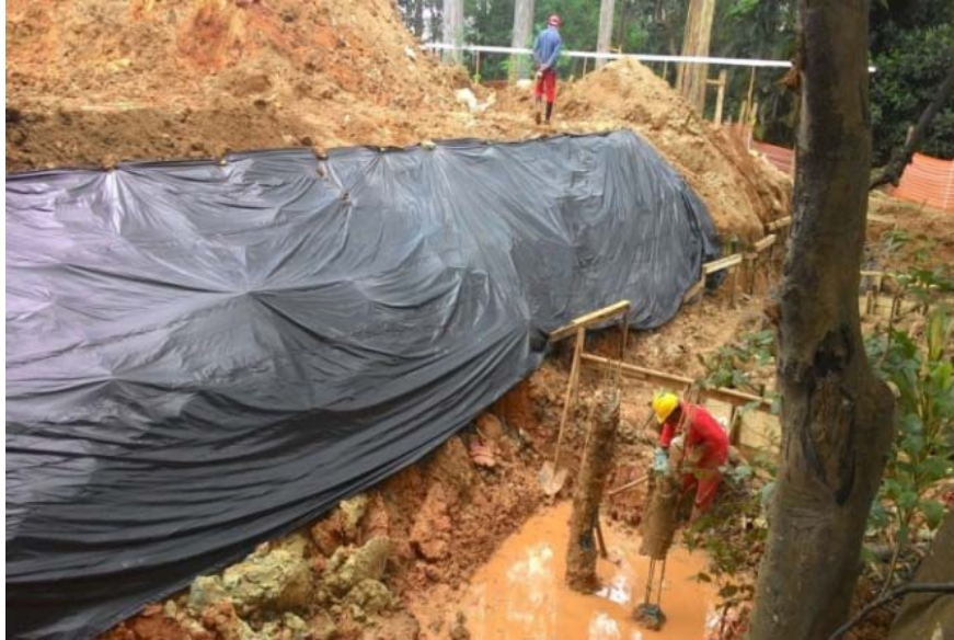
Proteção do talude
