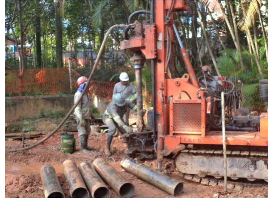
Perfuração das estacas raiz Núcleo de Vivência
