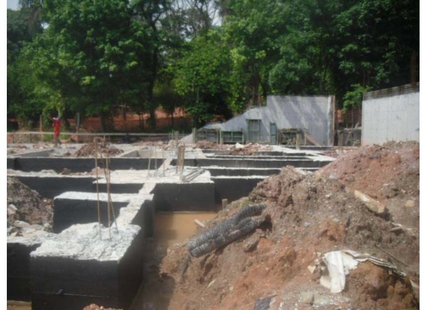
Blocos de fundação do Galpão Multiuso
