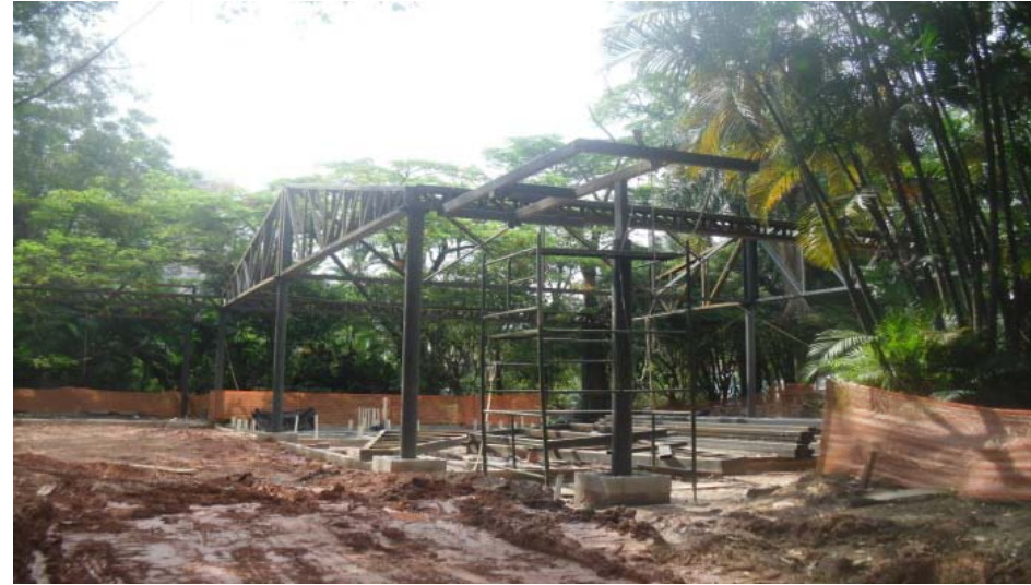
Montagem da estrutura metálica pavimento térreo do Núcleo de Vivência
