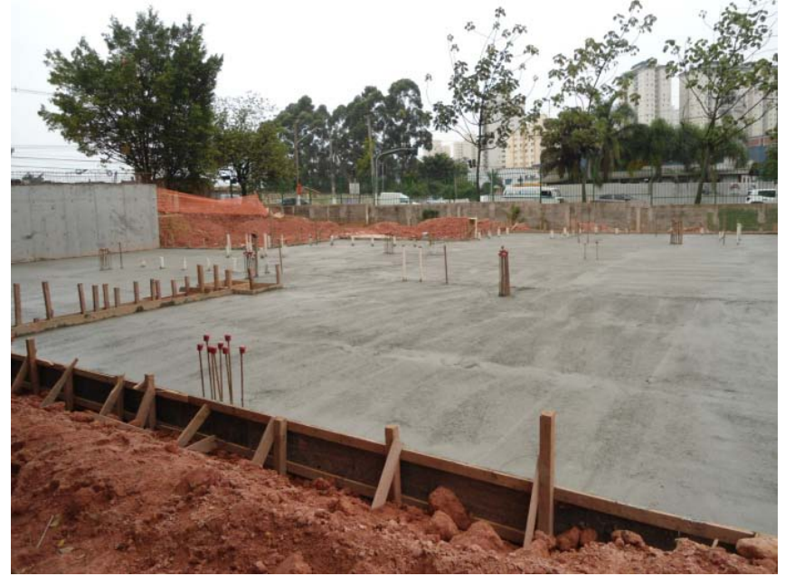
Piso do subsolo do Galpão Multiuso
