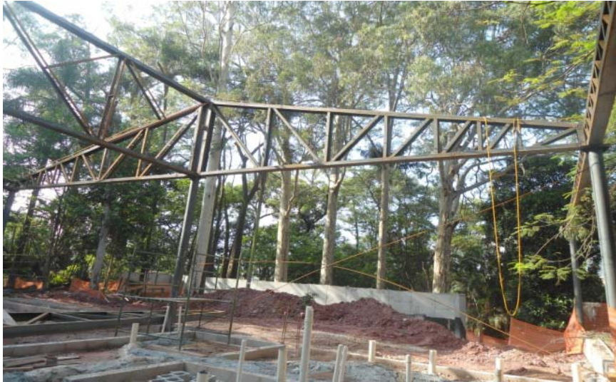
Montagem da estrutura metálica pavimento térreo do Núcleo de Vivência
