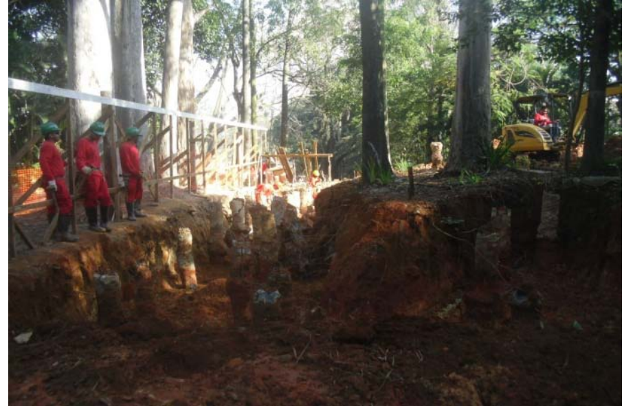
Escavação para execução dos blocos da fundação do Núcleo de Vivência do Pavimento Térreo
