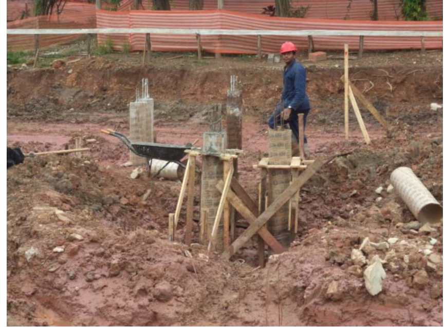
Execução forma e armação para complementos das Estacas do Galpão Multi-uso.
