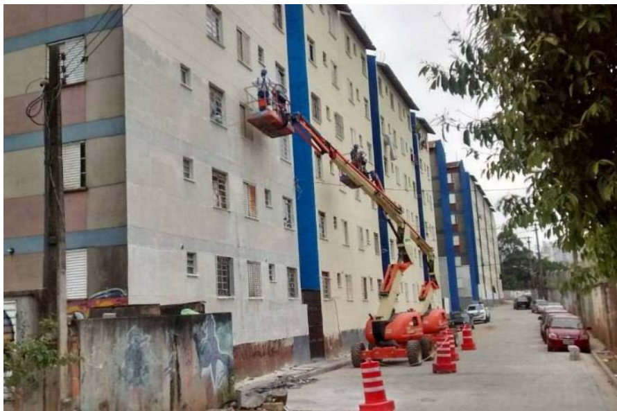
3R: Execução de pintura externa
