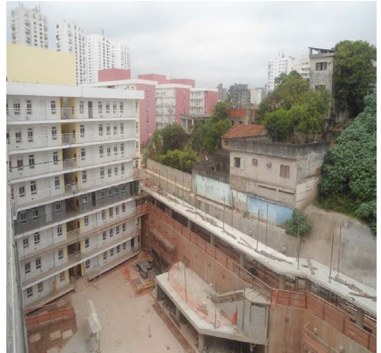
OBRAS DO CONDOMÍNIO A OESTE 1
