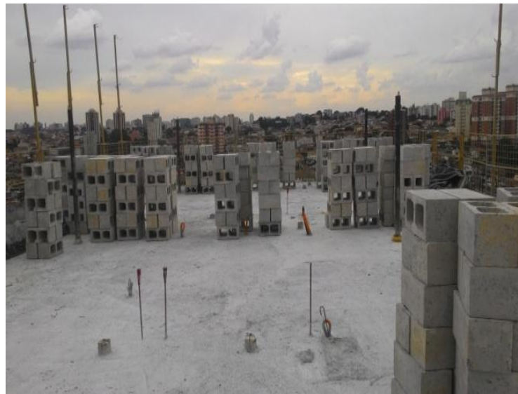
Início da alvenaria do 9º pavimento
