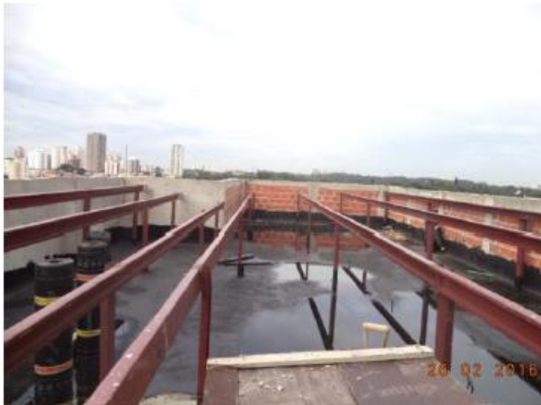
Bloco A Impermeabilização da laje
