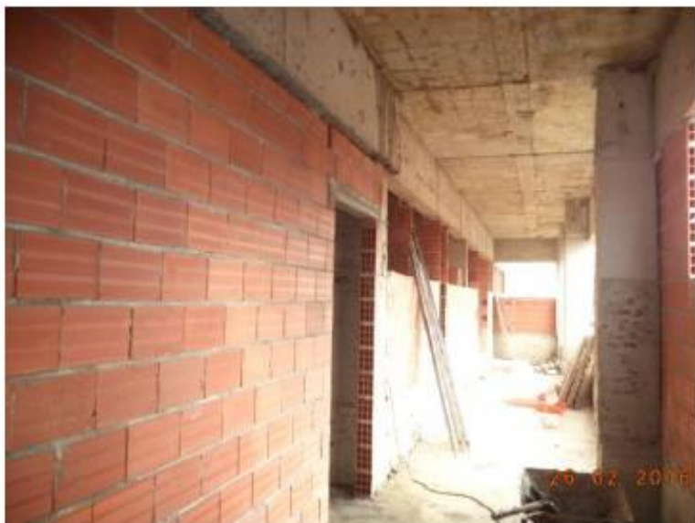
Bloco B Alvenaria em execução
