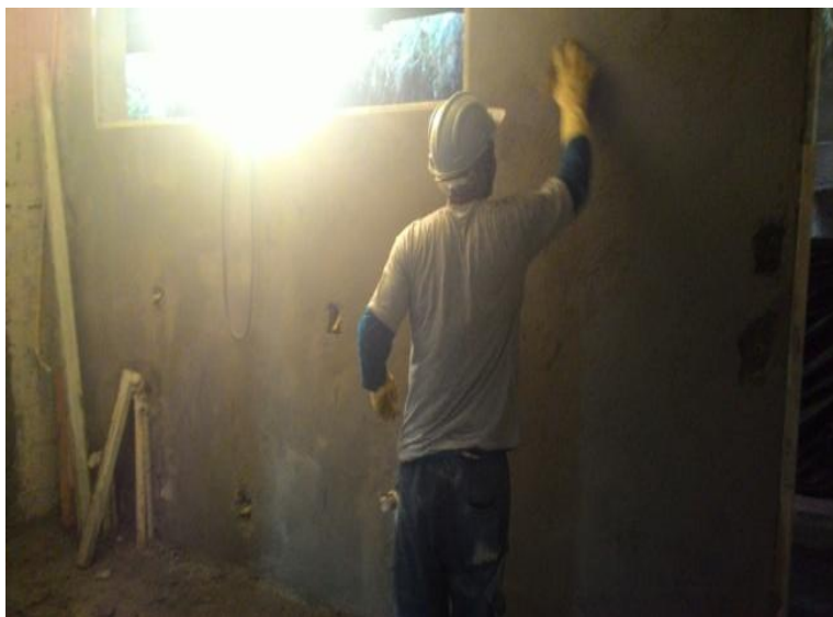
Execução de Embolso das áreas frias
