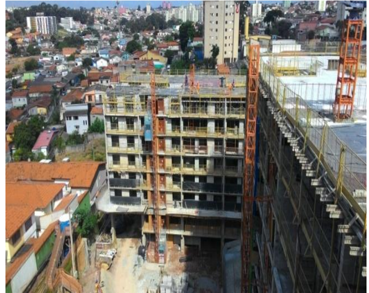
Vista da Fachada do Prédio
