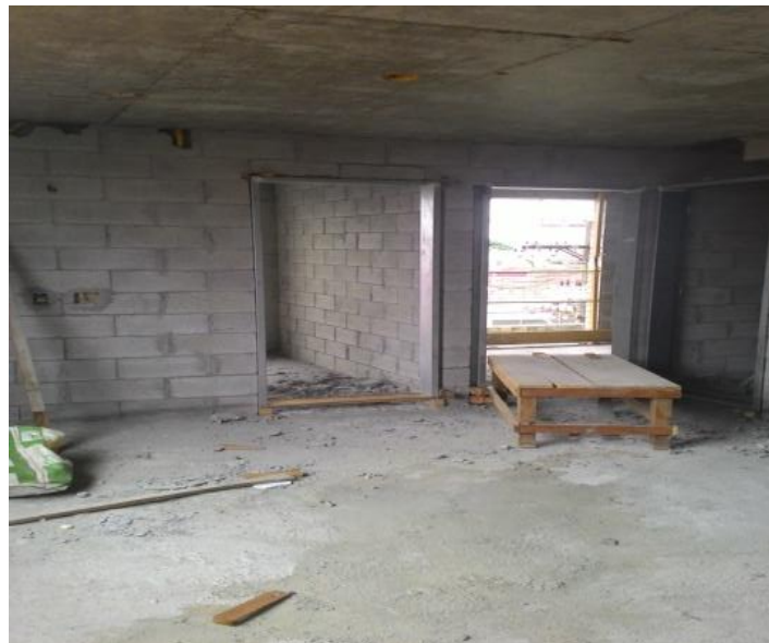
Instalação de Batentes
