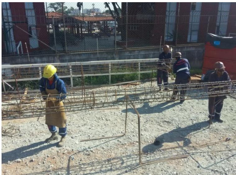
Execução da armação das estacas
