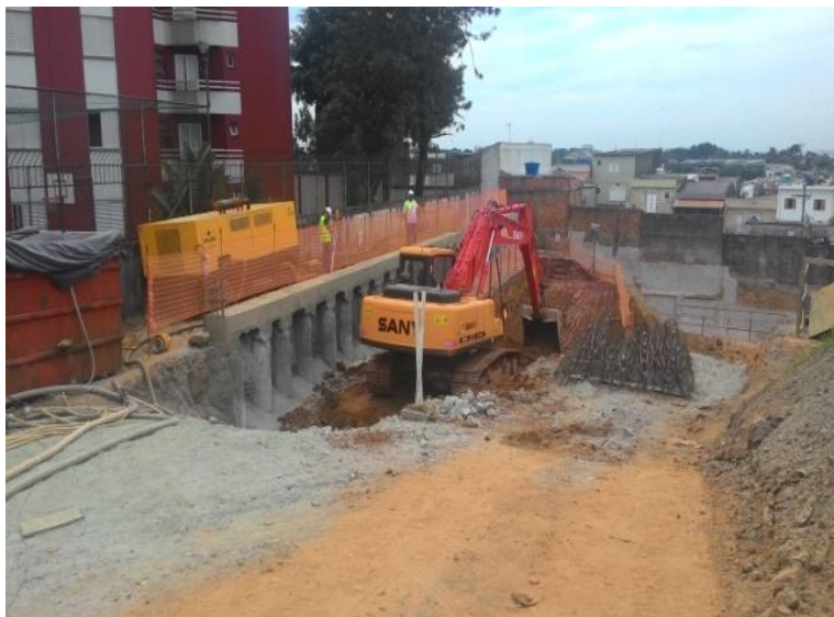
Rebaixamento do talude para execução da linha de tirante
