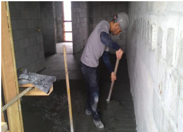
Execução de contra piso
