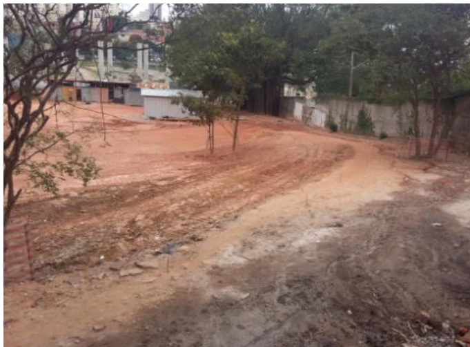
Execução da área de passeio
