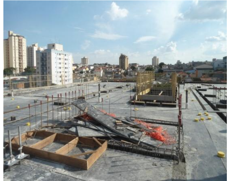
Montagem de forma da laje do 7º pavimento
