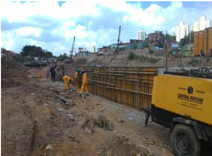
Execução das paredes de New Jersey ao longo da Canalização do Córrego Água Espraiada
