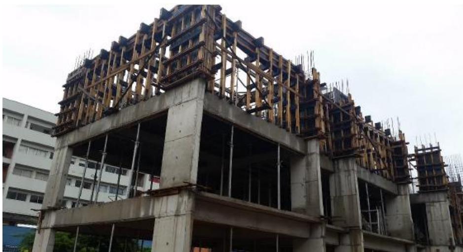
Execução do 3º pavimento
