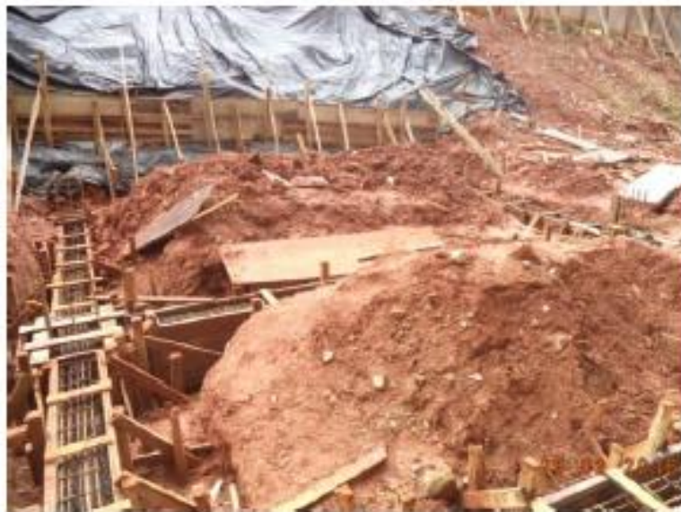
PASSARELA: Bloco C para Av. Washington Luis
