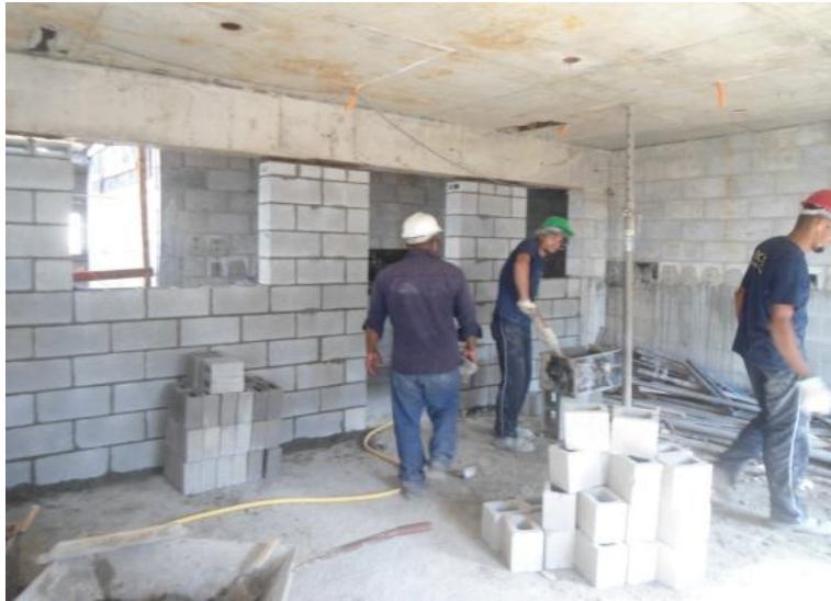
Execução de Alvenaria de Vedação
