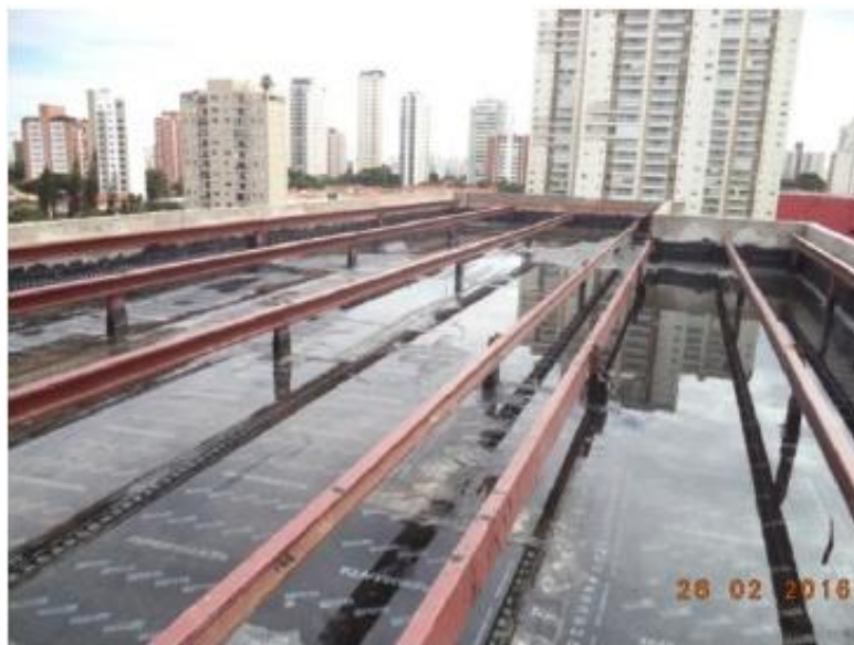
Bloco C Teste de estanqueidade manta asfáltica + alvenaria caixa d'água
