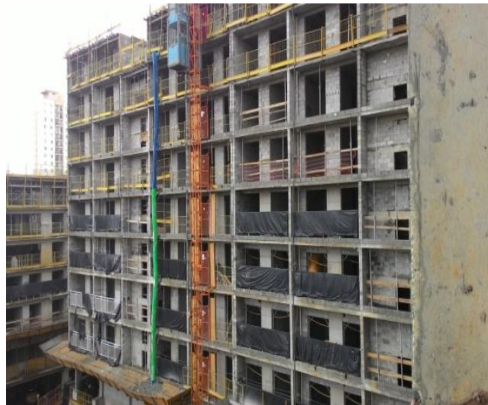
Vista da Fachada do Prédio
