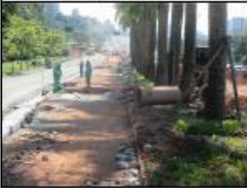
EXECUÇÃO DA CAMADA DE RACHÃO INTERTRAVADO
