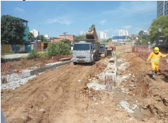
Córrego Pinheirinho - Execução da Viga de Coroamento
