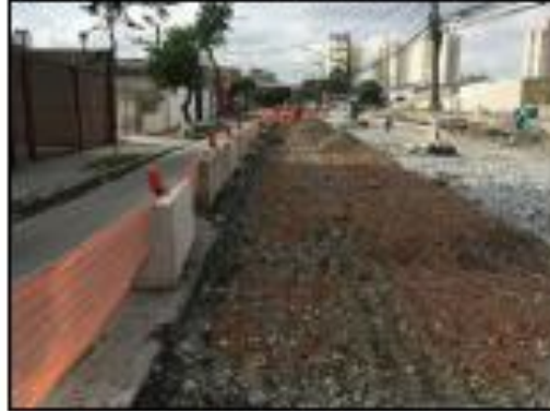
EXECUÇÃO DA CAMADA DE RACHÃO INTERTRAYADO
