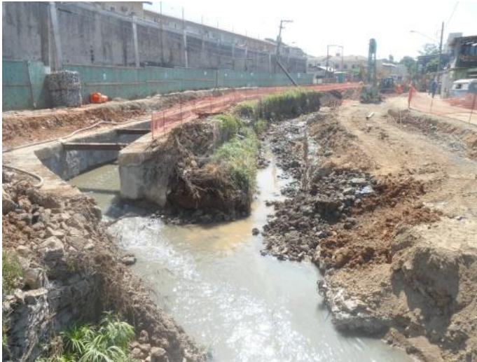
Córrego Pinheirinho - Execução do aterramento do córrego existente
