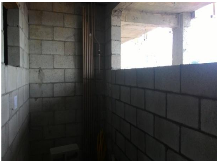
Execução das instalações Hidráulica
