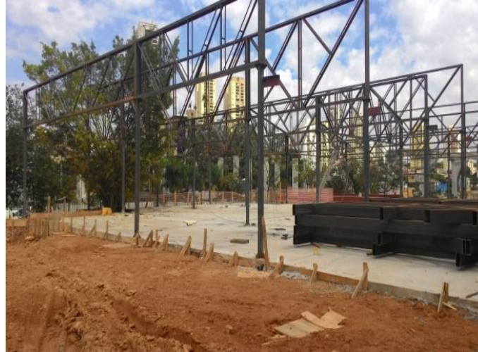
Execução de pintura da estrutura do prédio vivência
