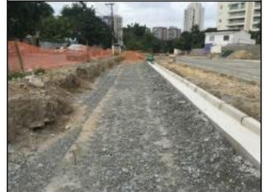
EXECUÇÃO DA CAMADA DE RACHÃO INTERTRAVADO
