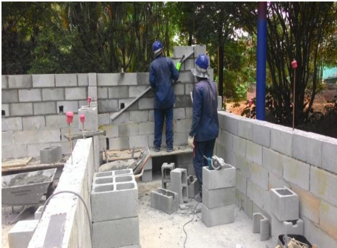
Execução de alvenaria do prédio vivência
