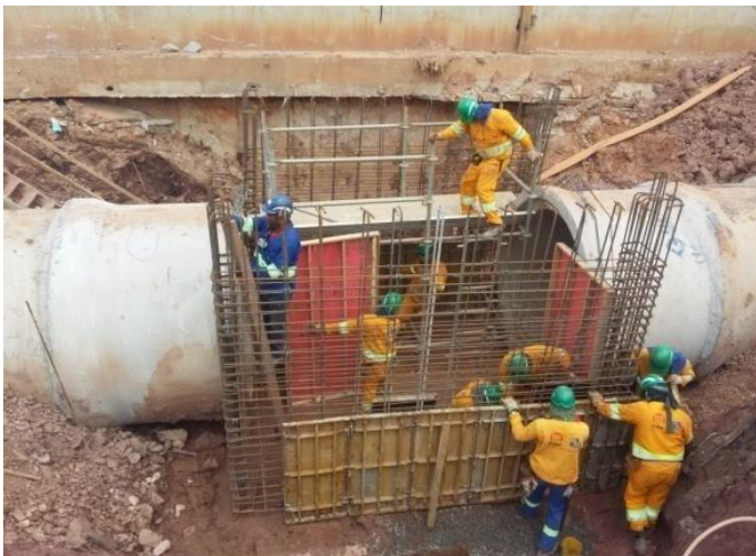
Execução de armação e Forma do PV
