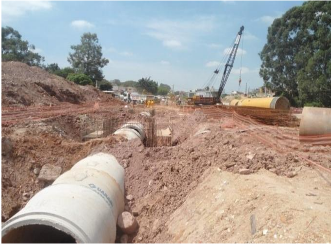
Execução do sistema de Microdrenagem
