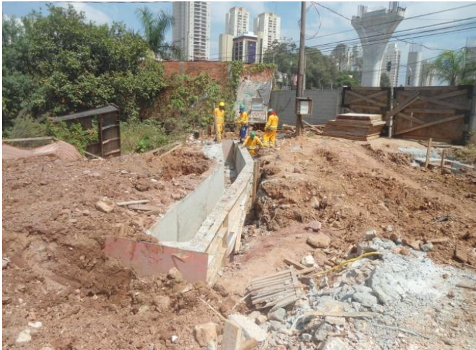
Confecção de mureta-guia para execução de parede diafragma Estaca 02 à Estaca - 03
