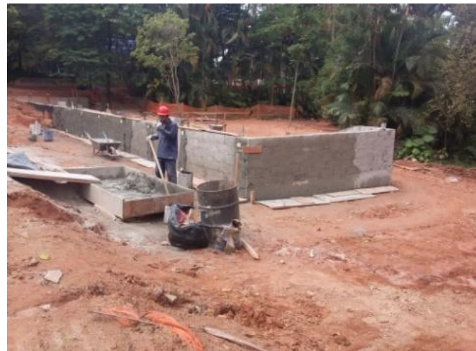
Execução da alvenaria da quadra de bocha
