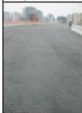
LIMPEZA DO COCRETO PARA A CAMADA DE BINDER
