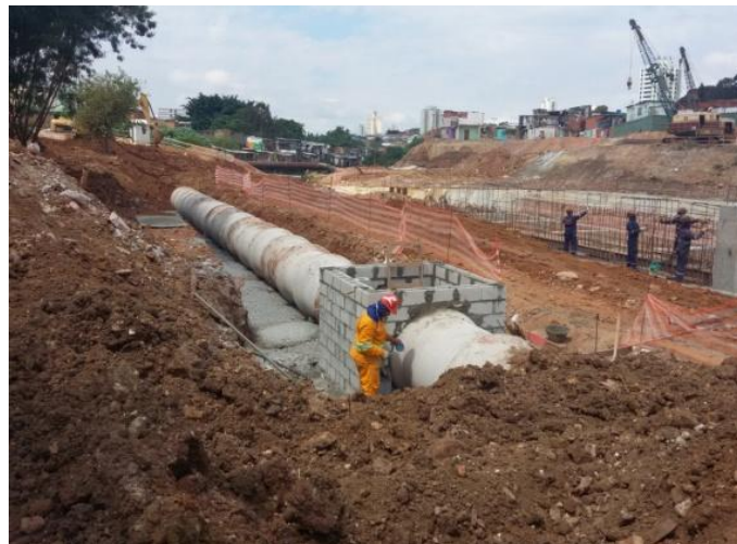
Execução dos PV em alvenaria do trecho
