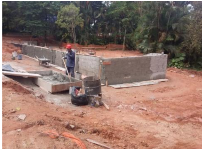
Execução da estrutura do prédio multiuso
