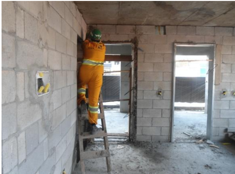
Instalação de Batentes das portas
