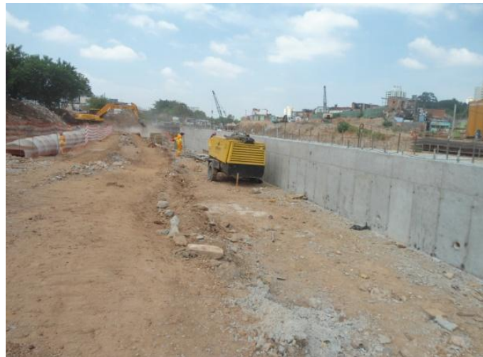
Paredes do New Jersey ao longo da Canalização do Córrego Água Espraiada
