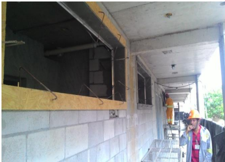
Instalações de contra marco
