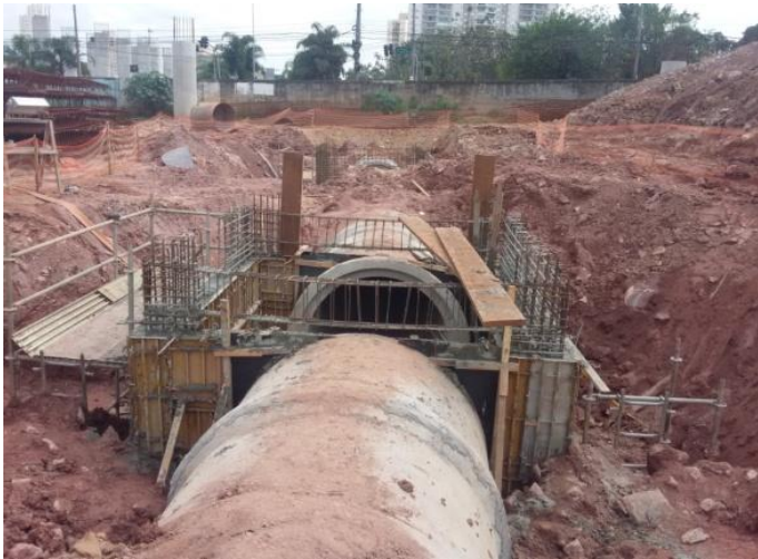
Execução no trecho viário
