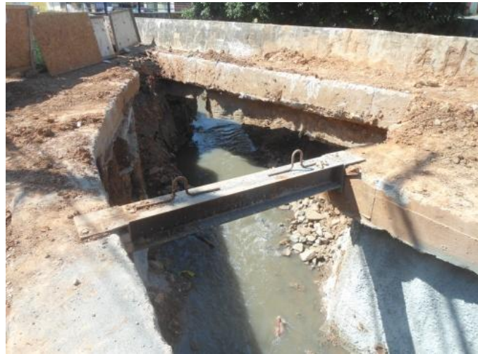
Córrego Pinheirinho - Execução Do corta rio
