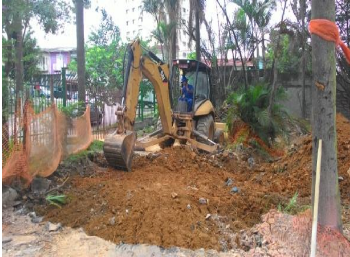
Execução da base da caixa d'Água do parque
