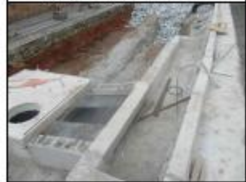
EXECUÇÃO DA BOCA DE LOBO COM PV
