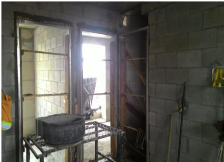
Instalação de batentes
