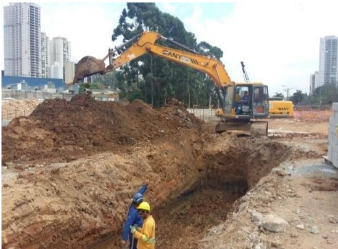
Execução de abertura do trecho viário
