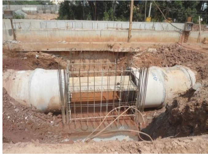
Execução da armação do PV
