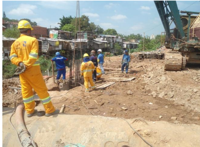
Execução de Parede diafragma do trecho da Estaca 13 a Estaca 16
