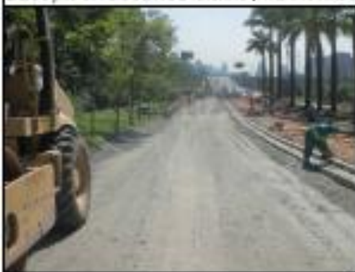
EXECUÇÃO DA CAMADA DE RACHÃO INTERTRAVADO
