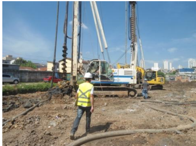
Córrego Pinheirinho - Execução do estaqueamento do trecho da Estaca 10 à Estaca 16
