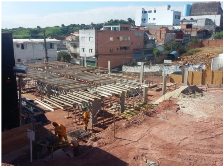
Execução de montagem do canteiro
