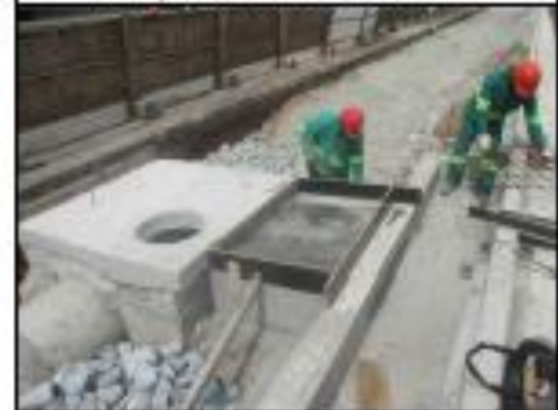
EXECUÇÃO DA BOCA DE LOBO COM PV
