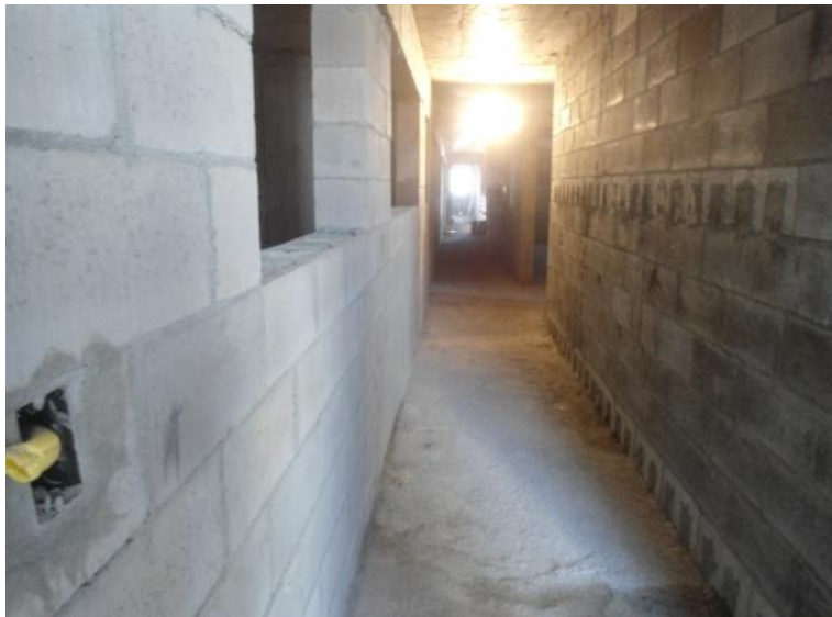
Execução de instalações Elétricas
