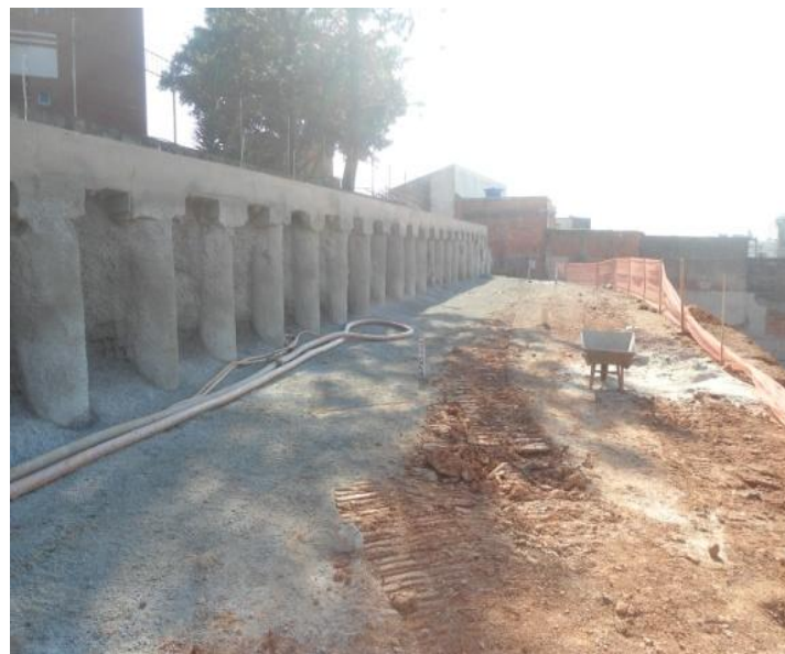
Vista da estaca de contenção
