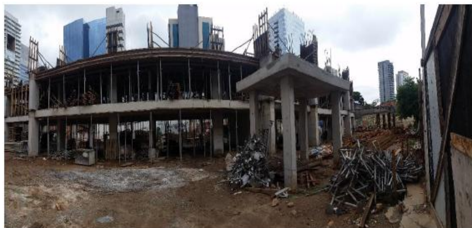
Torre - Frente / Portaria
