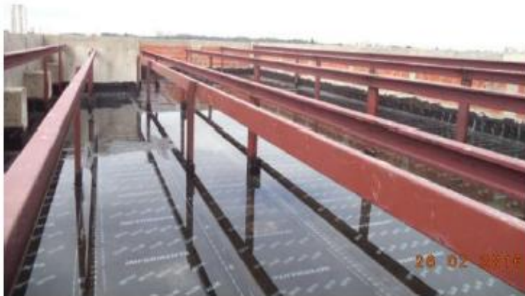
Bloco C Teste de estanqueidade manta asfáltica + alvenaria caixa d'água
