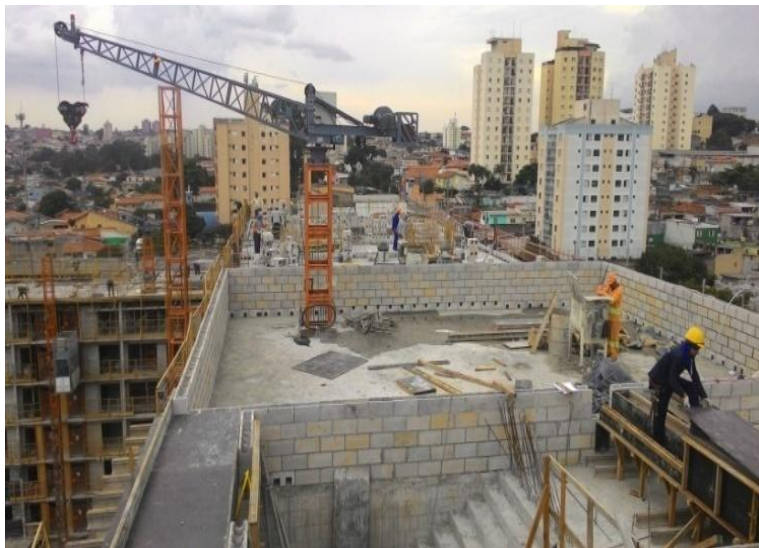
Execução de Alvenaria da Platibanda e Caixa D'Água
