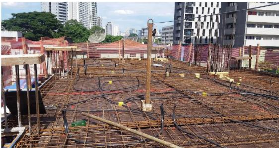
Laje do 2º pav.
