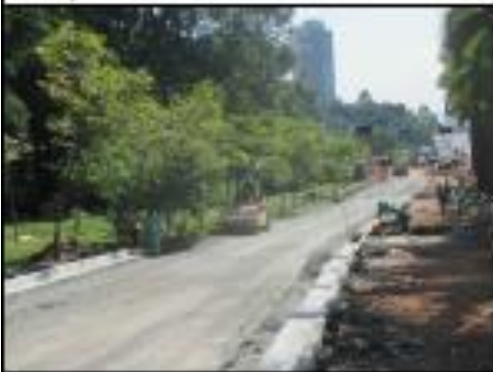
EXECUÇÃO DA CAMADA DE RACHÃO INTERTRAVADO
