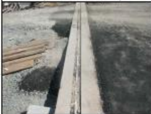
EXECUÇÃO DA JUNTA DE DILATAÇÃO
