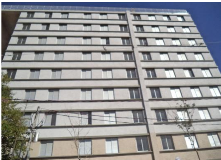
Vista frontal da fachada do prédio
