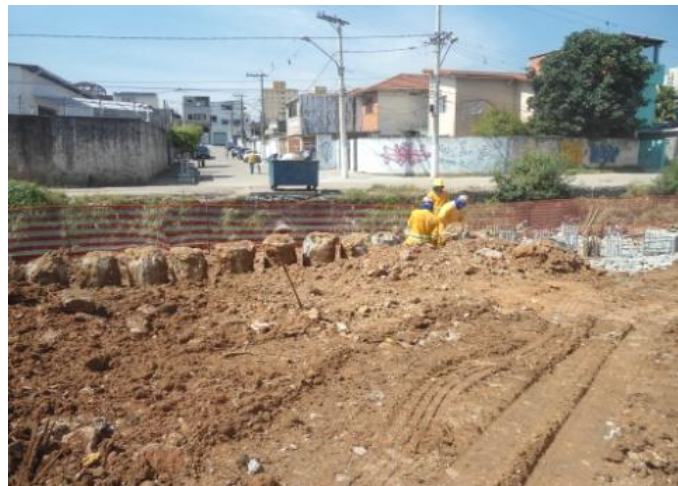
Córrego Pinheirinho - Execução de arrasamento de estaca
