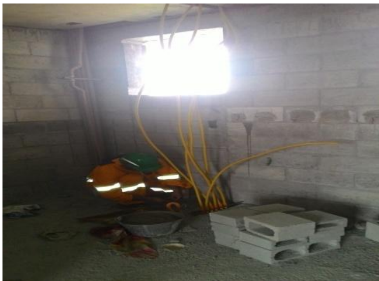
Execução de passagem da tubulação de gás
