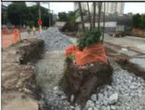
EXECUÇÃO DA CAMADA DE RACHÃO INTERTRAVADO
