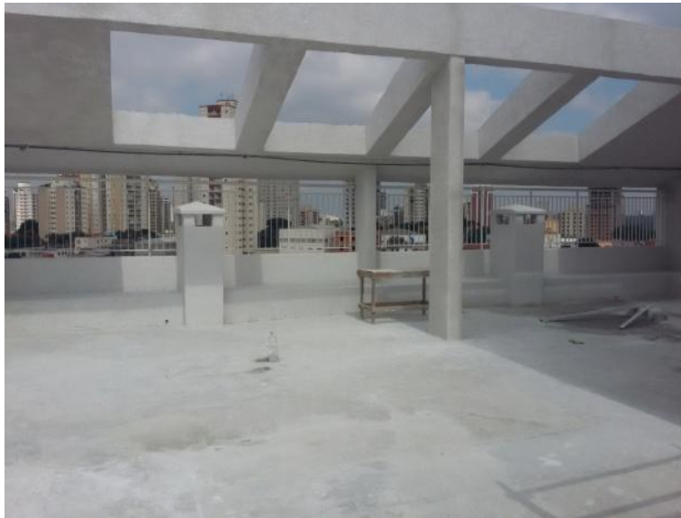
Vista da cobertura
