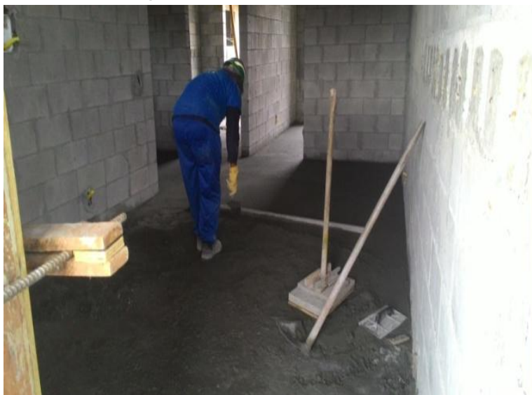
Execução de contra piso
