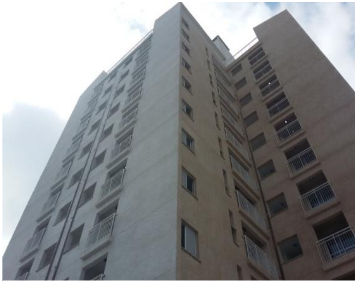
Vista da Fachada do Prédio
