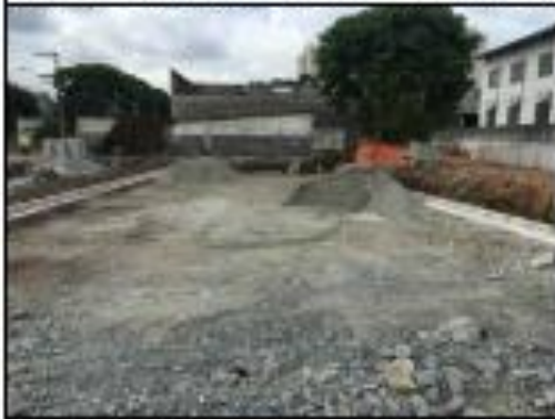
EXECUÇÃO DA CAMADA DE RACHÃO INTERTRAVADO
