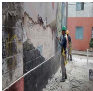
Remoção de revestimento
