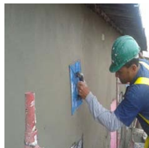
Execução de revestimento de fachada
