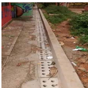
Execução de canaleta
