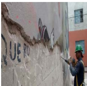
Remoção de revestimento
