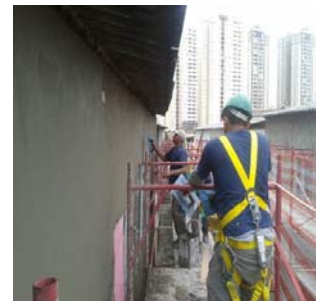
Execução de revestimento de fachada
