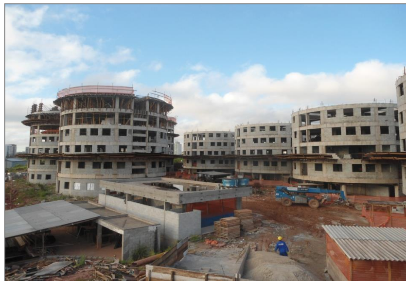
Sabesp 2: Serviços de estrutura e vedação no Condomínio 2.
