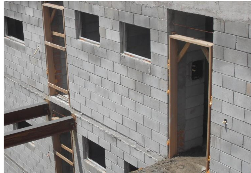
Instalação de batentes – Bloco B.
