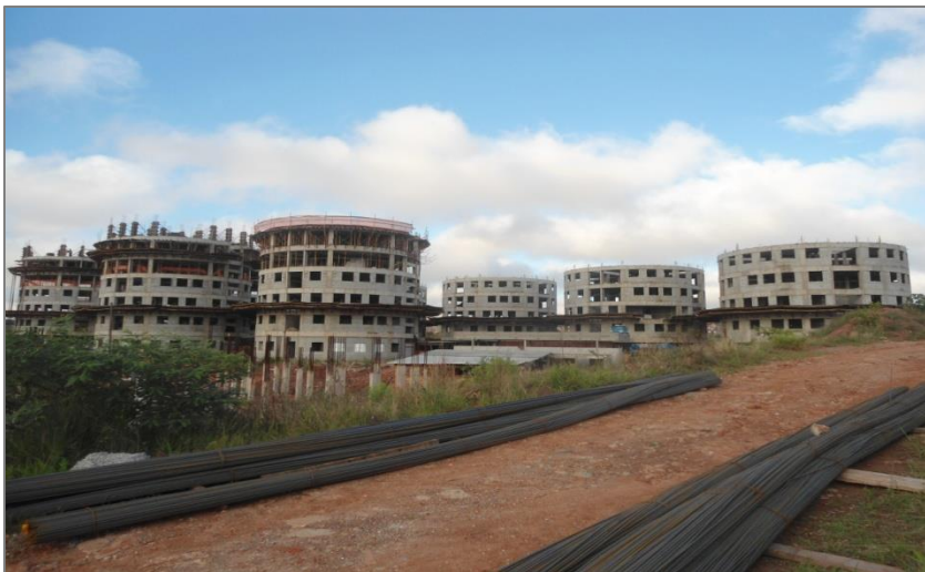
Gerenciamento de Obras de Urbanização de Favelas: Sabesp 2.
