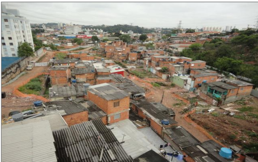
Gerenciamento de Obras de Urbanização de Favelas: Viela da Paz.
