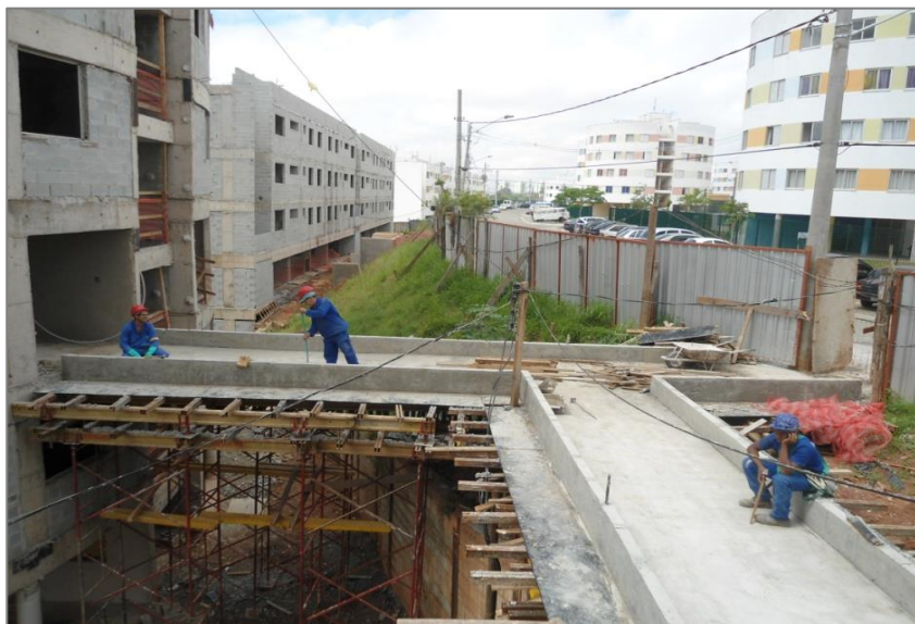
Gerenciamento de Obras de Urbanização de Favelas: Sabesp 1.
