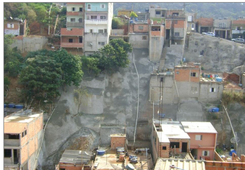
Execução de solo grampeado na Rua Iturama com Faisão.
