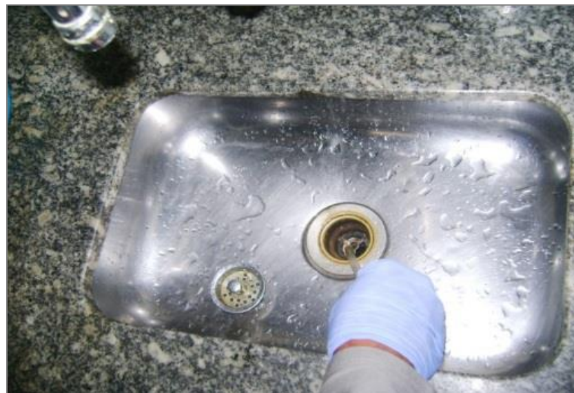
Monitoramento da presença de gás nas unidades habitacionais
