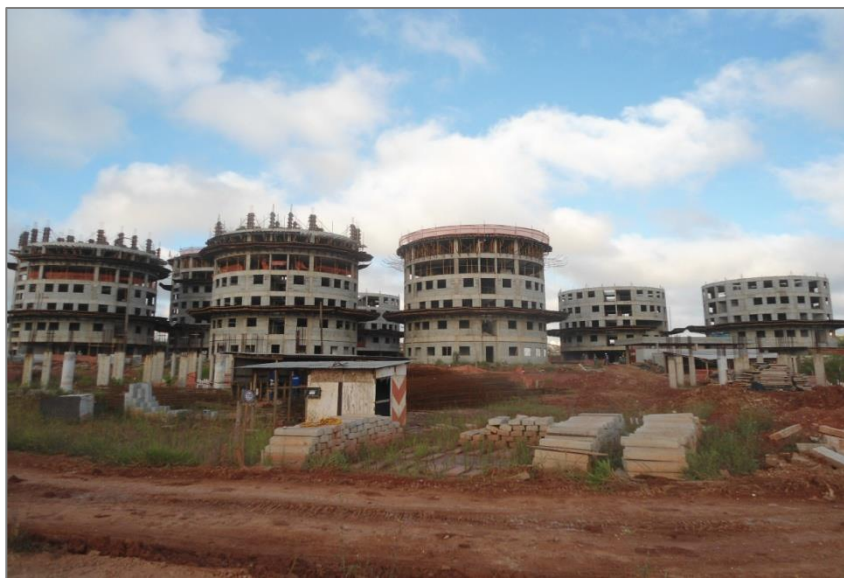
Sabesp 2: Serviços de estrutura e vedação no Condomínio 2.
