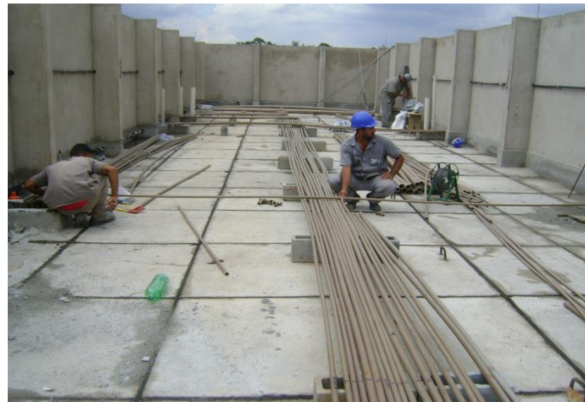
Bloco E:Execução do barrilete
