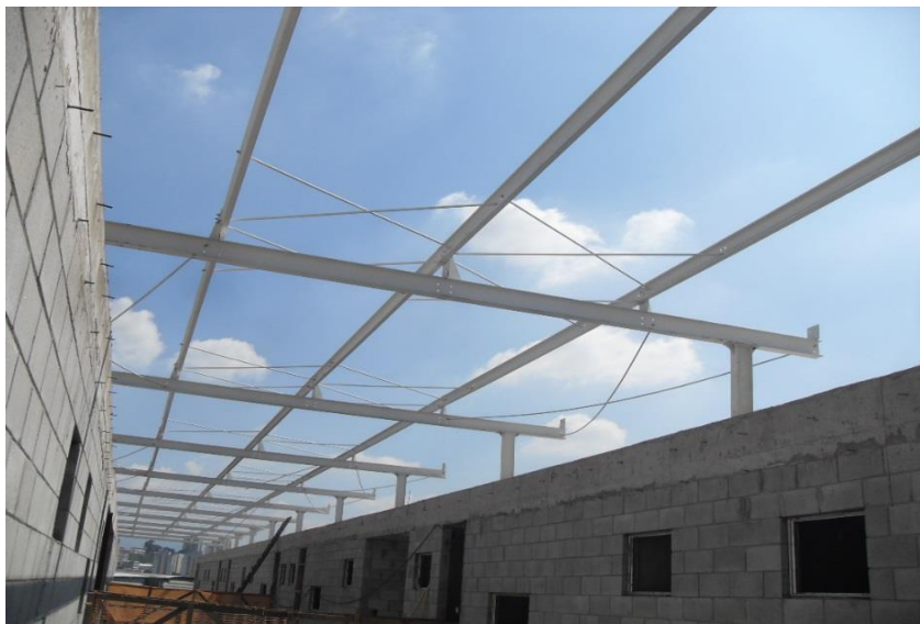
Montagem de estrutura metálica da cobertura do vão central – Bloco B.
