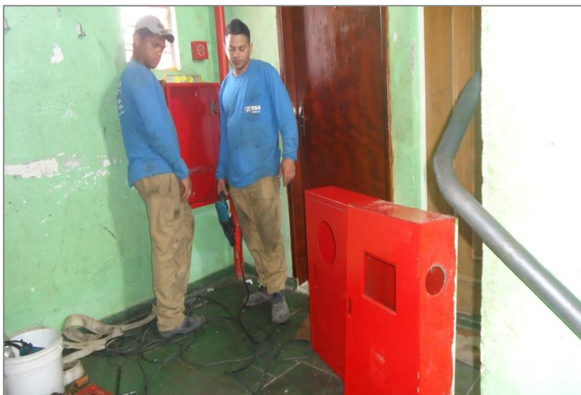
Campo Grande: instalação de extintores e demais serviços de combate a incêndio
