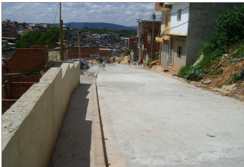
Execução de pavimentação da Rua Sorocaba.
