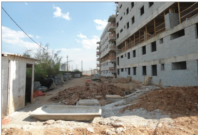
Sabesp 1: Serviços em andamento no Condomínio 3.
