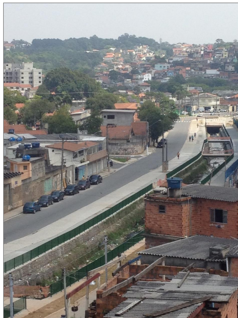
Gerenciamento de Obras de Urbanização de Favelas: Sapé.
