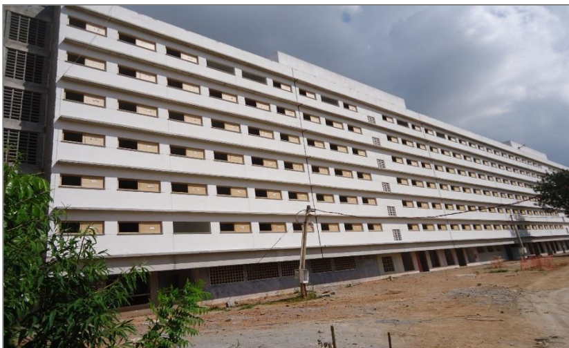
Gerenciamento de Obras de Urbanização de Favelas: Ponte dos Remédios – Torre F2
