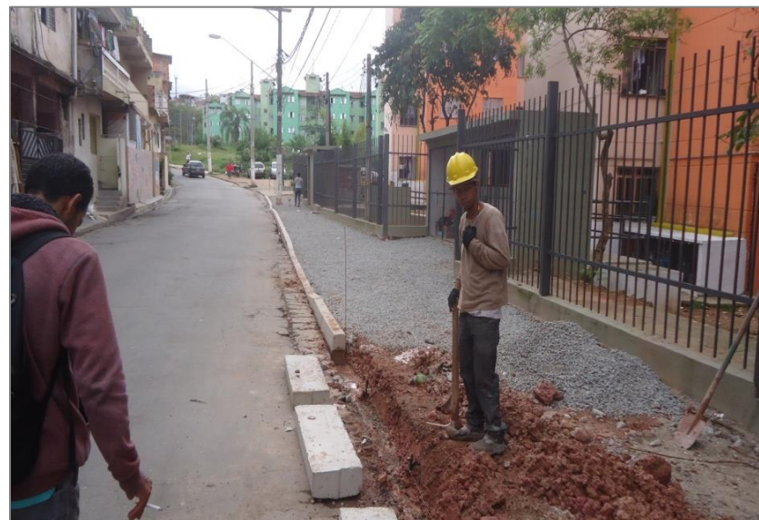
Parque Otero: Execução de guias e calçadas
