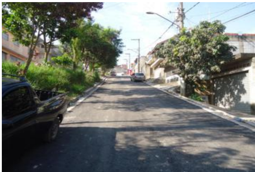
Execução da pavimentação – Av. Jasmim.
