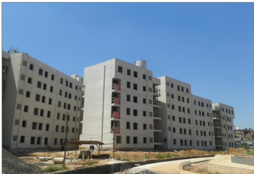
Condomínio F: Execução de serviços de acabamentos.
