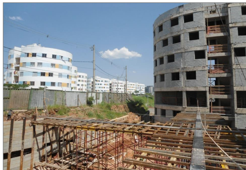
Sabesp 1: Serviços em andamento no Condomínio 4.
