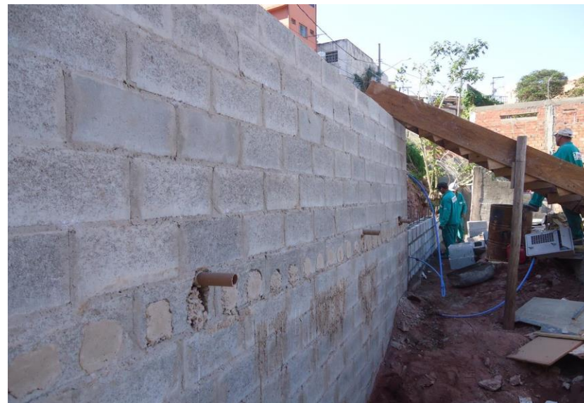
Execução de muro de arrimo – Rua das Violetas.
