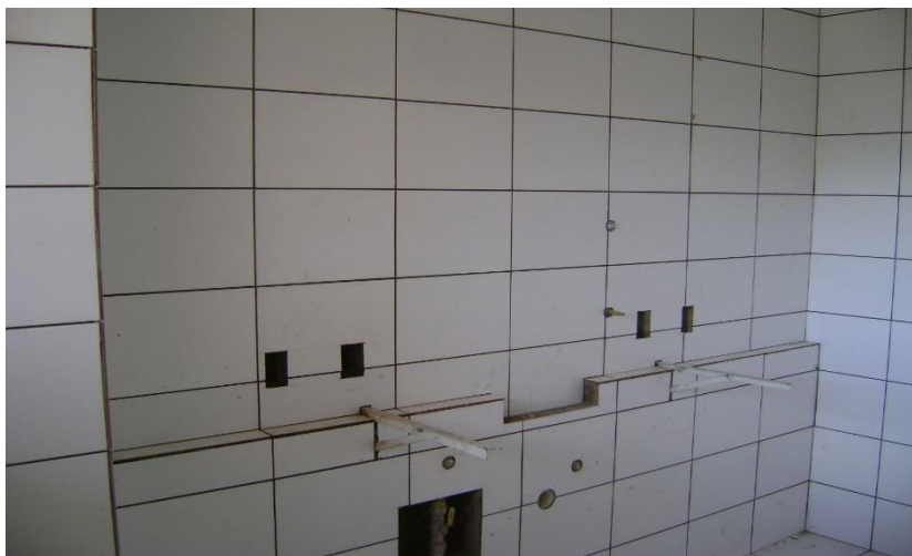
Bloco F: Revestimento Interno – Diogo Pires
