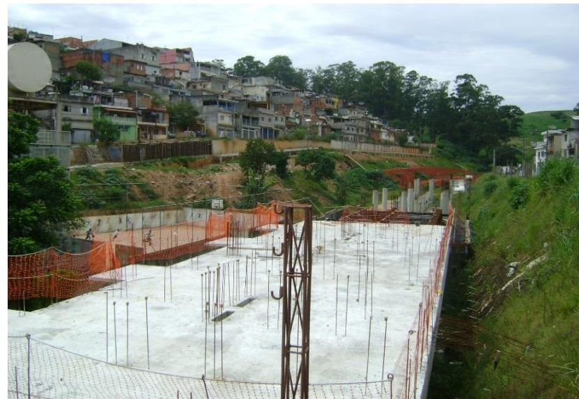
Concretagem da laje do pavimento térreo – Bloco B.
