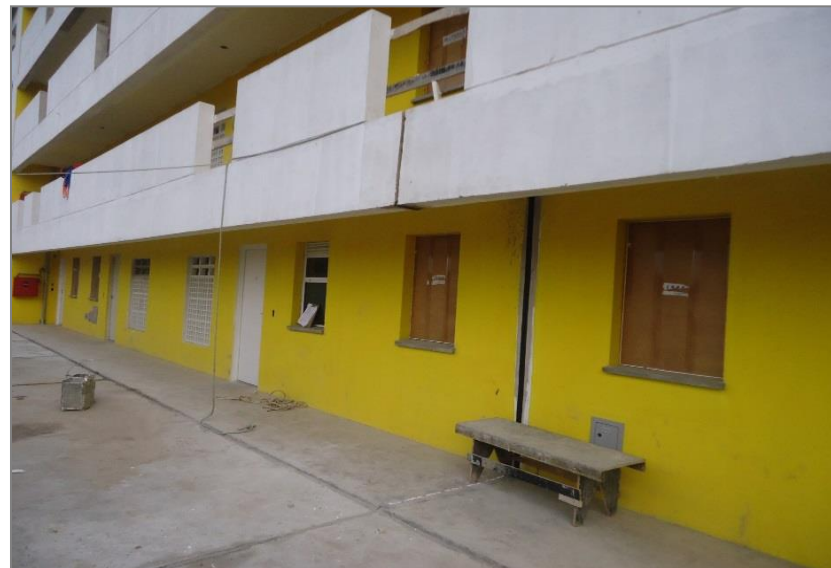
Torre F2 - Pintura do térreo
