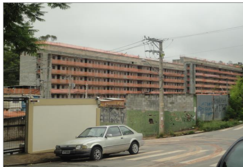
Vielas da Paz: Serviços de acabamentos em execução nos Condomínios B e C.
