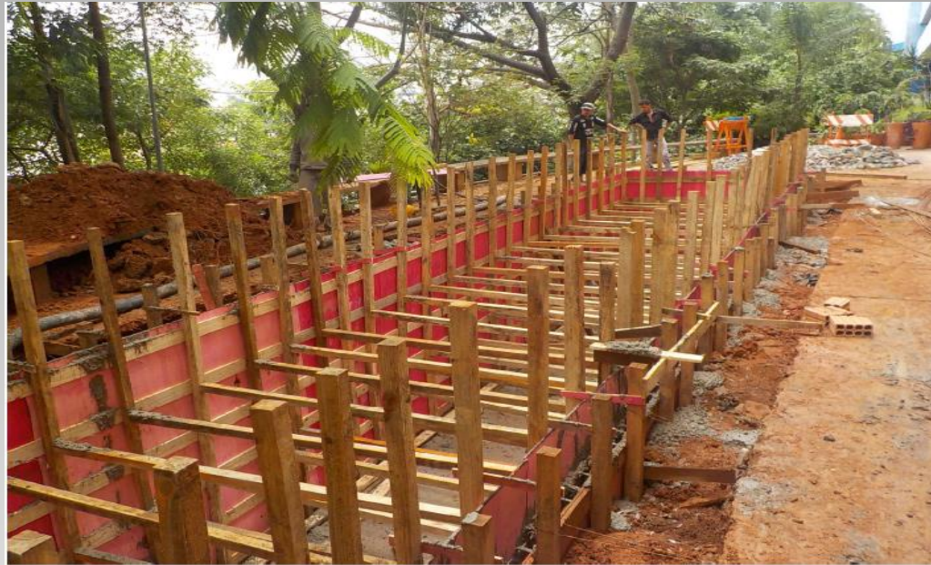
Reservatório de Água
