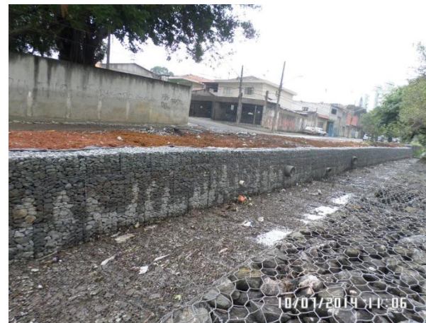
Estanislau Bonk Filho (Aricanduva / VI. Formosa): Execução de gabião h=0,50cm na margem direita.
