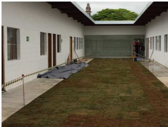
Canteiro de obra
